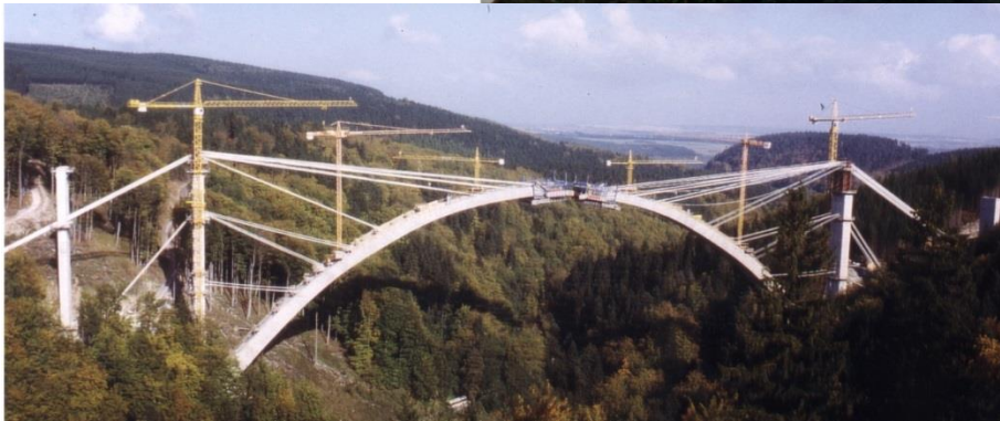
Bridge „Wilde Gera“
