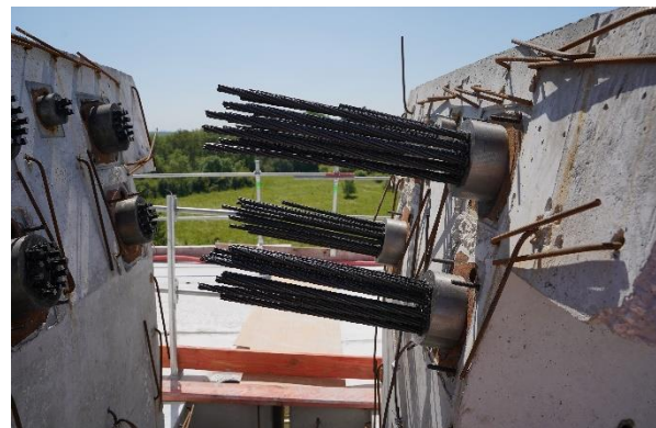
Abbildung 5: Fertigsegmente des Bauabschnitts und vorgespannte Zugseile
