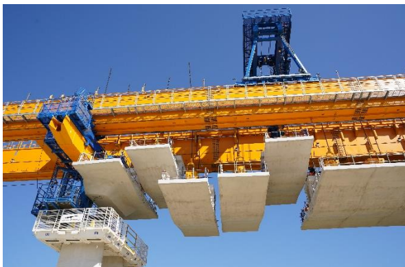
Abbildung 5: Fertigsegmente des Bauabschnitts und vorgespannte Zugseile
