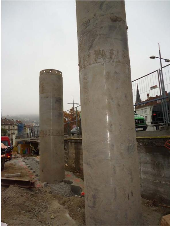
Bild 6: Bohrschablone und Verrohrung „Das Gerber“
