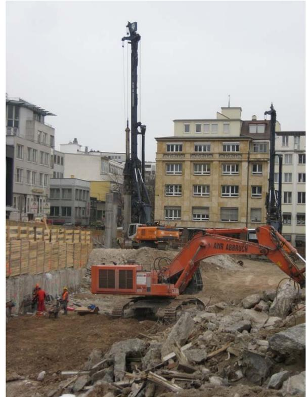
Bild 7: Bohrpfahl- und Abbrucharbeiten „Das Gerber“
