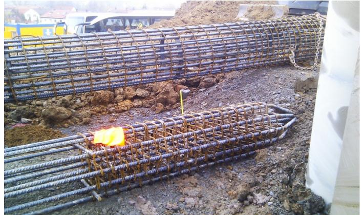
Bild 4: Bewehrung im oberen Pfahlabschnitt
