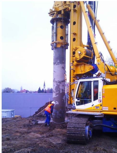
Bild 5: Bohrgerät BG 28, Fa. Bauer
