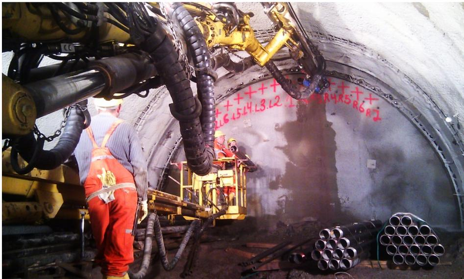
Bild 7: Herstellung des Rohrschirms an der Tunnelfirste
