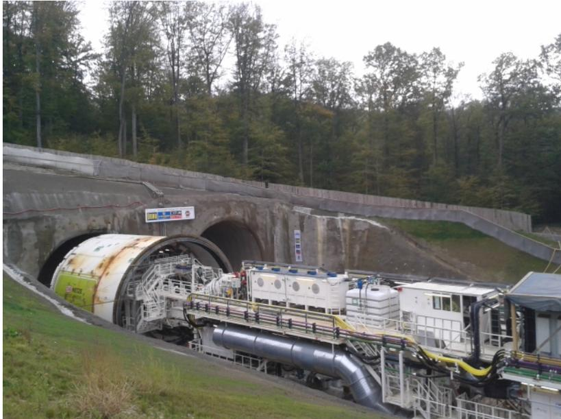
Bild 14: Tunnelvortriebsmaschine im Anfahrbereich
