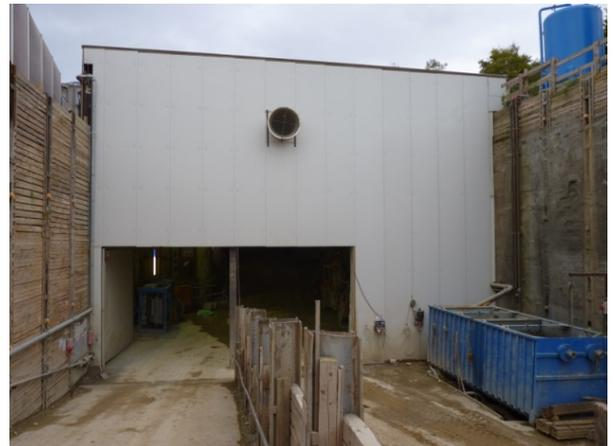
Bild 8: Anfahrtgrube mit Lärmschutzeinhausung
