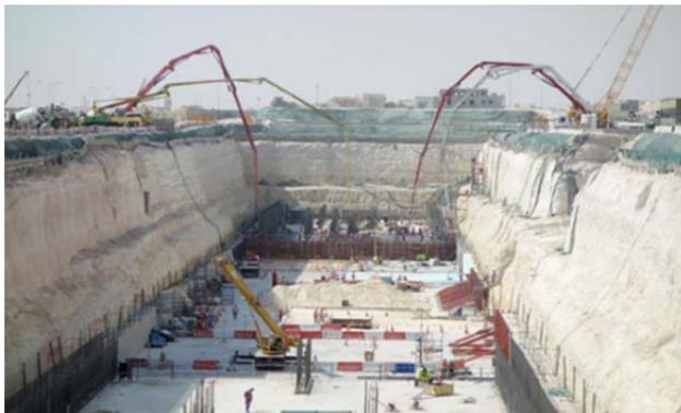
Bild 8: Blick in die Baugrube für Education City Station, Betonage der Bodenplatte
