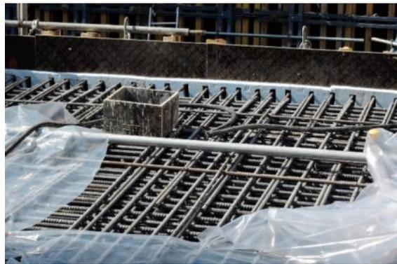
Bild 6: Hohe Bewehrungsgrade der Bodenplatte
