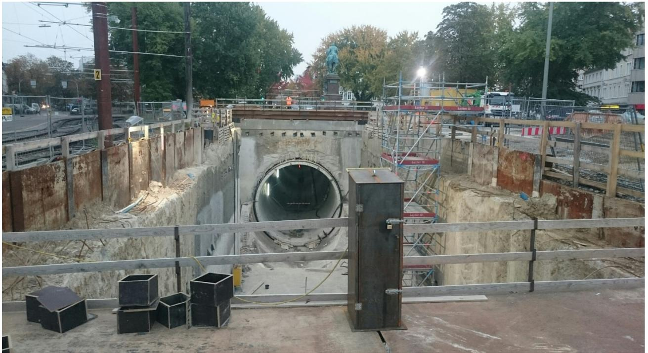
Bild 10: Zielbaugrube der Tunnelbohrmaschine
