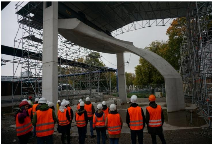
Bild 7: Probeteilelement einer Trichterstütze
