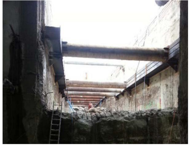
Bild 12: Durchbruch Schlitzwand
