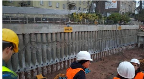
Bild 12: Pfahlwand Südkopf
