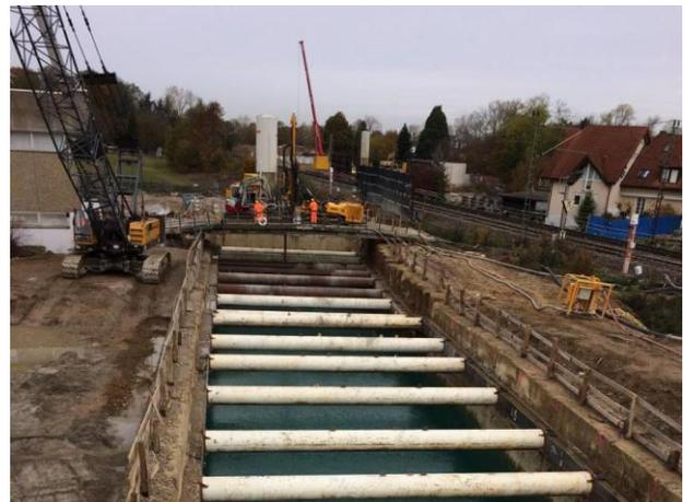
Bild 16: Ausgesteifte Baugrube
