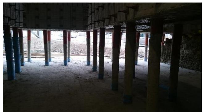
**Bild 7:** Unterfangung Bundesbahndirektion
