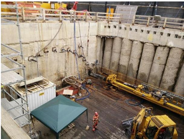
Bild 15: Herstellung Vereisungsbohrungen
