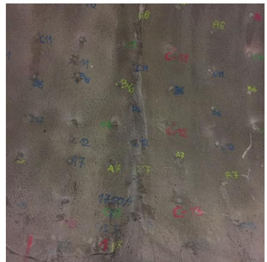
Bild 17: Markierungen der geplanten Injektionen
