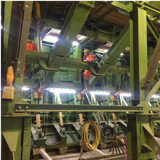
Bild 15: Schalwagen zur Herstellung von Innenschalen
