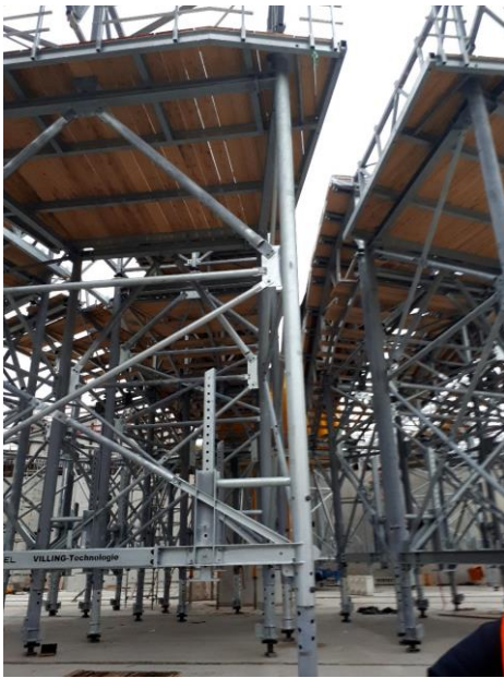
Bild 9: Schalungselemente für die Kelchblätter
