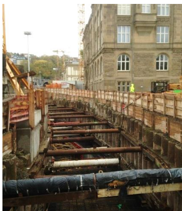
Bild 23: Blick über die Baustelle
