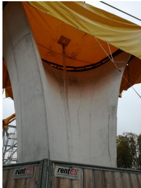
Bild 10: fertig betonierter Kelchfuß
