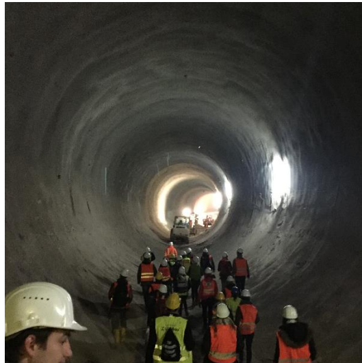
Bild 16: Mit Spritzbeton stabilisiertes Rohgewölbe
