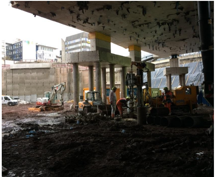
Bild 8: Abstützung der DB Direktion
