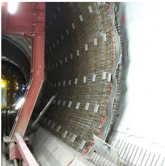
Bild 18: Bewehrtes Innenschalelement
