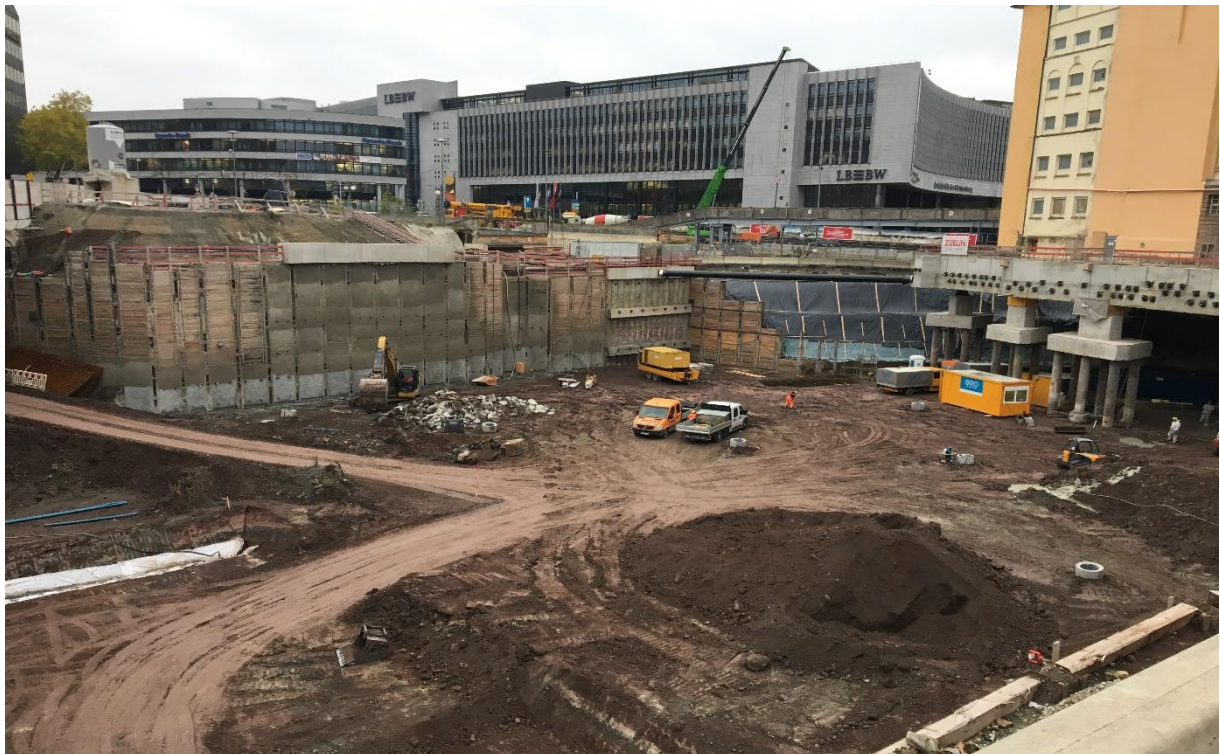
Bild 2: Baugrube des unterirdischen Bahnhofs
