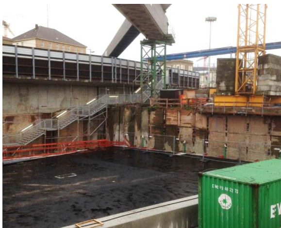
Bild 21: Südlich der neuen Haltestelle: Blick auf die Gummimatten
