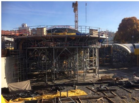
Bild 8: Eingeschalte Kelchstütze
