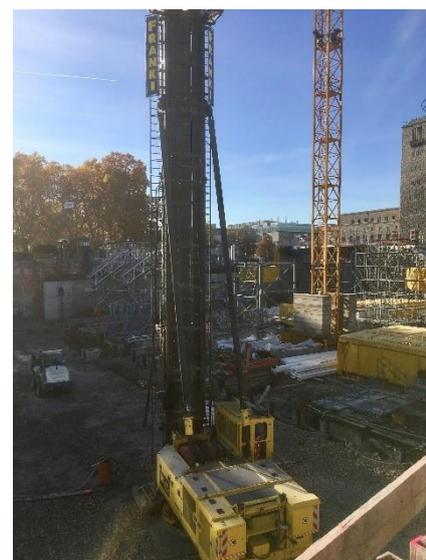
Bild 11: Herstellung eines Ort-betonrammpfahls mit Franki-Pfahlramme
