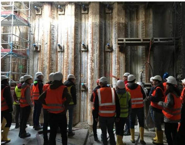
Bild 4: Rückverankerte Spundwand am Ende eines Bauabschnitts
