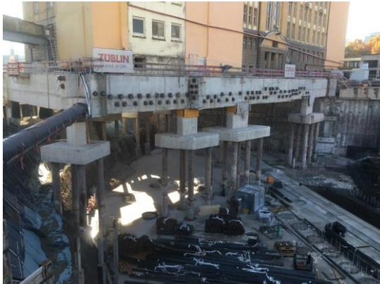
Bild 9: Abfangungskonstruktion unter der ehemaligen Bahndirektion
