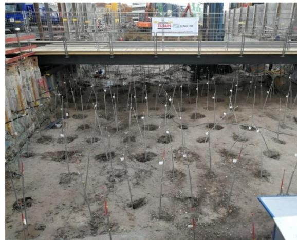
Bild 5: Gebohrte Lanzen für anschließende Weichgel-Injektionen
