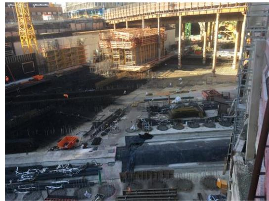
Bild 10: Bodenplatte und Abdeckung der U-Bahn-Tunnelröhre
