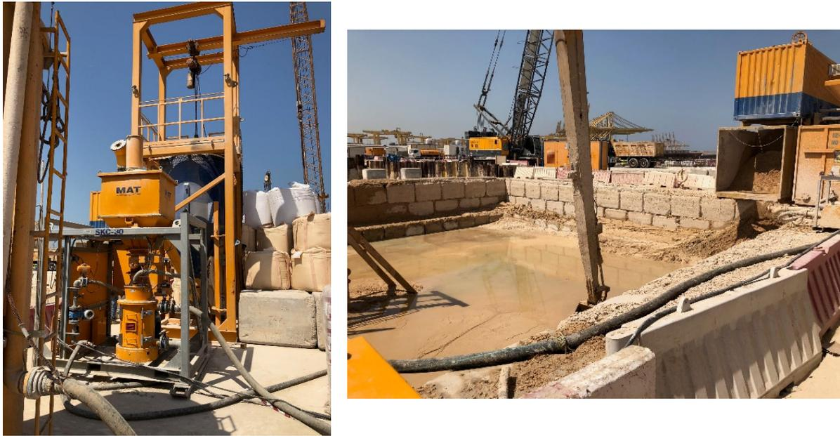
*Bild 12: Silo zur Aufbereitung der Bentonitsuspension (links) und Absetzbecken Rücklauf (rechts)*
