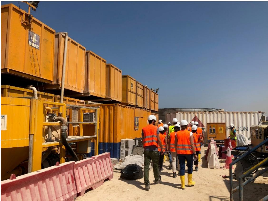
*Bild 11: Container für die Lagerung der einsatzbereiten Schlitzwandsuspension*
