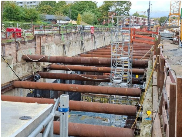
Abbildung 12: Komplexe Verbauarbeiten für die Tunnelherstellung in offener Bauweise
