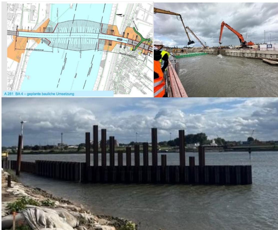
Abbildung 8: Übersichtsplan des Projekts (DEGES GmbH) (oben links), Unterwasseraushub einer Baugrube (oben recht) und Bau einer kombinierten Spundwand mit Blick auf die andere Uferseite (unten)
