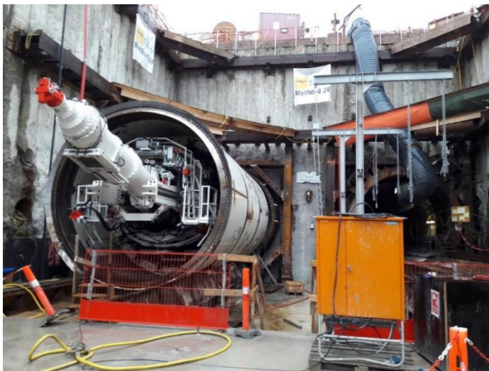
Bild 7: Vorderer Teil der Erddruck-TBM
