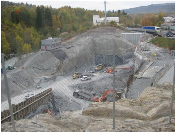
Bild 21: Übersicht der Baugrube
