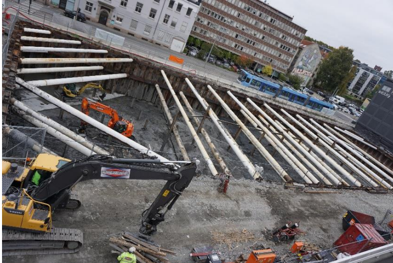
Bild 18: Spundwandverbau mit Steifen
