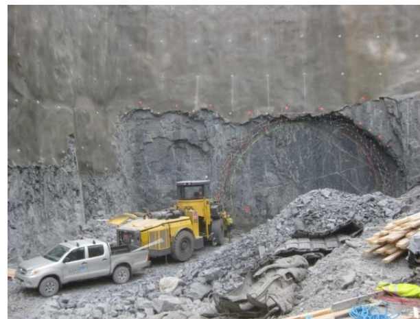
Bild 26: Geplanter Durchbruch auf der gegenüberliegenden Seite
