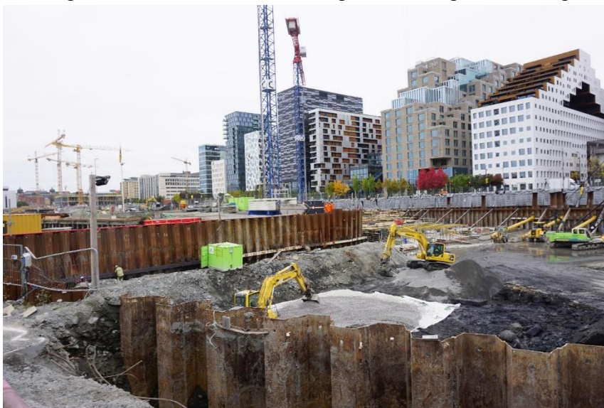
Bild 19: Baugrube für ein Einkaufszentrum
