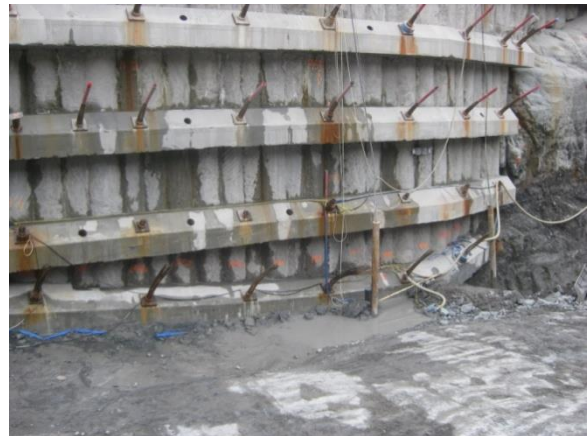
Bild 24: Unterste (ungeplante) Ankerlage
