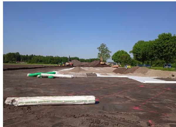
**Abbildung: Einbau Geokunststoff am Versuchsfeld in Kolbermoor**
