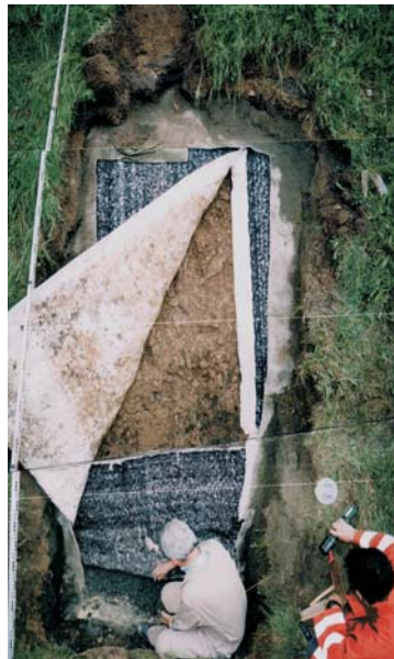
Probennahme einer GTD aus einer Straßen-Böschung GCL-sampling of a road sloap
