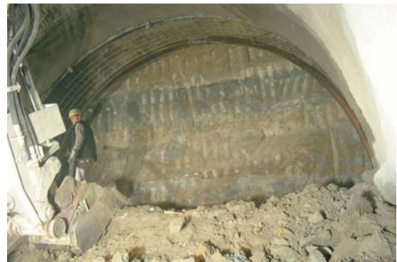
Bergmännischer Vortrieb der U-Bahn-Röhre unter Tage im Stadtbereich Garching
