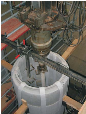
Belastungsversuch eines ungestützten Pfahles Load test of an unsupported pile
