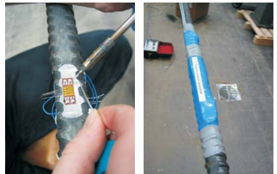
Applizierung von Dehnungsmessstreifen alle 1,0 m am Stahltragglied eines Mikropfahls Application of strain gauges at a micropile's steel rod every 1,0 m
