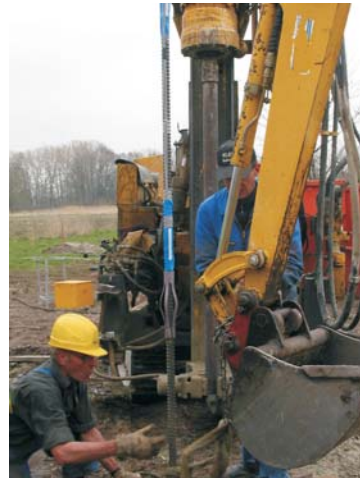
Einführung eines mit Dehnungsmessstreifen bestücktem Stabstahl in das Bohrloch Leading a steel rod applied with strain gauges into a bored hole
