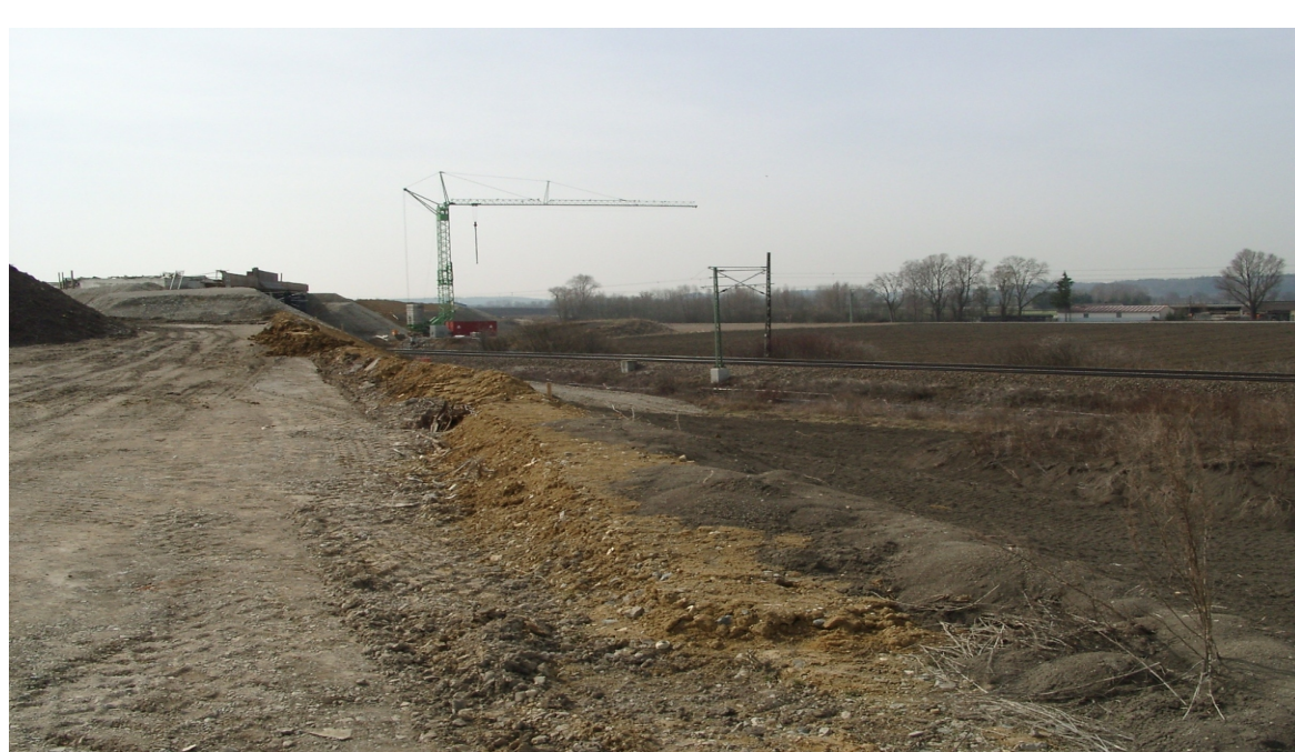
Einbau von Recycling-Material in einen Dammkern Emplacement of recycling-material in the center of a road embankment
