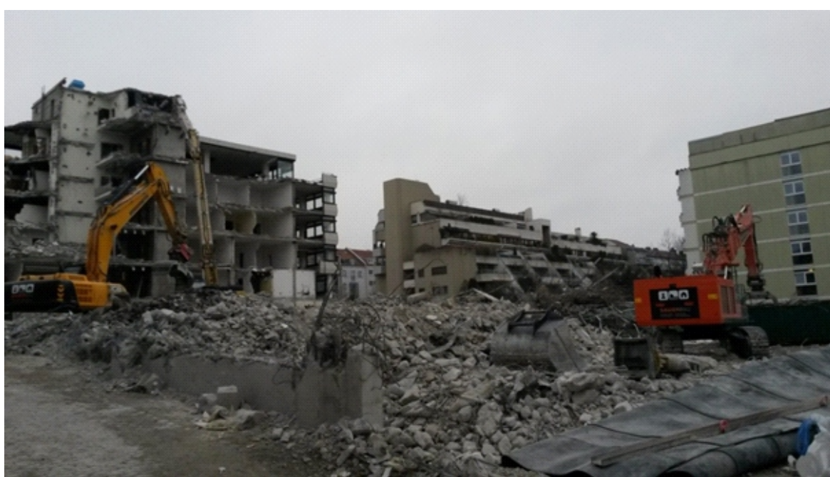
Rückbau eines Wohngebäudes Deconstruction of a residential building
