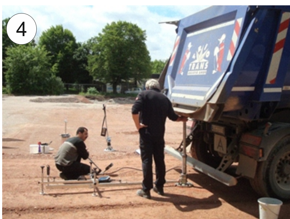
Verdichtungskontrolle an RC-Mix compaction control of RC-Mix
