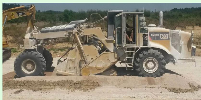
**Zusammenfassung** Die Verbesserung weicher, feinkörniger Böden ist in gewissen Konsistenzbereichen durch Zumischung von trockenem Recyclingmaterial der Körnung 0/4 mm möglich. Abhängig von der Zugabemenge des Recyclingmaterials können leicht plastische Tone so bis weit über ihren optimalen Wassergehalt erdbautechnisch verarbeitbar gemacht werden.
