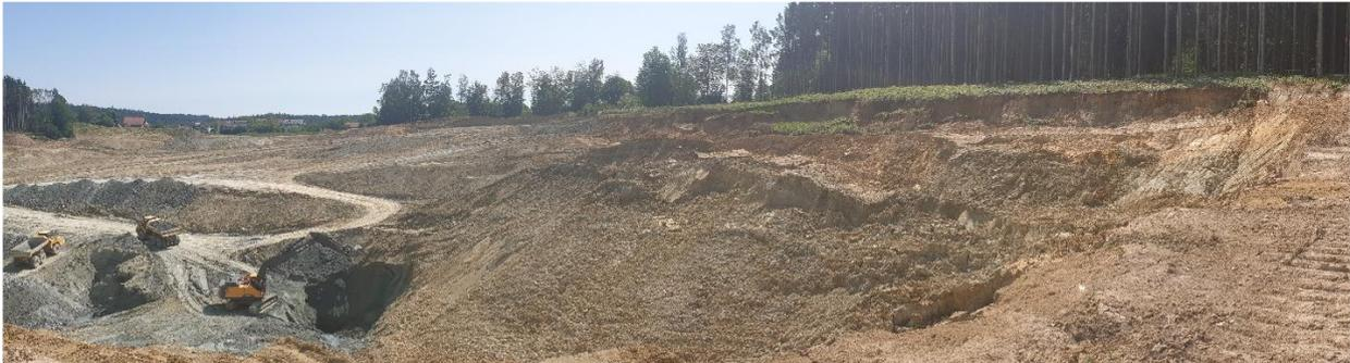
**Abbildung 6.22: Böschungsrutschung in der Tongrube**
