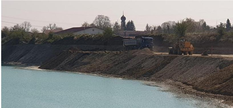
**Abbildung 6.13: Herstellung einer Teilverfüllung im Nassabbau**
