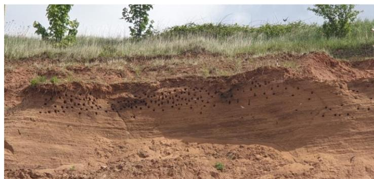
Abbildung 5.4: Abschnittsweise nahezu vertikal stehende Böschung in einer Sandgrube (grSa,  $\varphi' = 35^\circ$ ,  $c' = 0$  kPa), Standzeit  $> 10$  a
