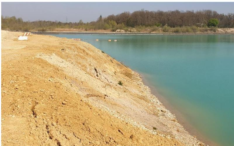
**Abbildung 6.14: Material einer angekippten Böschung**
