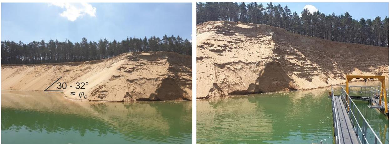
**Abbildung 6.45: Böschungsneigung über Wasser: (links) letzte Abbauaktivität ca. 6 Monate oder länger zurückliegend, (rechts) Böschung kürzlich abgebaut**
