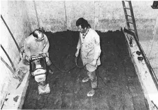
Bild 4 Einbau des Bodens mit Vibrationsstamper
