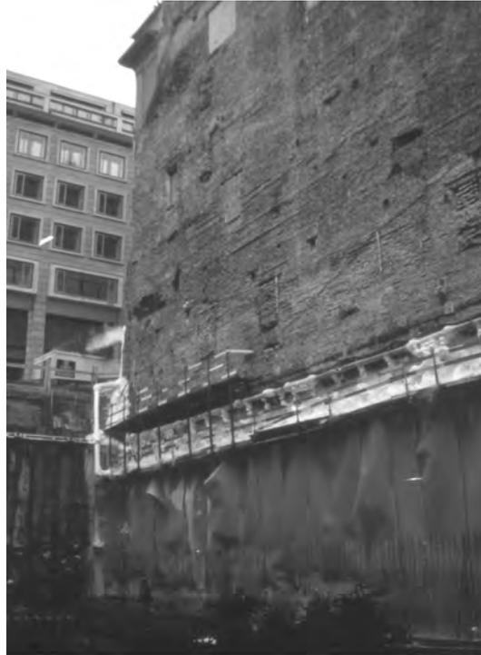
*Bild 6: Vereisungswand mit Wärmedämmung beim Bewehren der Kellerwand*
