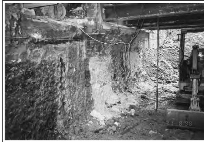
*Bild 5: Entfernen des Überprofils*
