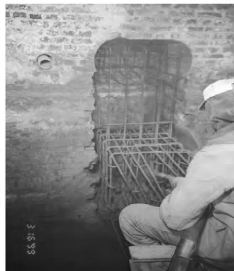
Bild 8: a) Abfangung Außenwände, b) Mauerwerksnische während des Betonierens
