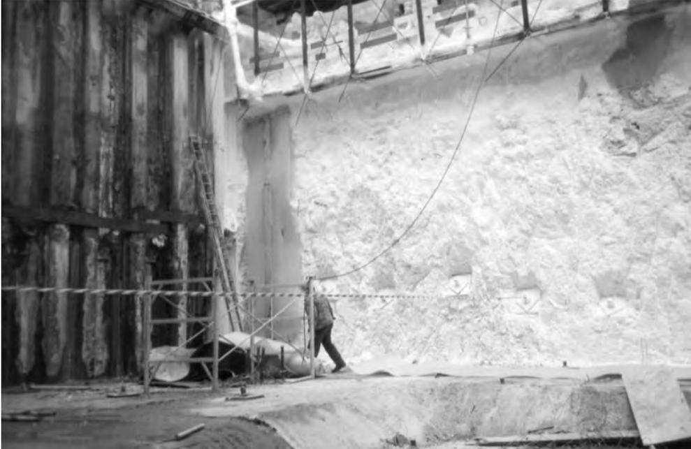
*Bild 5: Vereiste Baugrubenwand nach dem Aushub*
