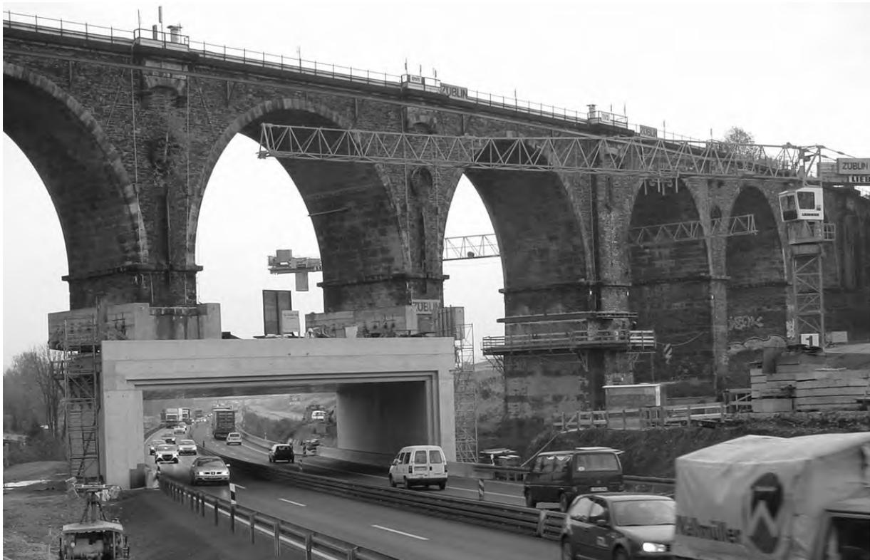
*Bild 16: Hergestelltes Abfangbauwerk zwischen Pfeiler 70 und 80*
