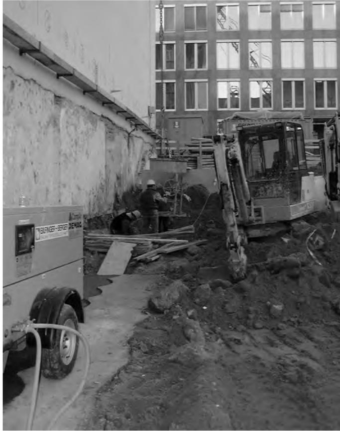
*Bild 5: Handunterfangung (Beton)*
