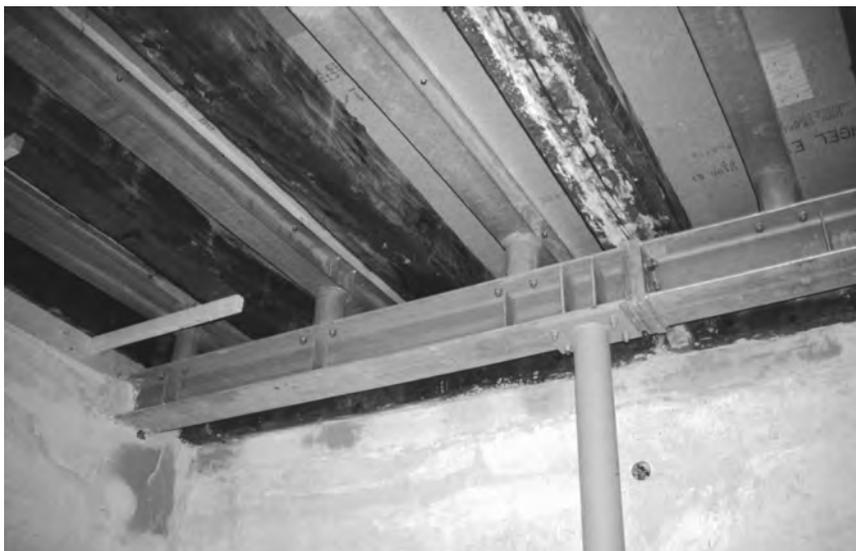
*Bild 3: Stahlträgerkonstruktion in den Gefachen der Holzbalkendecke zur Aufnahme der hohen Lasten*
