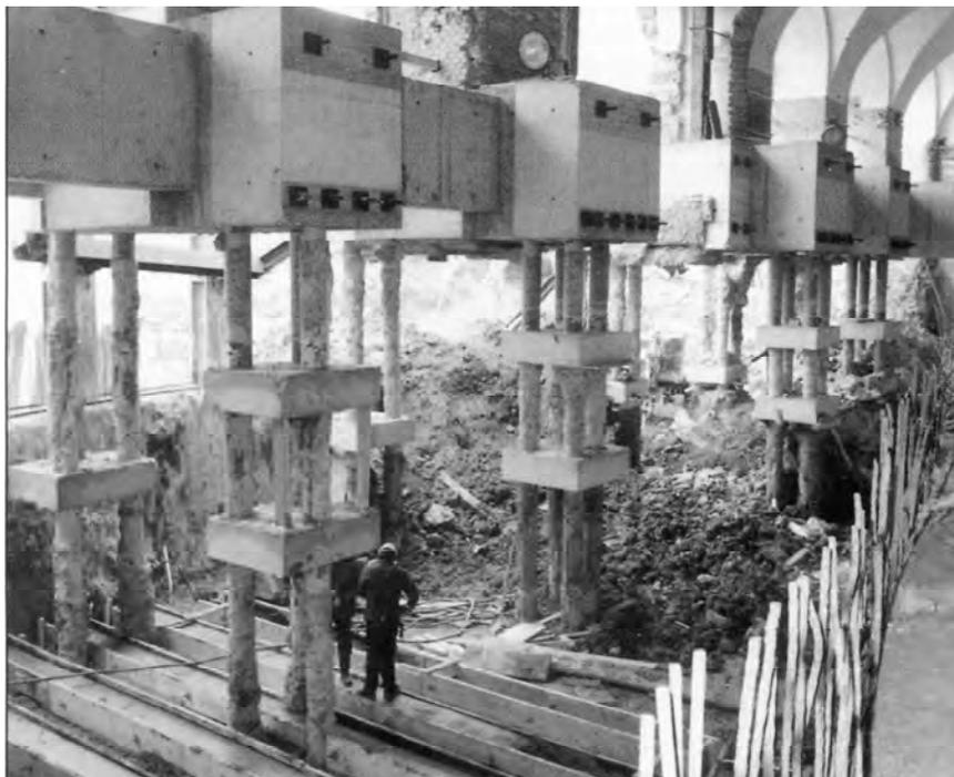
*Bild 6: Knickhaltung bei freigelegten Kleinbohrpfählen (U3 Volkstheater, Wien)*
