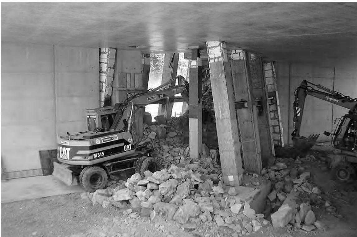
*Bild 15: Abbruch Pfeilerrestquerschnitt*
