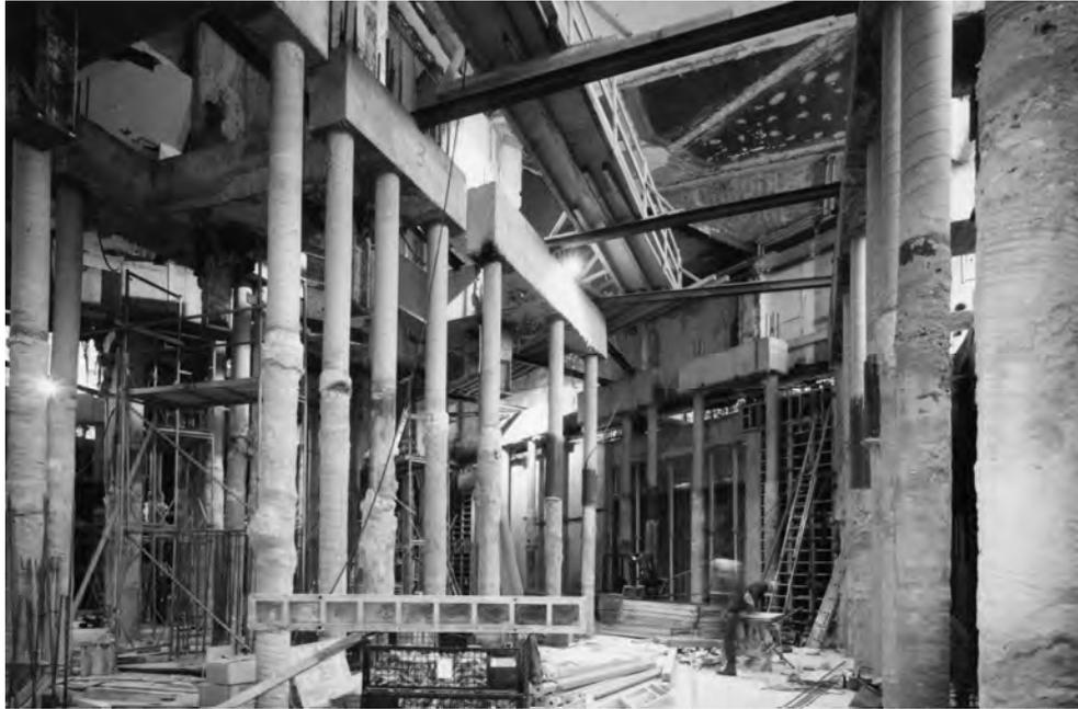
*Bild 13: Freigelegte Kleinbohrpfähle im Kellergeschoss*
