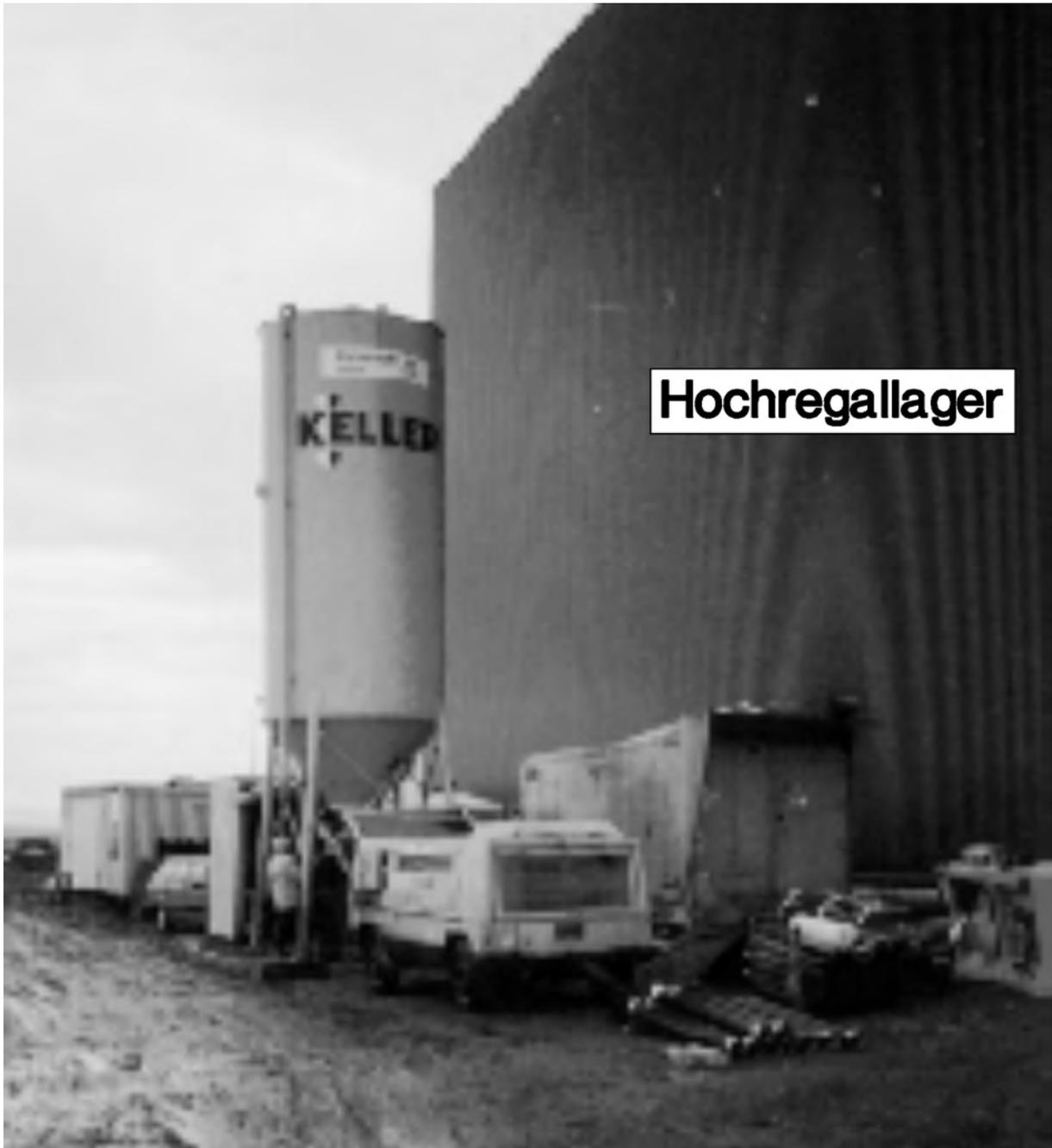
*Bild 8: Einpressanlage*
