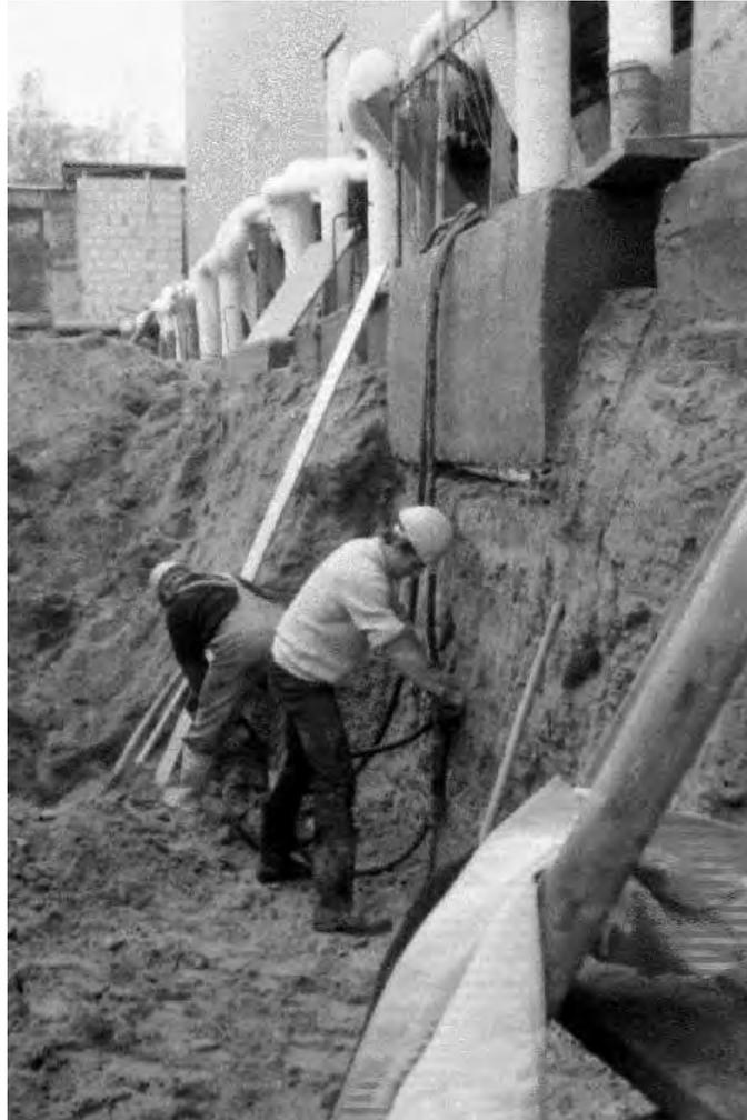
*Bild 4: Aushub unter Hallenfundamenten im Schutze einer Frostwand*
