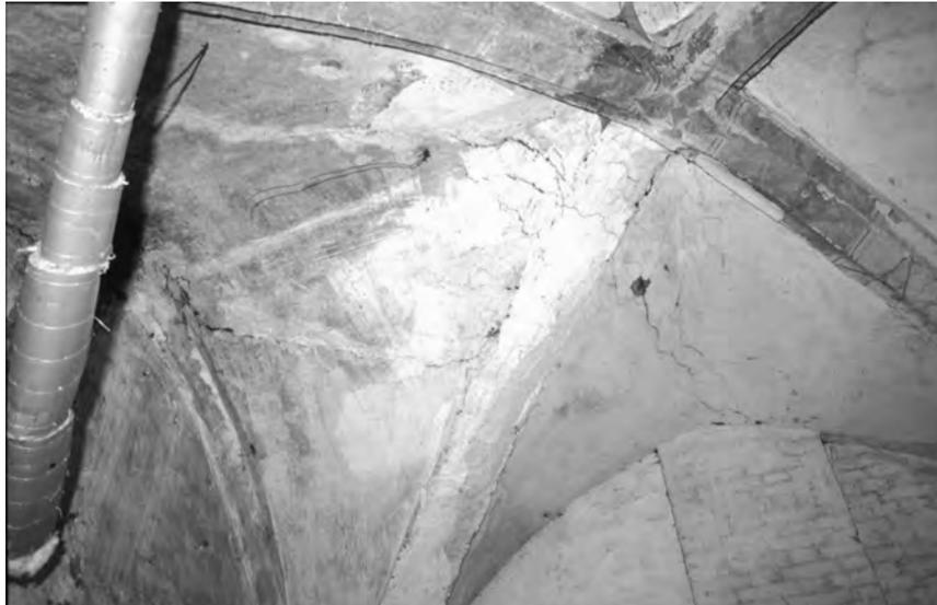
*Bild 2: Gewölbekappe mit deutlichen Verformungen und Risssschäden*
