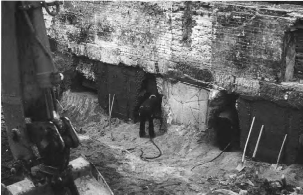
*Bild 6: Handunterfangung (Freilegung)*
