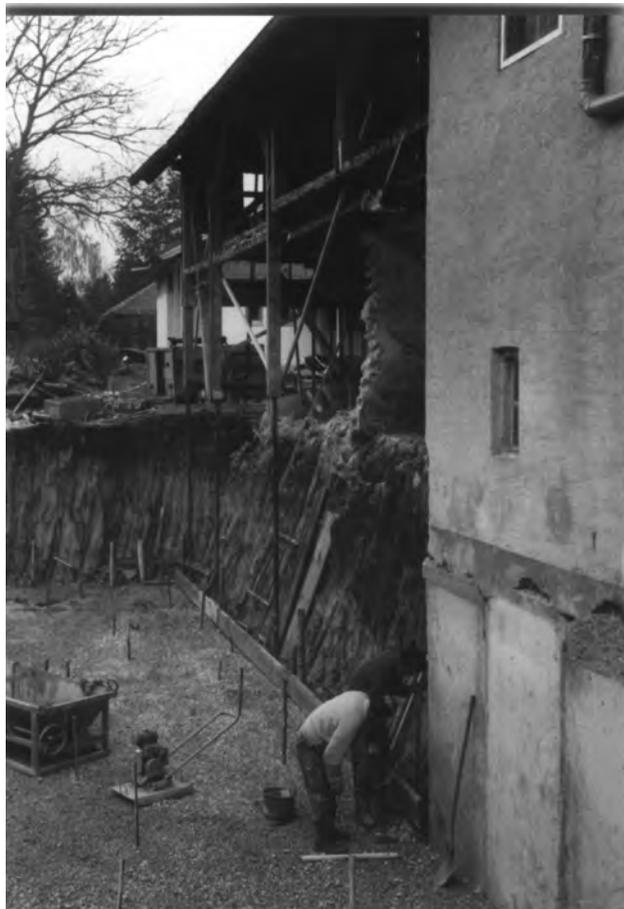
*Bild 24: Unterfangungsarbeiten, bei denen die Beschäftigten in höchstem Maße gefährdet sind*
