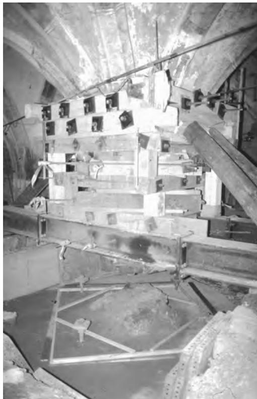
*Bild 6: Abfangkonstruktion für den Ziegelpfeiler mit Blick in die Baugrube für das neue Pfeilerfundament*
