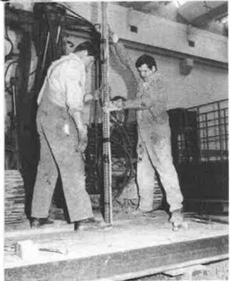
Bild 5.2 Pfahlherstellung in der Versuchsgrube/Versuchshalle des Prüfamts Endlosschnecke beim Ziehen Einführung des Bewehrungsstahls GEWI Ø 50 mm
