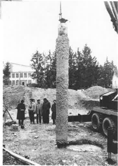
Bild 7.20 Photos vom Versuchsaufbau und dem nach Versuchsende herausgezogenen Pfahl
