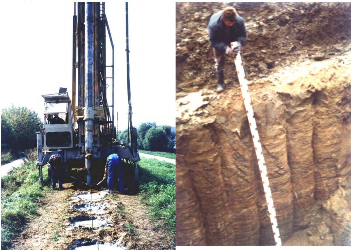
Bild 22: Herstellung der DMM-Säulen und zur Kontrolle freigelegte Säulen am Weichseldeich
