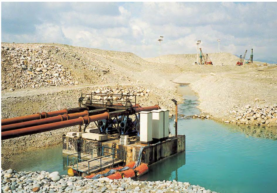
*Bild 19: Offene WH - Drainagegraben + Pumpenschiff*
