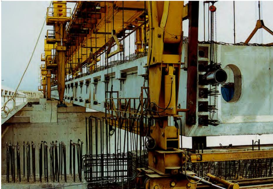
*Bild 13: Montage Fertigteilbrücke*
