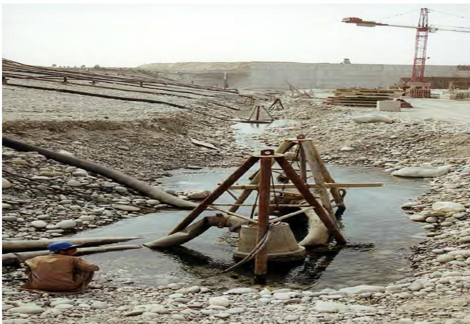
Bild 24: Offene WH mit Pumpensümpfen
