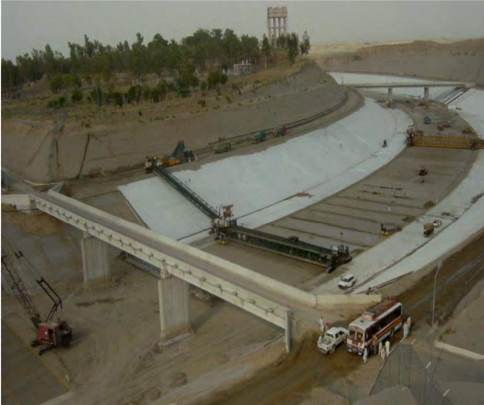
*Bild 10: Beton - Lining*
