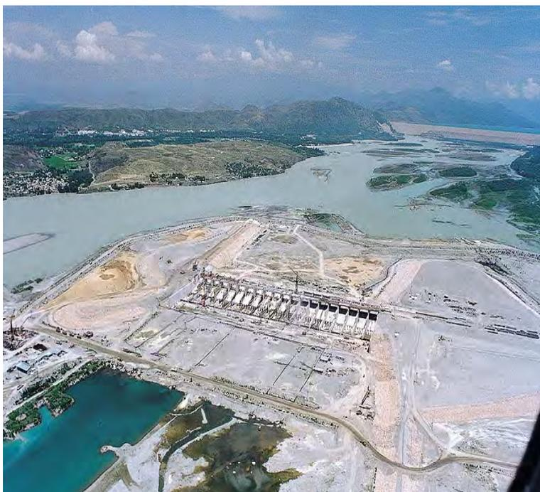
Bild 6: Bauzustand 1: Umschließungs-damm und Wehr
