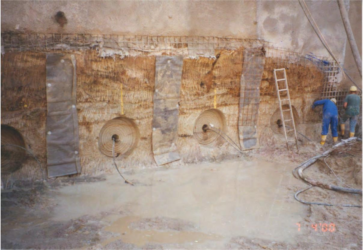
Bild 5: Einbau vertikaler Dränelemente
