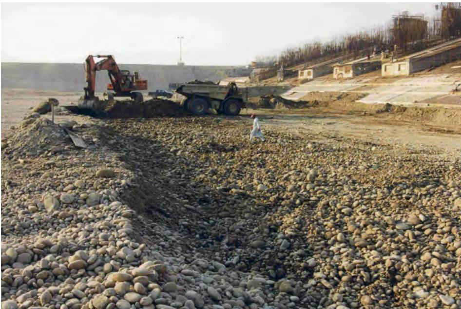
*Bild 18: Zone großer Durchlässigkeit in der Baugrubensohle Wehrbaugrube*
