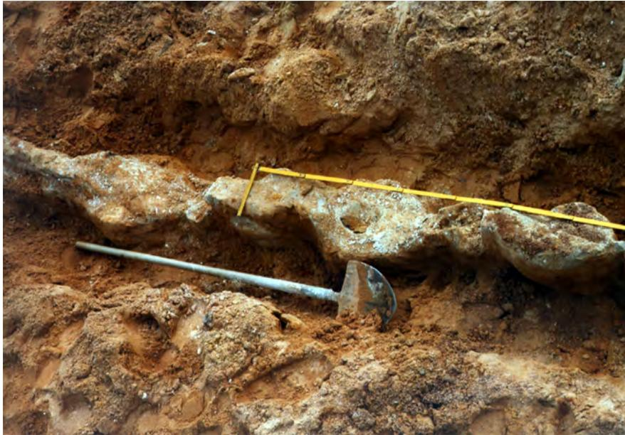
*Bild 15: Freigelegter Kopf der Schmalwand*
