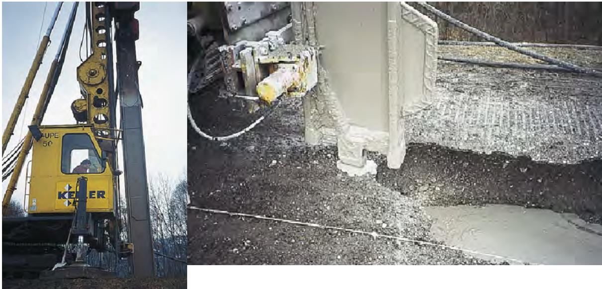
*Bild 20: Trägergerät und Rüttelbohle mit Schneide und einseitigem Flügel*
