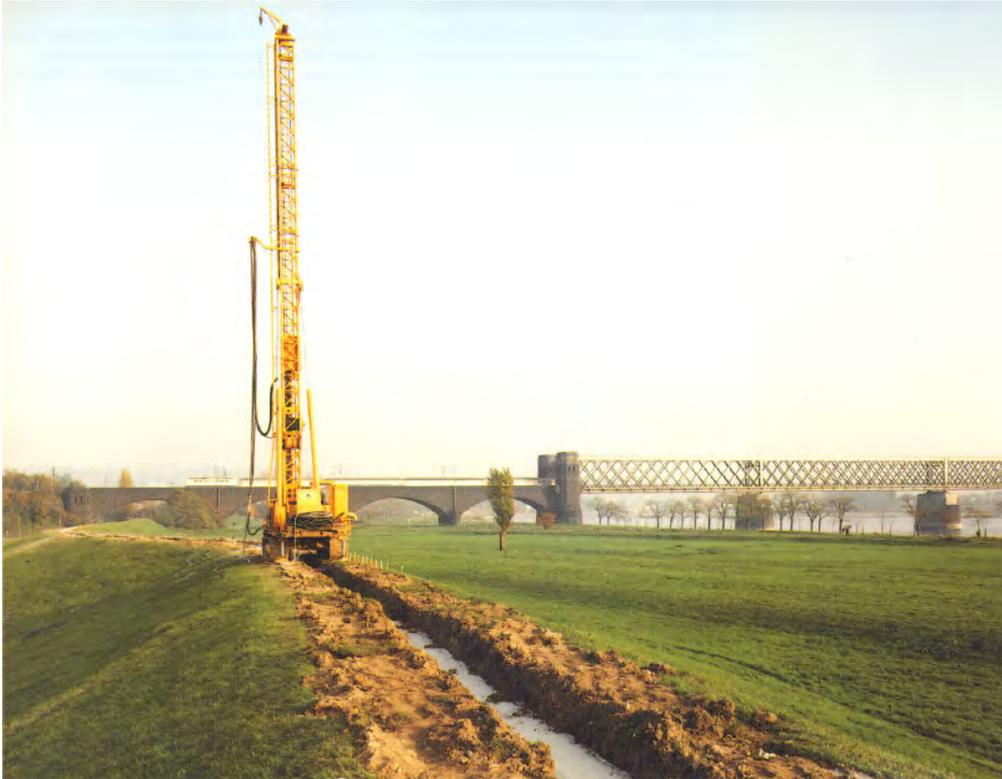
*Bild 12: Rheindeich bei Neuwied mit Suspensionsgraben während der Herstellung der Rüttelschmalwand*
