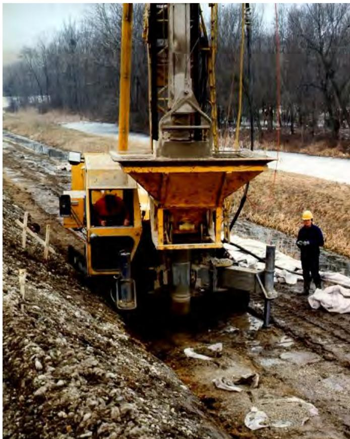
Bild 17: Herstellung der vliesummantelten Kiesstopfsäulen als Drainage
