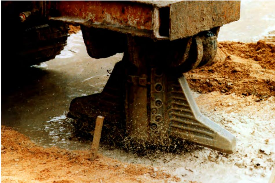
Bild 14: Flügelrüttler vor dem Eintauchen in den Boden
