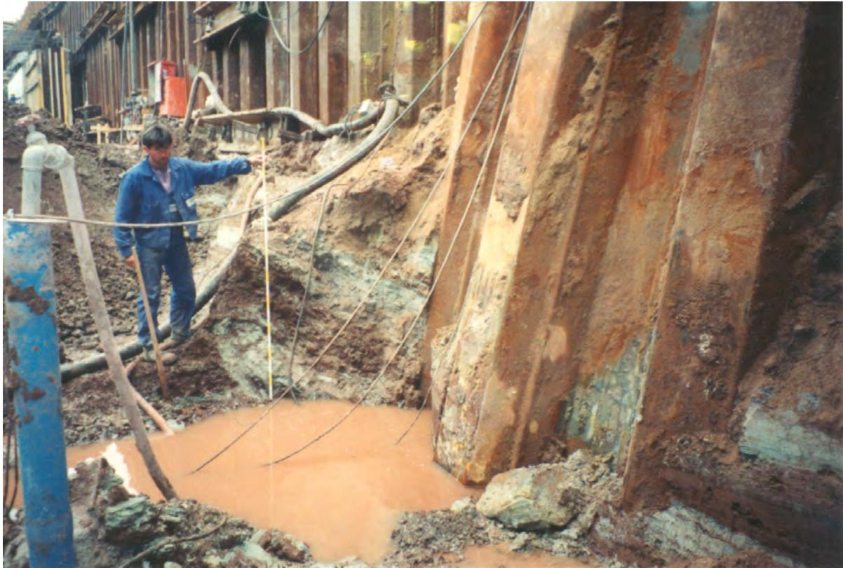
*Bild 3: Horizontalverschiebung am Spundwandfuß - Versagen des Fußauflagers*
