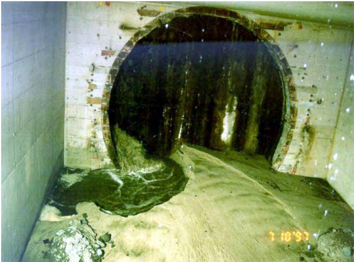
*Bild 1: Undichtigkeiten an der Brillenwand in einem Senkkasten*
