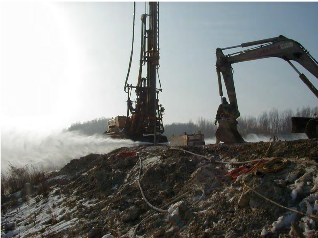
*Bild 31: Bohrgerät für die Herstellung der Soilcrete®-Lamellen*
