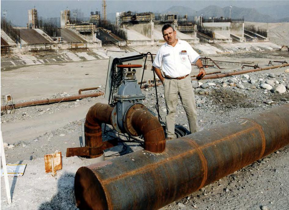
*Bild 25: Bohrbrunnen, Pumpleistung 100 l/sec.*
