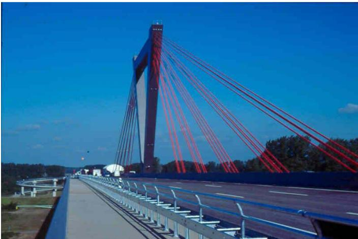
*Blick auf einer der Y-förmigen Pylone und die flach geneigten Spannseile, im Hintergrund die Radwegspindel*
