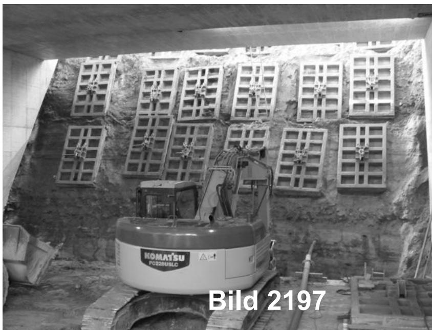
*Bild 13 Rückbau der Böschungssicherung im Unteren Bereich des Rahmens*
