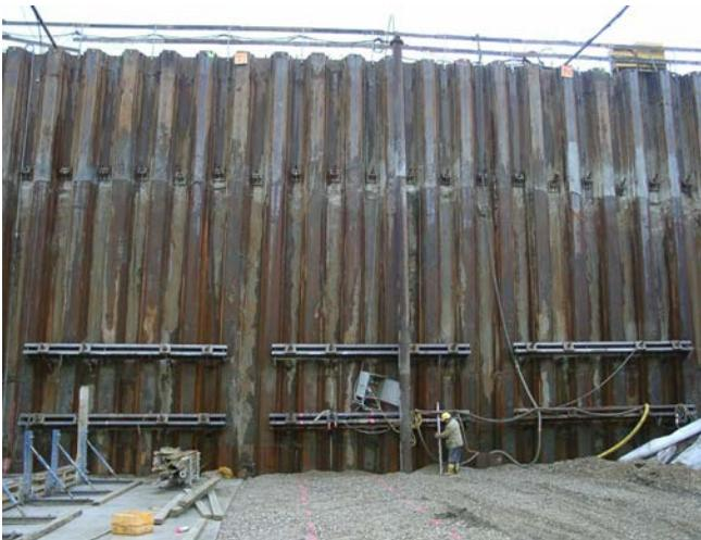
*Ansicht der Spundwand im Tunnel Rheinschlinge bereits mit eingebrachter Drainageschicht und Markierung der Sohlnocke*
