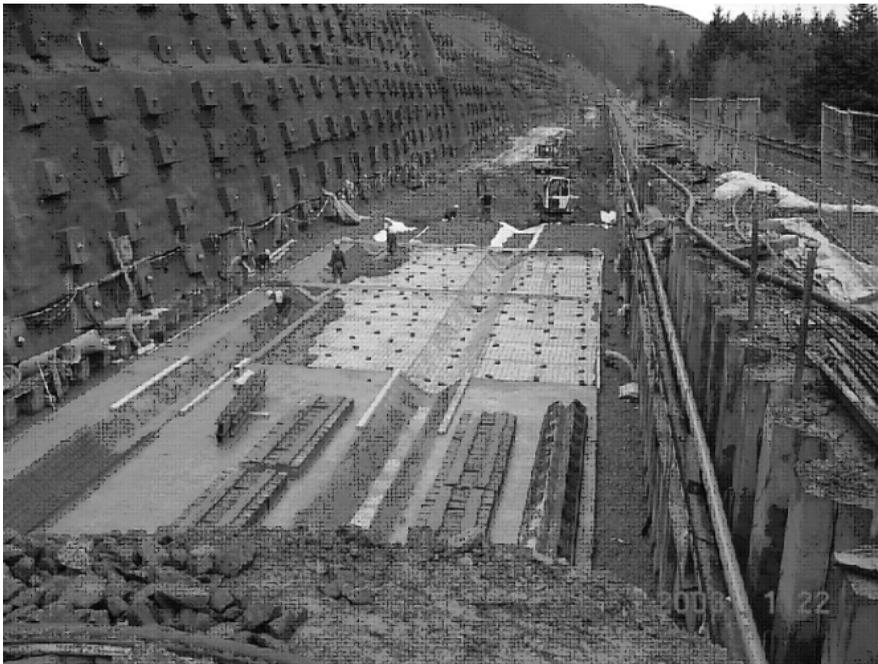
*Bild 18: Herstellung der Schubnocken (Unterbau)*
