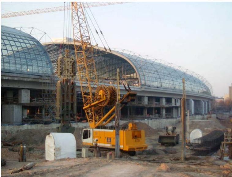
Abb. 24: Hydraulikgreifer vor dem Glasdach des neuen Bahnhofes
