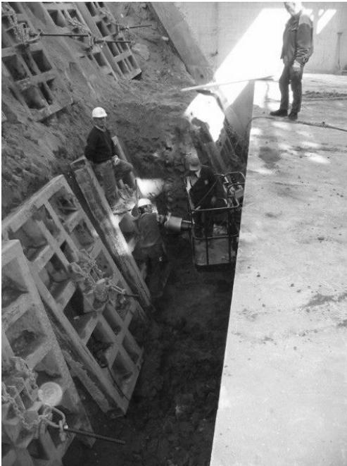
*Bild 12 Umsetzen der Ankerplatten*
