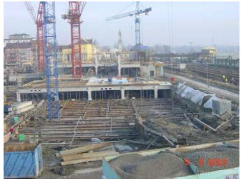
Bild 10: links: Verkeilen einer Unterbeton-Fertigteile-Steife; rechts: „Linienbaustelle“ mit Herstellung der Baugrube im Süden (vorne) bei Beginn des 1. OG's im Norden
