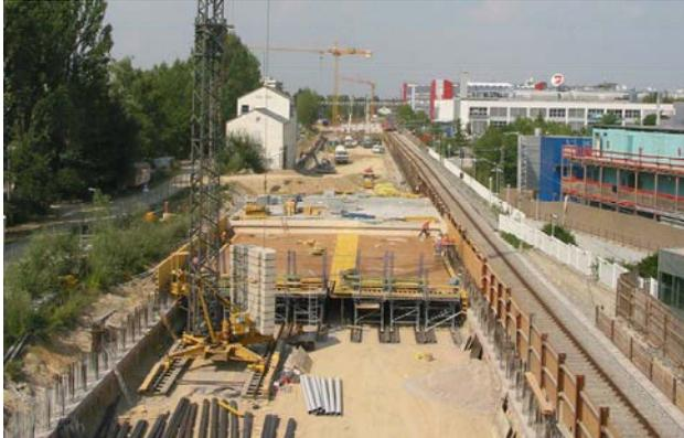
*Bild 1: Herstellung der ersten Tunneldeckel, Juli 2003*
