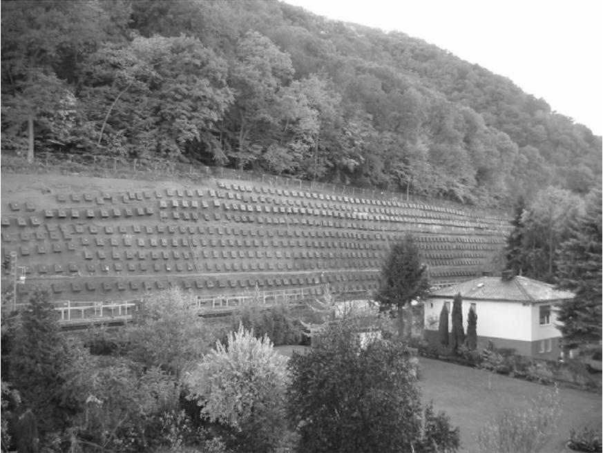
*Bild 9: fertig gestellte verankerte Spritzbetonschale für den Hanganschnitt*
