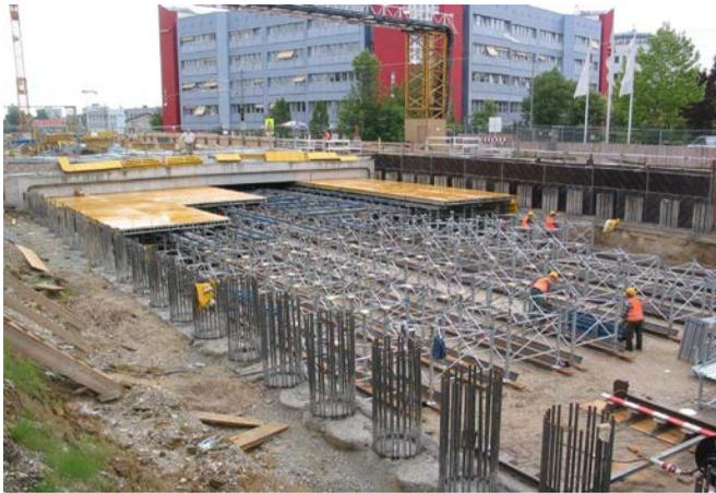
Bild 3b: Modifizierte Deckelbauweise, Aufbau Rüstung und Schalung
