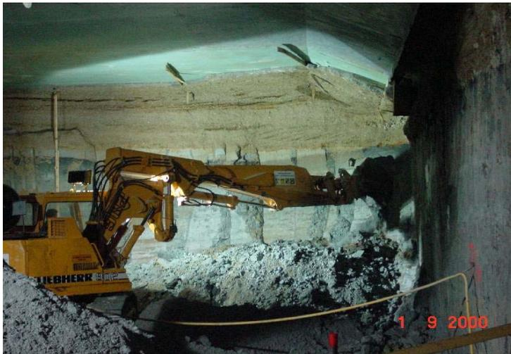
*Bild 11: Phase 4 der Deckelbauweise unter Druckluft Aushub unter dem Deckel (mit Druckluft)*
