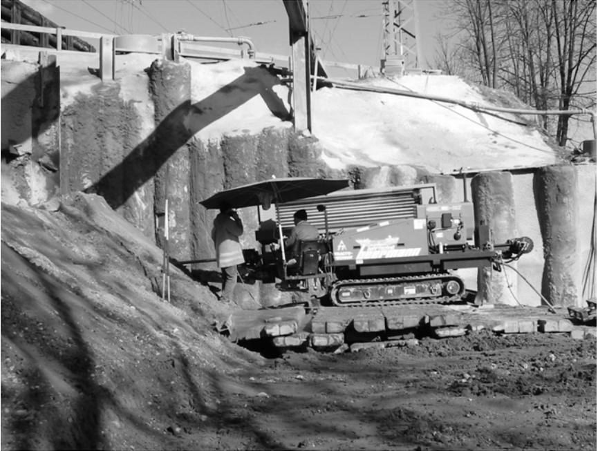
*Bild 9 Horizontalbohrung für Anker*
