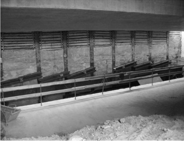
*Bild 6 Alte Verbauwand zur Aufnahme der Anker*
