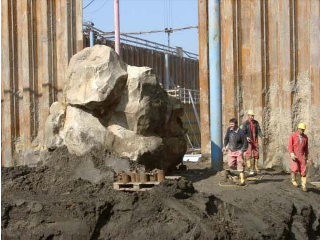
*Einer der während der Aushubarbeiten freigelegten Findlinge, die die Spundwandeinbringung erschwert haben*
