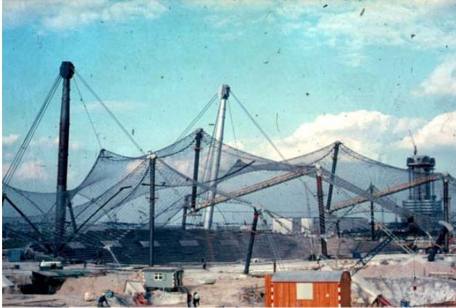
Bild 24: Ansicht des Zeltdaches am Stadion (Bauzustand)
