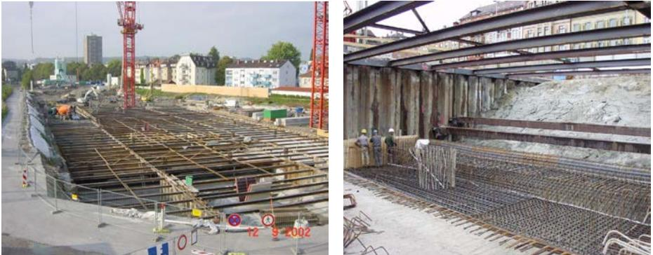
*Bild 8: links: Tiefer Teil nach Herstellung der ersten Teilbaugruben bis Bauphase 9; rechts: mittlere Startbaugrube (Bild 7) mit Steifen über der Böschung und gerade bewehrter Voute im Pfahlbereich*
