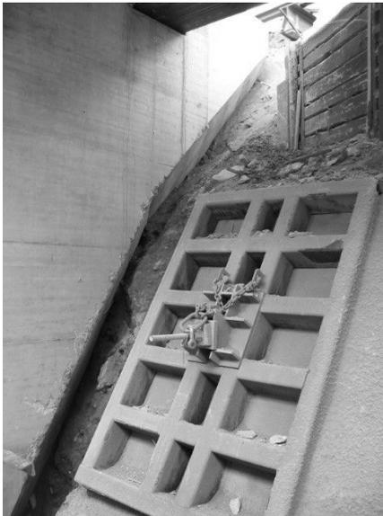
*Bild 8 Eingebaute umsetzbare Ankerplatte*
