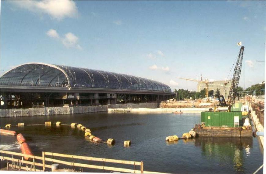
Abb. 25 : Blick in die Baugrube B-Ost – Nassbaggerarbeiten (Sommer 2003)
