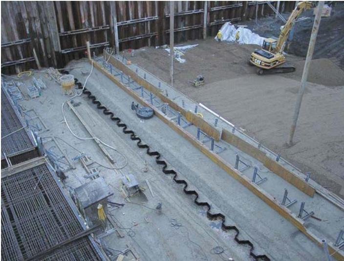
*Querschott in der Bodenplatte zwischen zwei Teilbaugruben*
