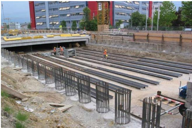
*Bild 3a: Modifizierte Deckelbauweise, Spundwandbohlen auf Sandbett*
