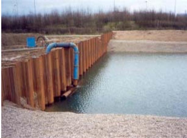
*Wiederversickerung des gelenzten Restwassers aus den Baugruben im Sickerbecken Rheinschlinge*
