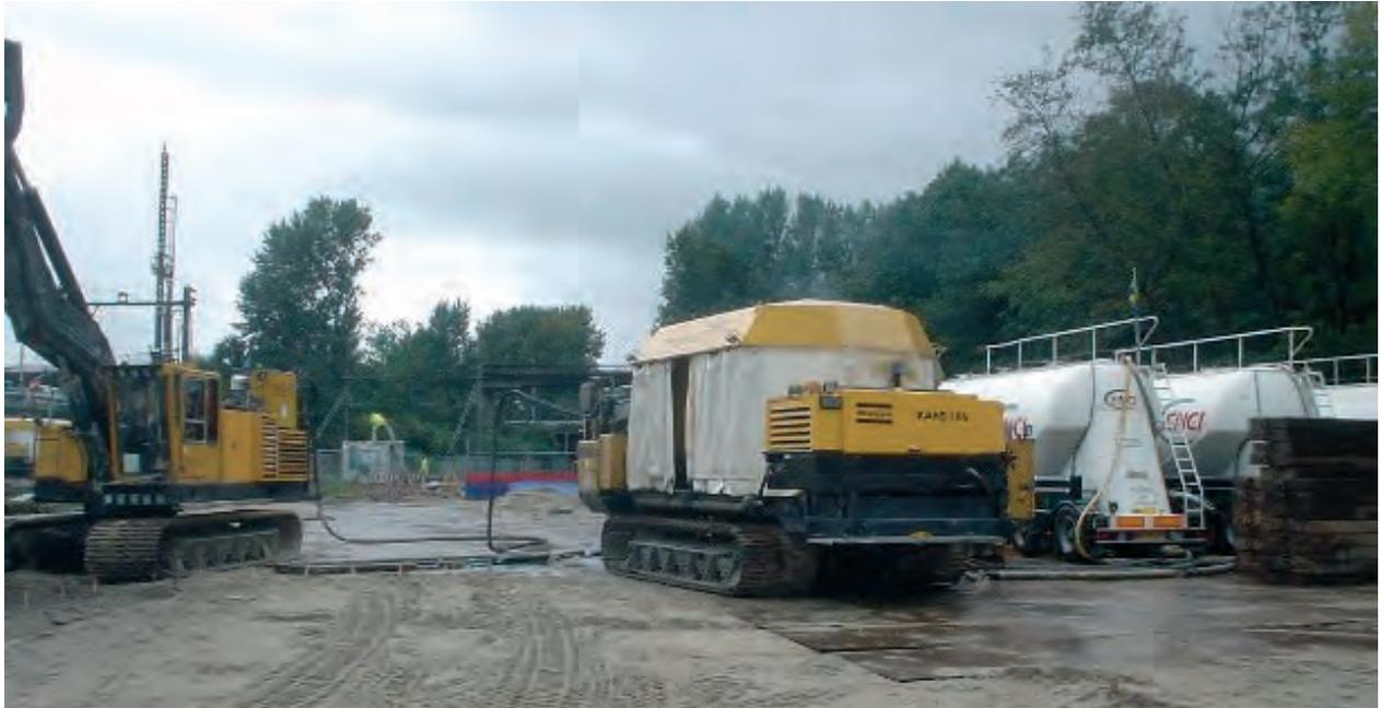
*Bild 16: Trägergerät, Mobile Mischanlage, Zementauflieger*
