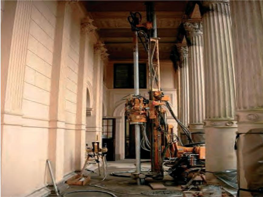
*Bild 13: Herstellung von Kellersäulen durch die Lichtöffnungen im Säulengang*
