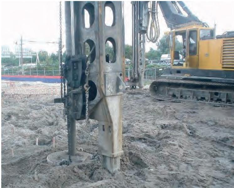
*Bild 14: Herstellung von Kalkzementsäulen*
