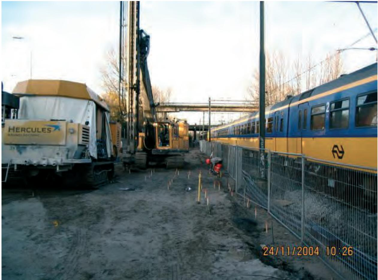
*Bild 17: Herstellung von Kalkzementsäulen direkt neben der Goudse Lijn*
