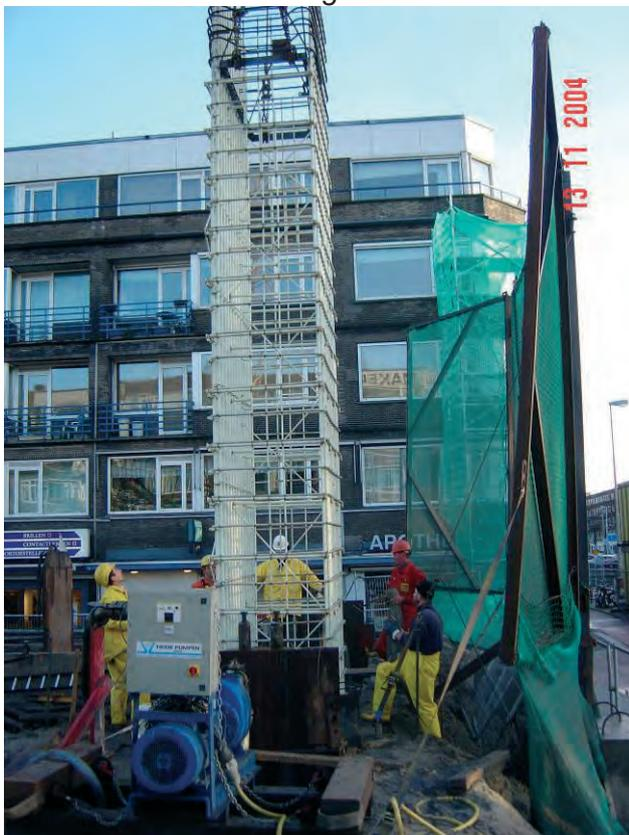
*Bild 12: Einbau eines GFK-Korbes*
