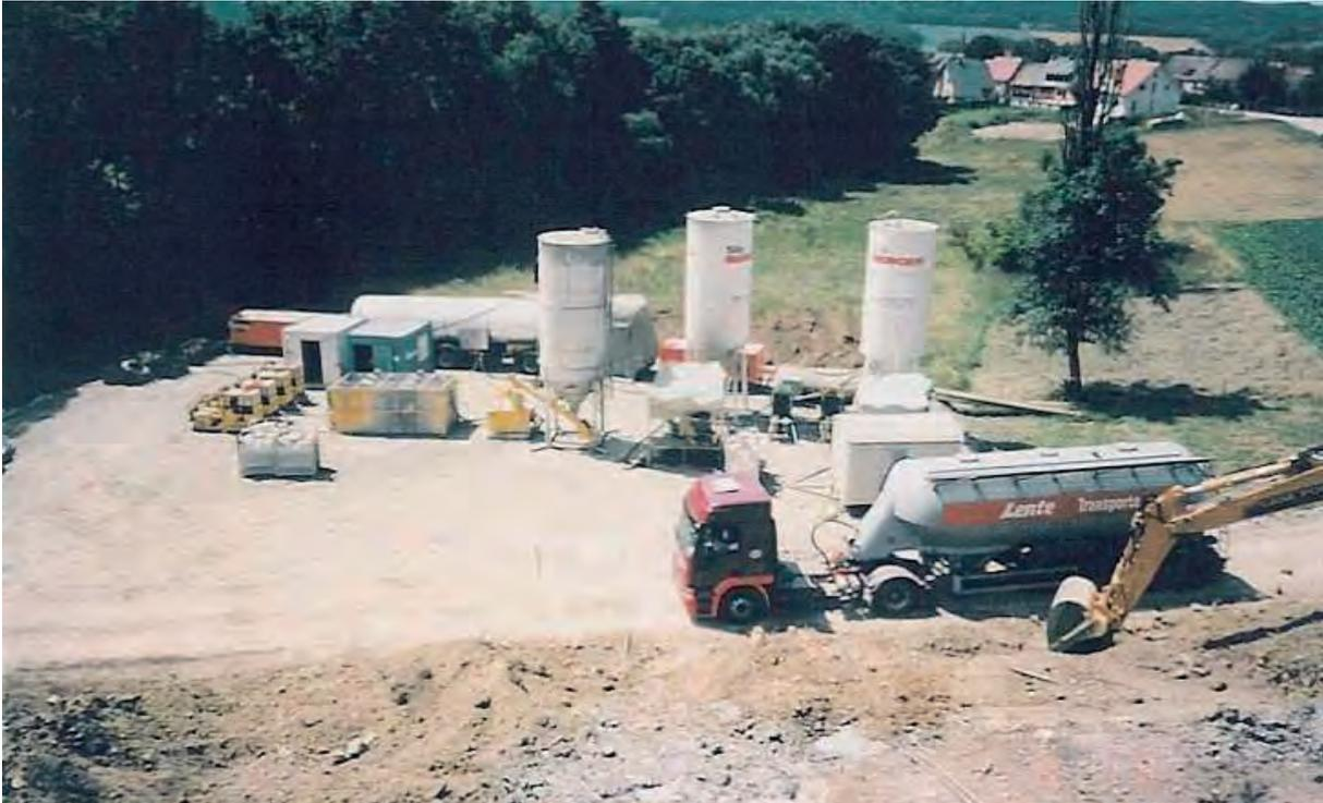
Bild 3: Mischzentrale zur Herstellung der Suspension mit Pumpstation
