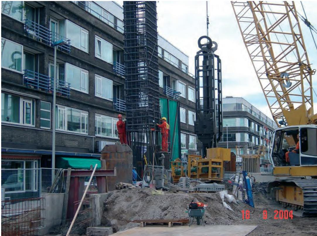
Bild 6: Einbau eines Bewehrungskorbes  $d = 1,50\text{ m}$
