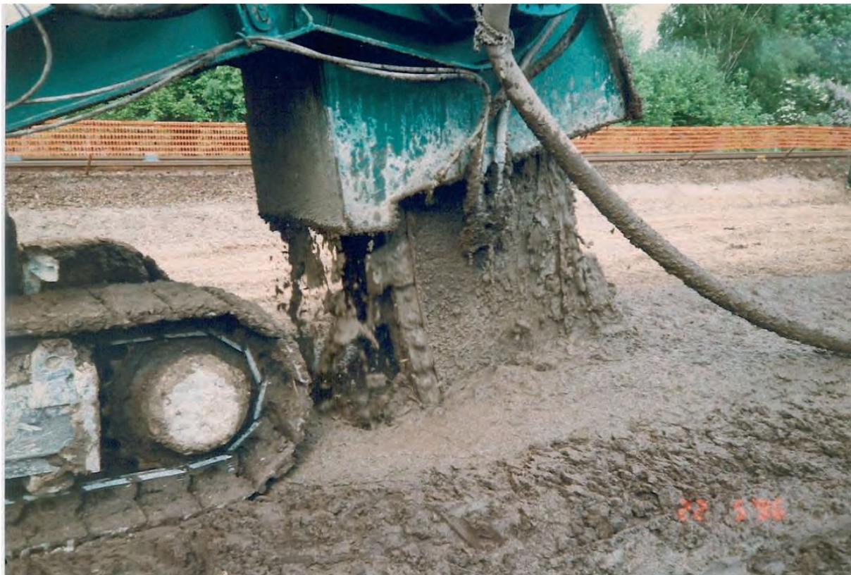
Bild 2: Vollständige Vermischung des Bodens mit Zementsuspension
