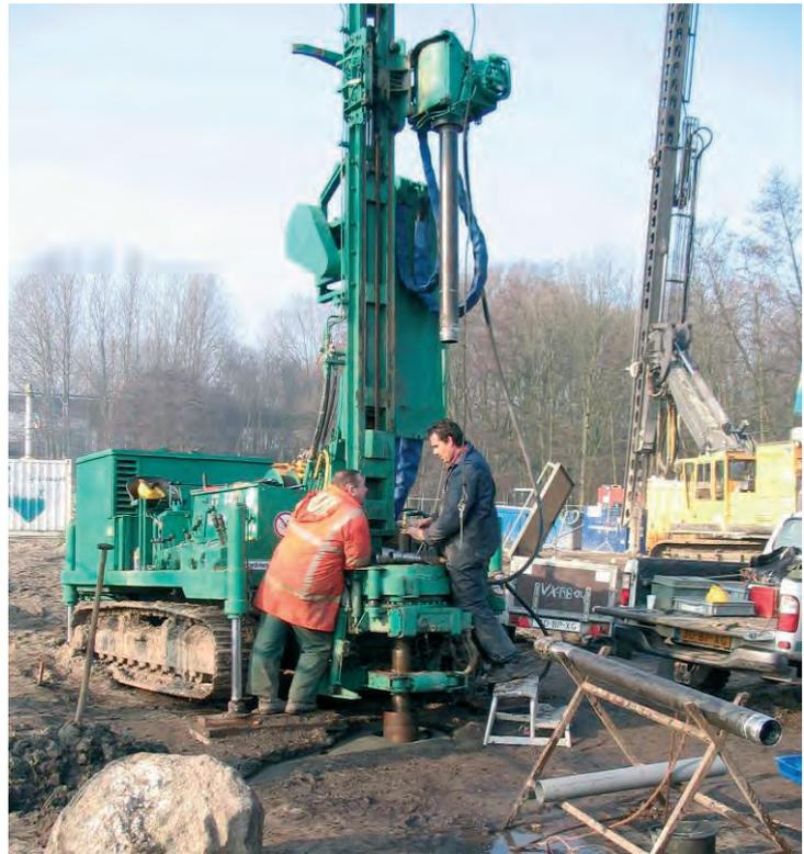
*Bild 21: Kernbohrung mit Dreifach-Verrohrung*
