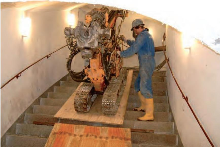
*Bild 14: Umsetzung Kellerbohrgerät MR 500 über die Treppe in den Kellergang*
