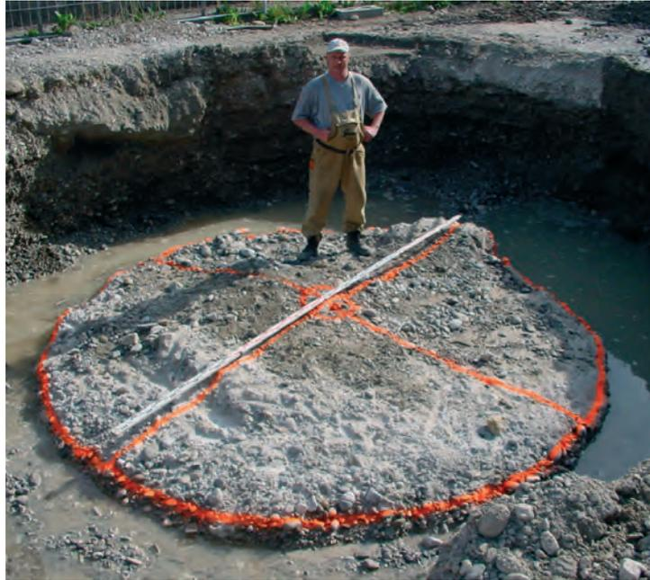
*Bild 4: Probesäule, Säulendurchmesser 4 m*
