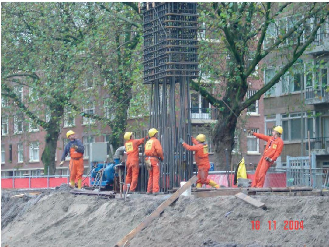
Bild 7: Einbau eines Bewehrungskorbes  $d = 1,20\text{ m}$
