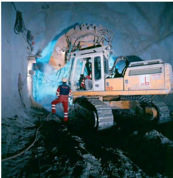
*Bahnsteig-Erweiterungstunnel: Abfräsen der Außenseite des Bestandstunnels der U6*
