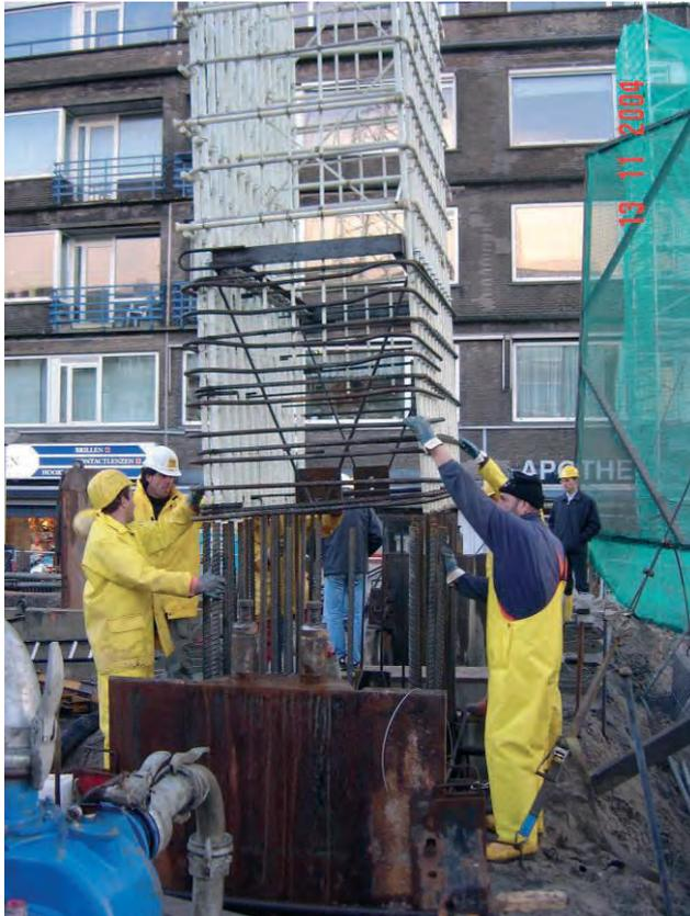
*Bild 11: Stoß eines GFK-Korbes mit einem Stahlbewehrungskorb*
