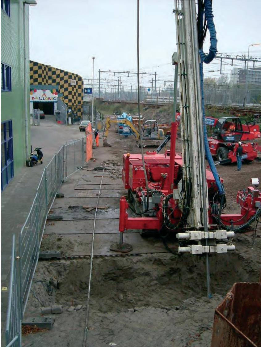
*Bild 31: Herstellung von schrägen Probesäulen (im Hintergrund die Gleisanlagen)*
