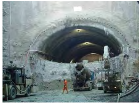
Bild 5: Kalottenvortrieb
