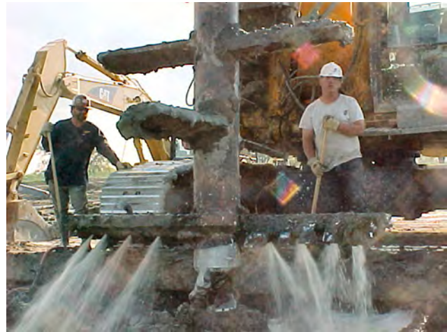
Bild 7b: Mischbalken mit nach unten gerichteten Suspensionsdüsen
