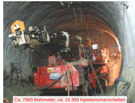
Bild 14: Injektion von der Ortsbrust
