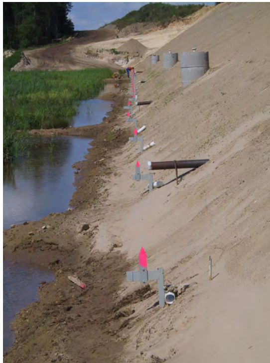
Bild 9: Horizontal- und Vertikalinklinometer zur Dammkontrolle
