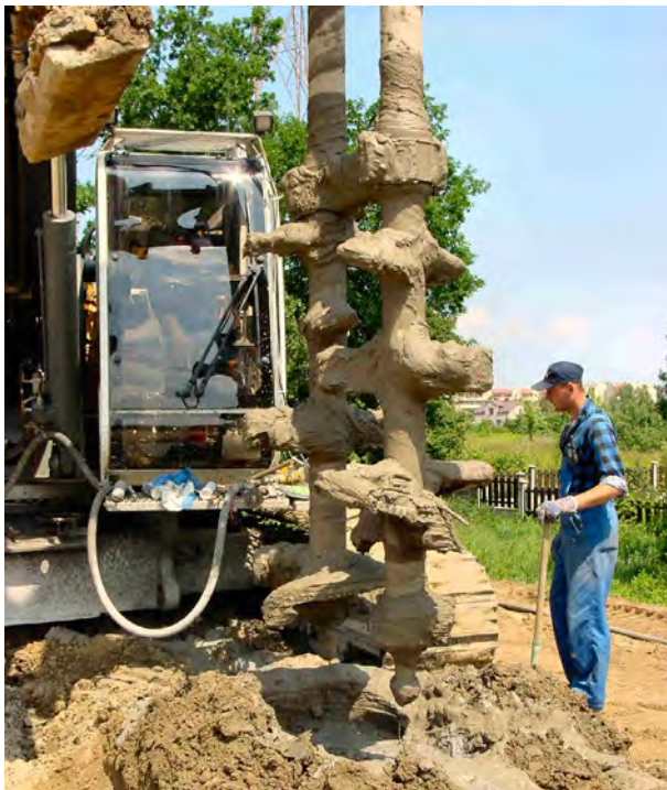
Bild 6c: Doppelpaddel Ø 2 x 0,7m
