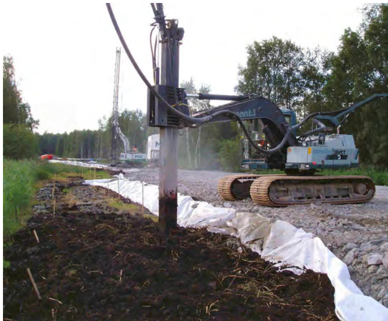
Bild 19c: Herstellung der säulenartigen Baugrundverbesserungselemente Massenstabilisierung im oberen Torf
