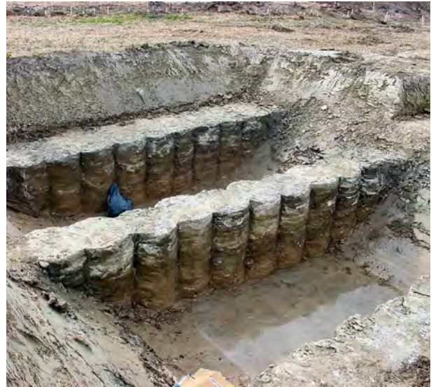
Bild 18b: Freigelegte Säulenreihen als Wandscheiben zur Erhöhung der Geländebruchsicherheit
