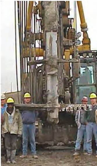
Bild 7a: Mischwerkzeug Ø 2,4 m und Mäklergerät, Keller USA
