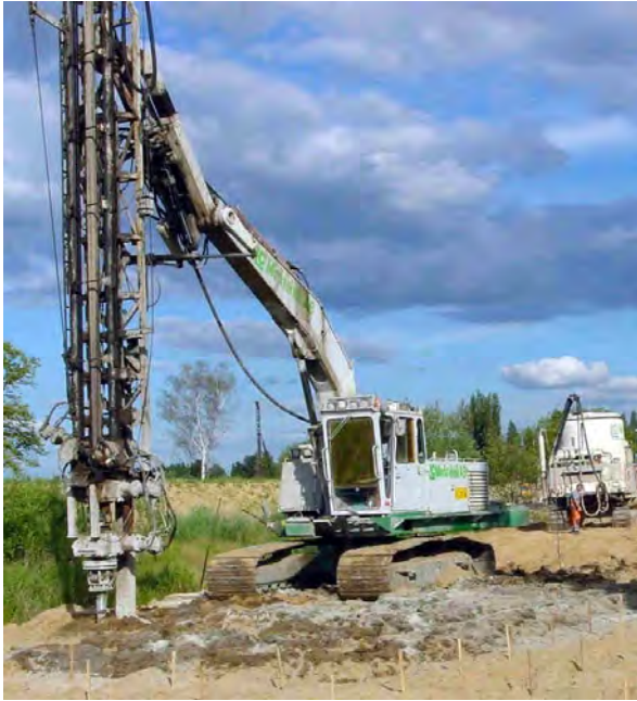
Bild 3a: Trägergerät mit Mäkler und Mischgerät
