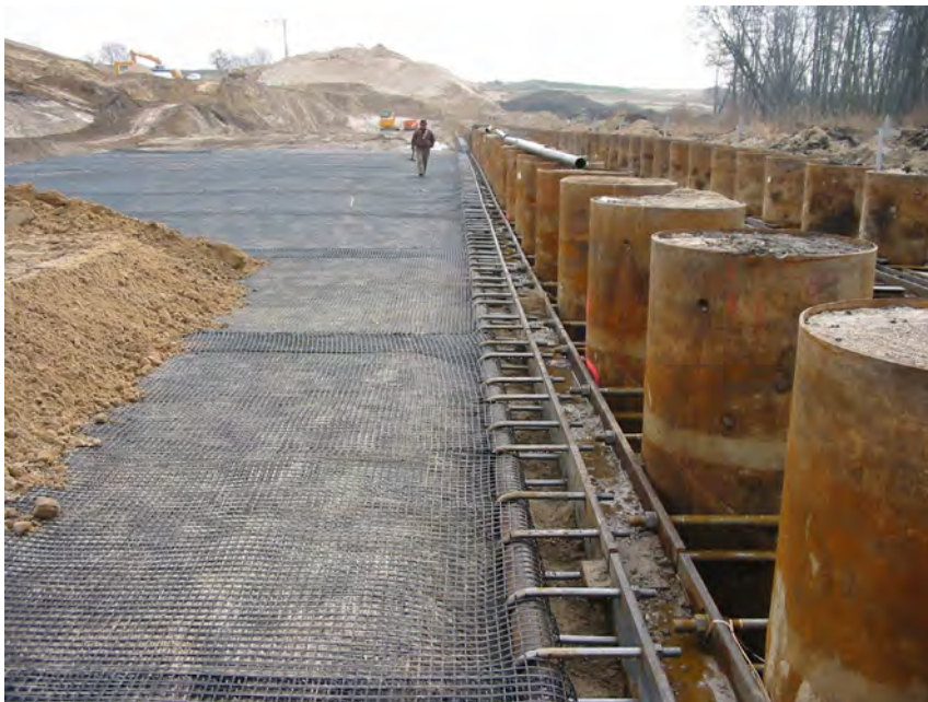
Bild 8: Rückverankerung der Stützkonstruktion mit Aramid-Geogitter, doppelagig verlegt (Gebrauchslast 220 kN/m)
