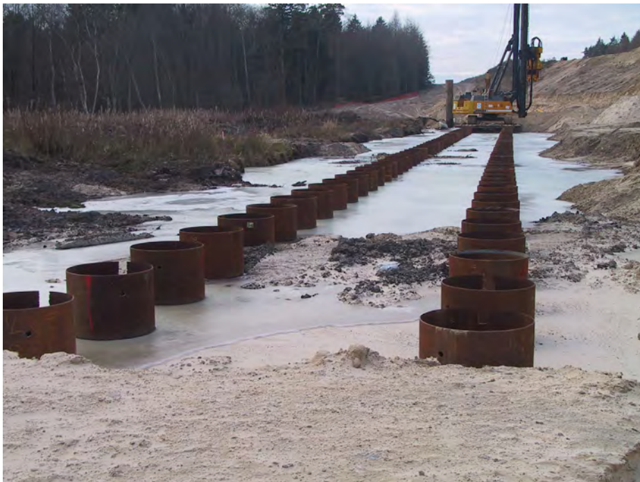
Bild 6: Stahlrohre in genauer Flucht
