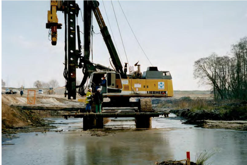
Bild 5: Schwere Ramme auf den bereits abgeteufte Stahlrohren
