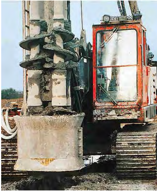
Bild 12a: Mehrfachschnecken Ø 4 x 0,5m Colmix (Frankreich)
