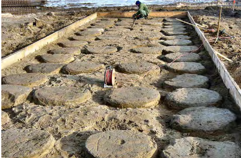
Bild 25: Freigelegte Säulen eines Brückenfundaments
