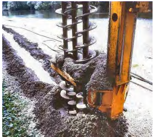
Bild 12b: Dreifachschnecke MIP Ø 3 x 0,37m Bauer (Deutschland)
