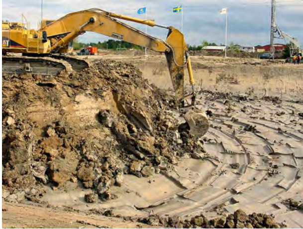
Bild 18a: Aushub nach ausgeführter Baugrundstabilisierung an den Böschungen
