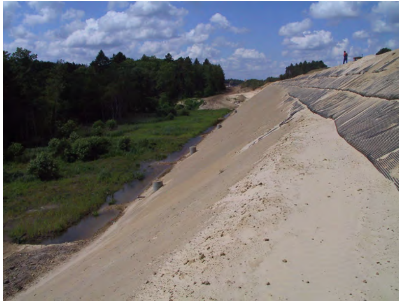
Bild 10: Dammschüttung auf Endhöhe
