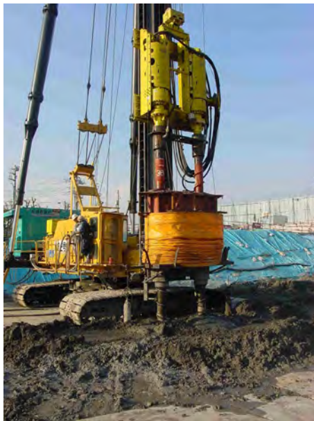
Bild 8a: Mäklergerät und Doppelpaddel Ø 2 x 1,0m CDM Standard (CDM Association, Japan)
