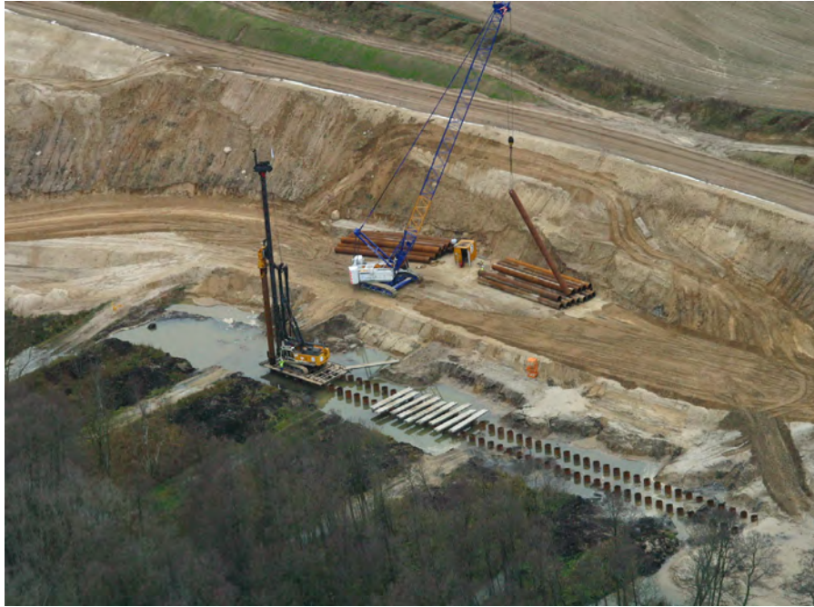
Bild 7: Gesamtüberblick der Baustelle
