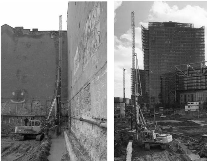
Abb. 2: Gleichbleibender Suspensionsspiegel bei der Herstellung
