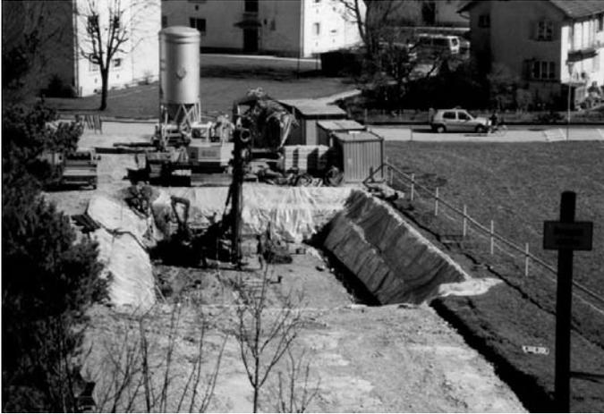
Bild 4: Herstellung der Pfähle
