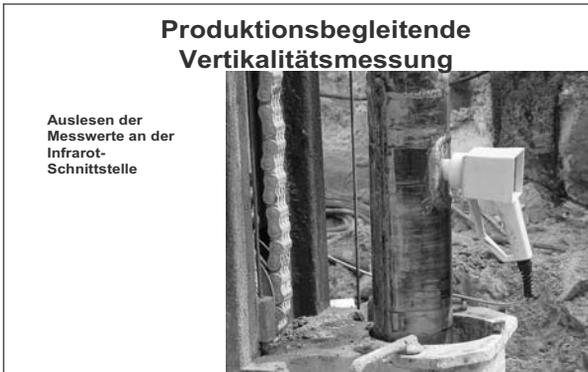
Inzwischen gibt es Neigungsmessgeräte die produktionsbegleitend jedes Bohrloch vermessen. Endlich kann man die Bohrabweichung in Höhe der Düsenstrahlsole.
