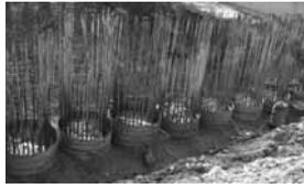
Bild 17: Aufbetonieren als Alternative zu ausreichendem Überbeton
