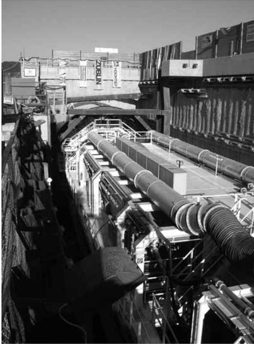
Bild 1: Startbaugrube – Baustelle Tunnel Wiesing/Jenbach
