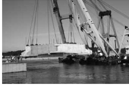
Bild 21: Fundament für den Messmast Arkona
