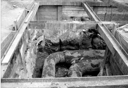
Bild 8: Ausführung der Düsenstrahlarbeiten ohne Beschädigung der vorhandenen Fernwärmeleitungen und deren Isolierungen
