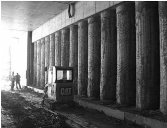
Bild 18: Aufbetonierte Pfahlköpfe
