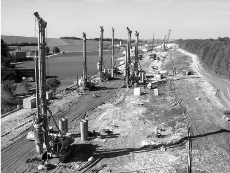
Bild 1: NBS Nürnberg-Ingolstadt, Los Nord, Herstellung der Pfähle beim Tunnel Offenbau
