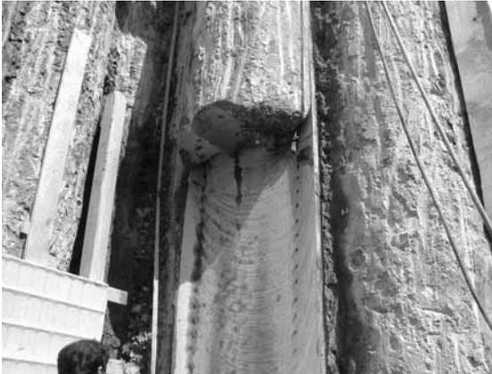
Bild 7: Aufwendige Korrektur der geometrischen Imperfektion
