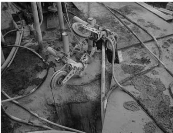
Bild 6: "Zurechtstutzen" mittels einer Seilsäge
