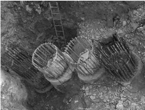
Bild 20: Anschweißen von Bewehrungsstäben bei Körben außerhalb der Toleranz
