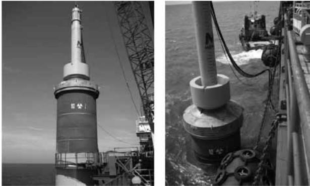
Bild 20: Hammer zum Einbringen von Monopiles (© Menck)
