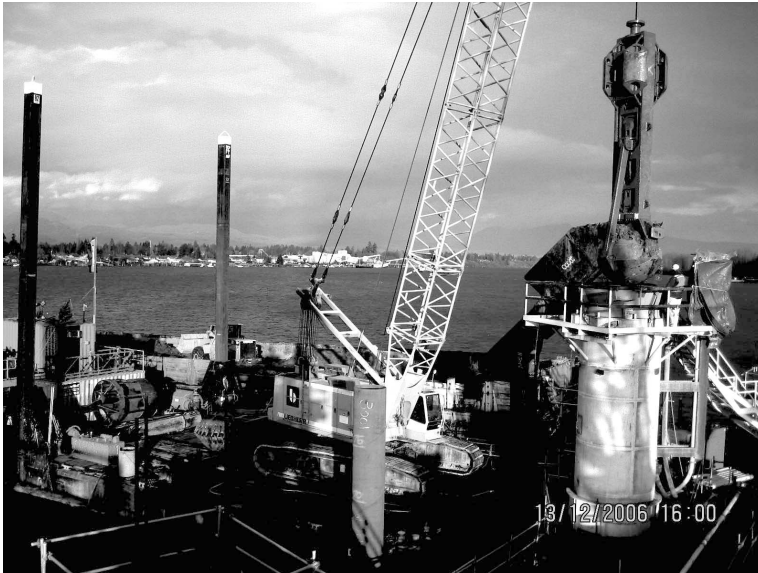
Bild 7: Aushub mit Arbeitsplattform
