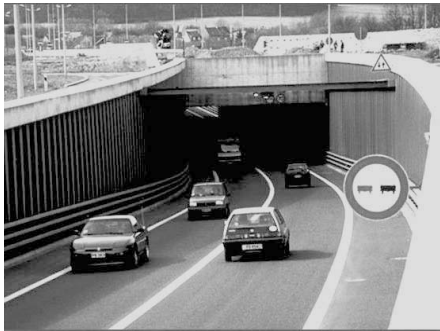
Bild 1: Beispiele für die dauerhafte Verwendung von Spundwänden als Trogwand und als Ufereinfassung
