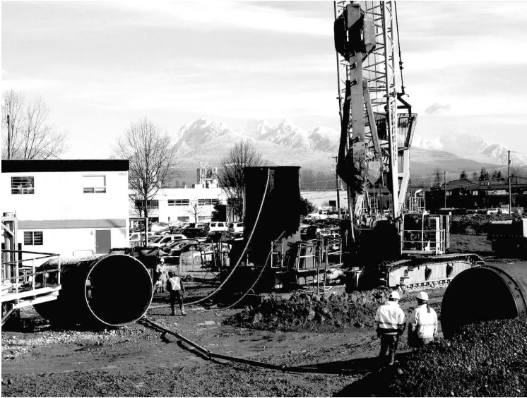
Bild 12: Aushub der Landpfähle
