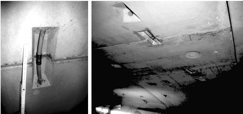
Bild 5: Kopplung von Absorberrohre
