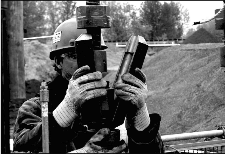
Bild 10: Kupplung zum Stoßen der Längsbewehrung
