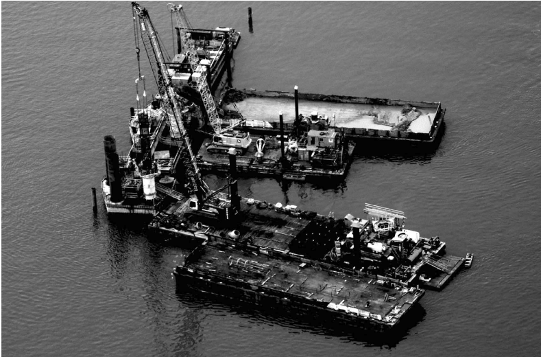
Bild 6: Herstellung der Flusspfähle
