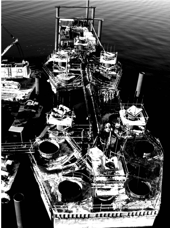
Bild 5: Betonfertigteil als Bohrschablone
