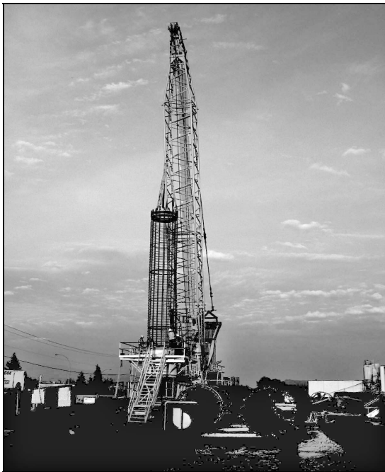
Bild 13: Einbau der Bewehrung
