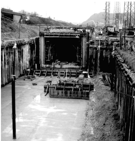
Bild 2: Spundwandeinsatz als temporäre Bauhilfsmaßnahme zur Baugrubensicherung
