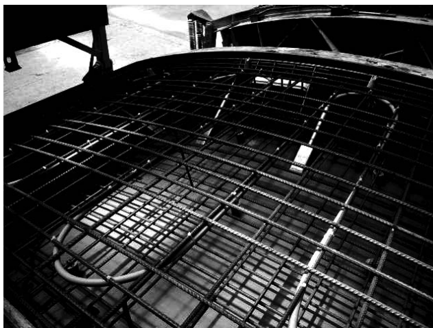
Bild 2: Absorberrohre mit Bewehrungskorb in einer Stahlschalung für die Tübbingbetonage.
