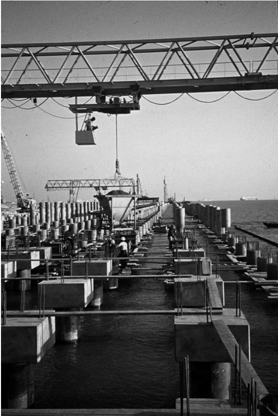
Bild 27: Pfahlkopferherstellung
