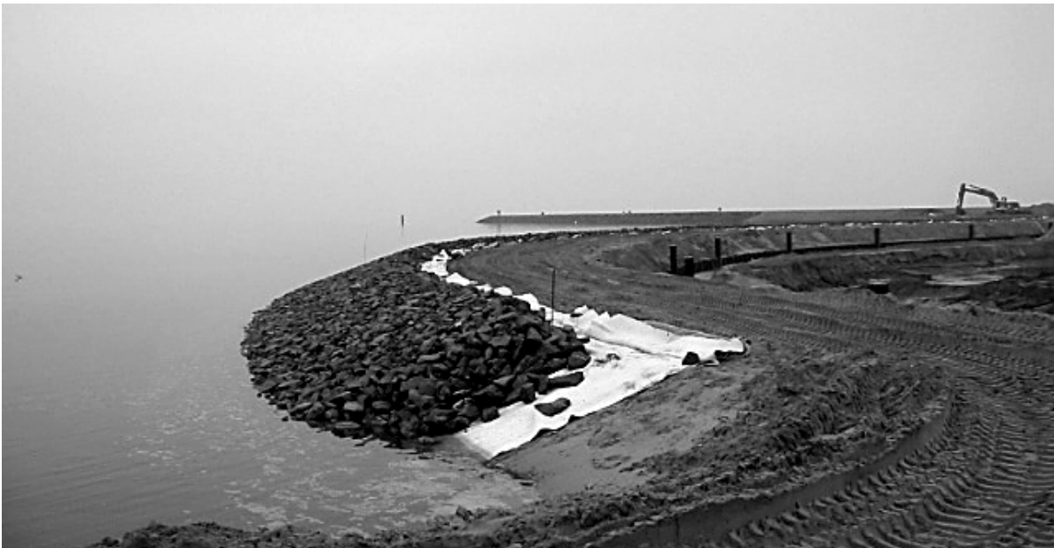
Bild 1: Herstellung einer Böschungssicherung mit Deckwerk auf geotextilem Filter unter trockenen Randbedingungen (Foto: Colcrete v. Essen Bau GmbH)
