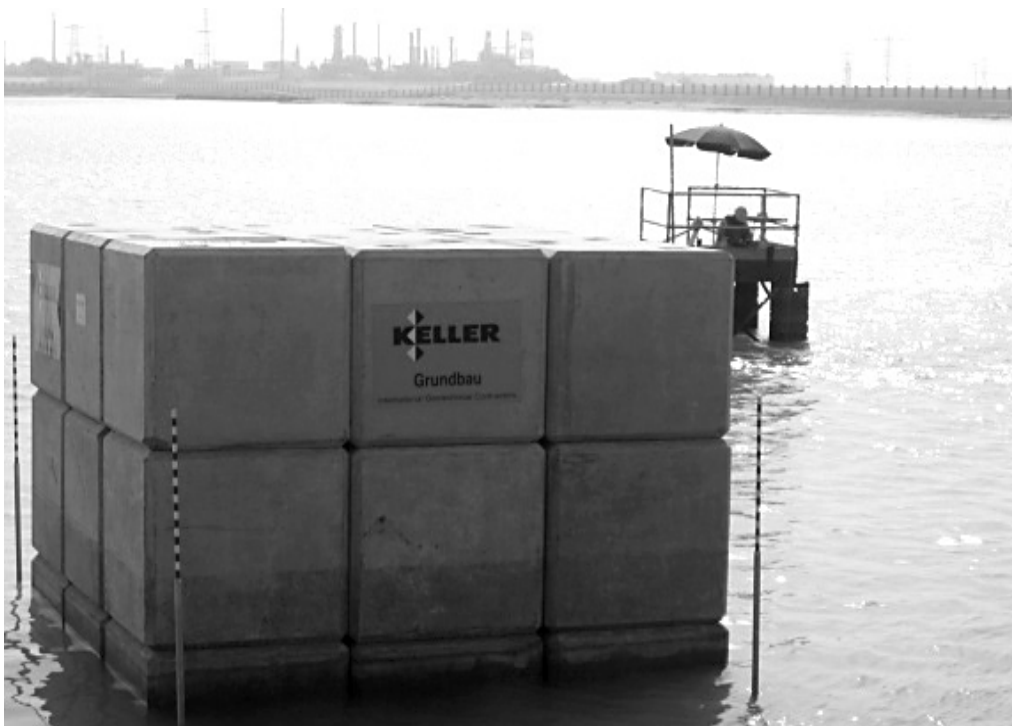
Bild 5: Die Totlast der Probelastung und der Vermessungsturm im Hintergrund
