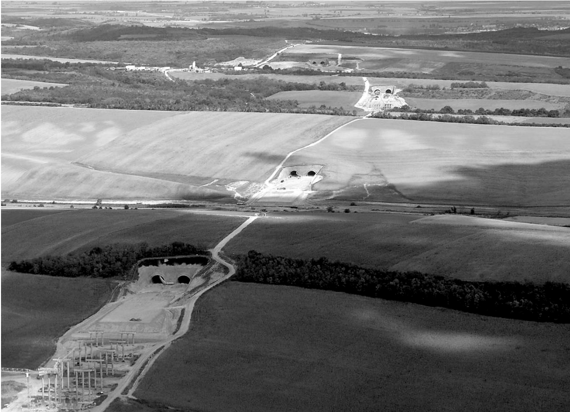
Bild 1: Tunnelbauwerke der neuen Autobahn M6 in Ungarn
