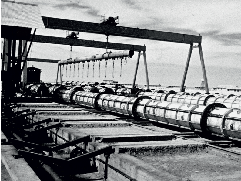
Bild 5: Spannbetonhohlpfahlherstellung
