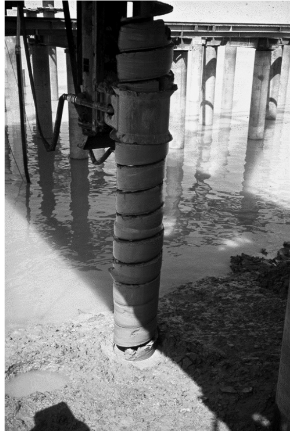
Bild 22: Vorbohrung vor Pfahlrammung und Füllung der Bohrung mit Bentonitsuspension
