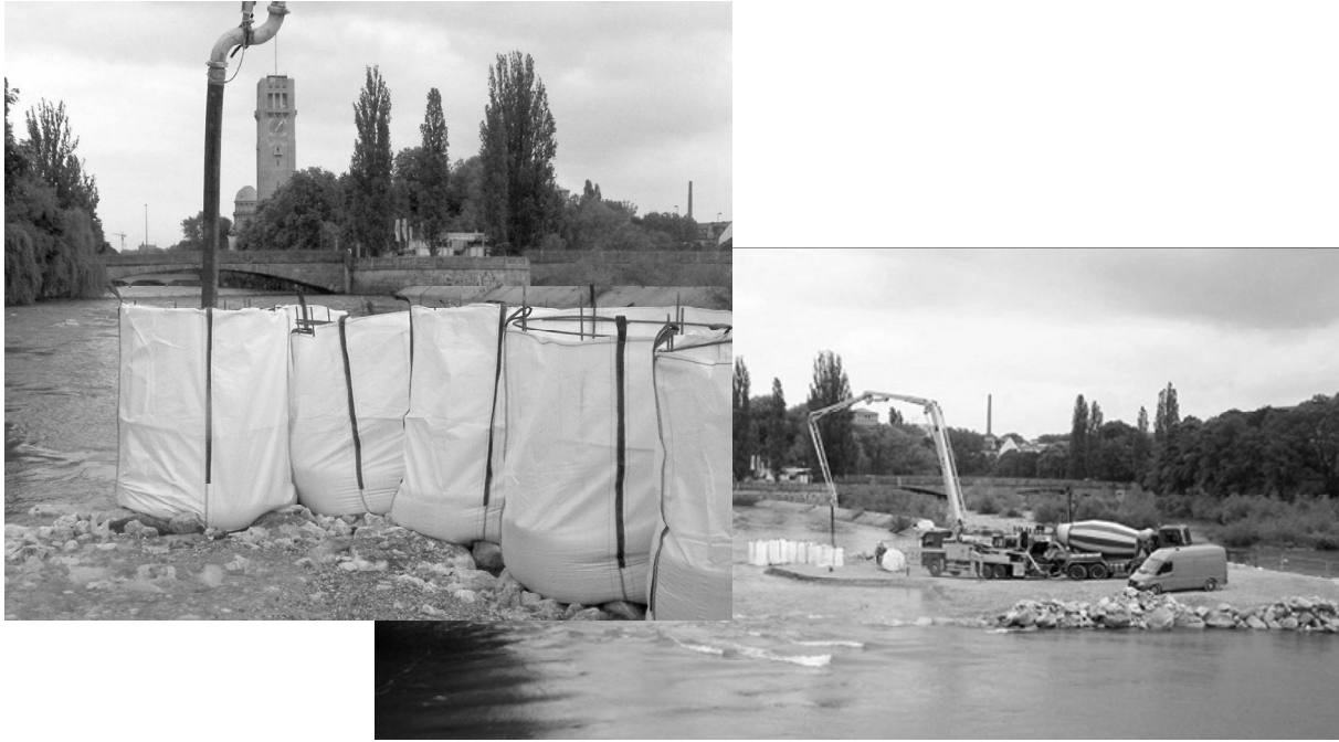
Abbildung 7 Einbau der Big Bags an den Kopfseiten der Inseln
