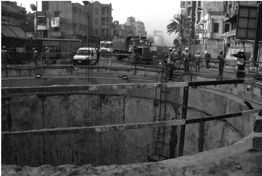
Bild 14: Hergestellter Schacht als Schlitzwand mit 18 m Durchmesser
