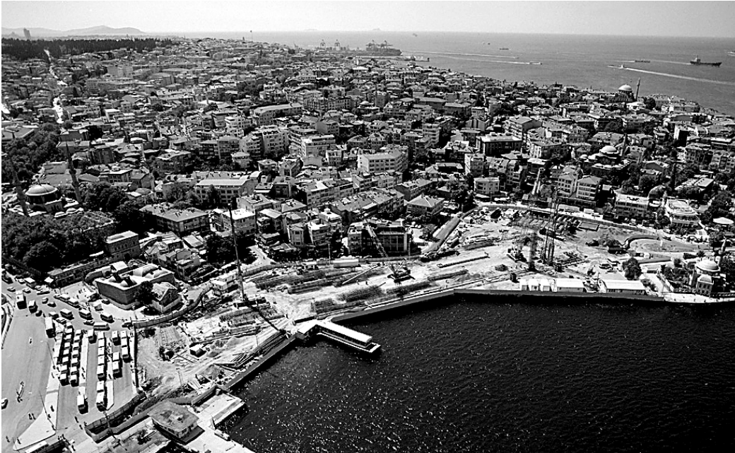
Bild 1: Lage der Baustelle bzw. des Bahnhofs am Bosphorus, Istanbul
