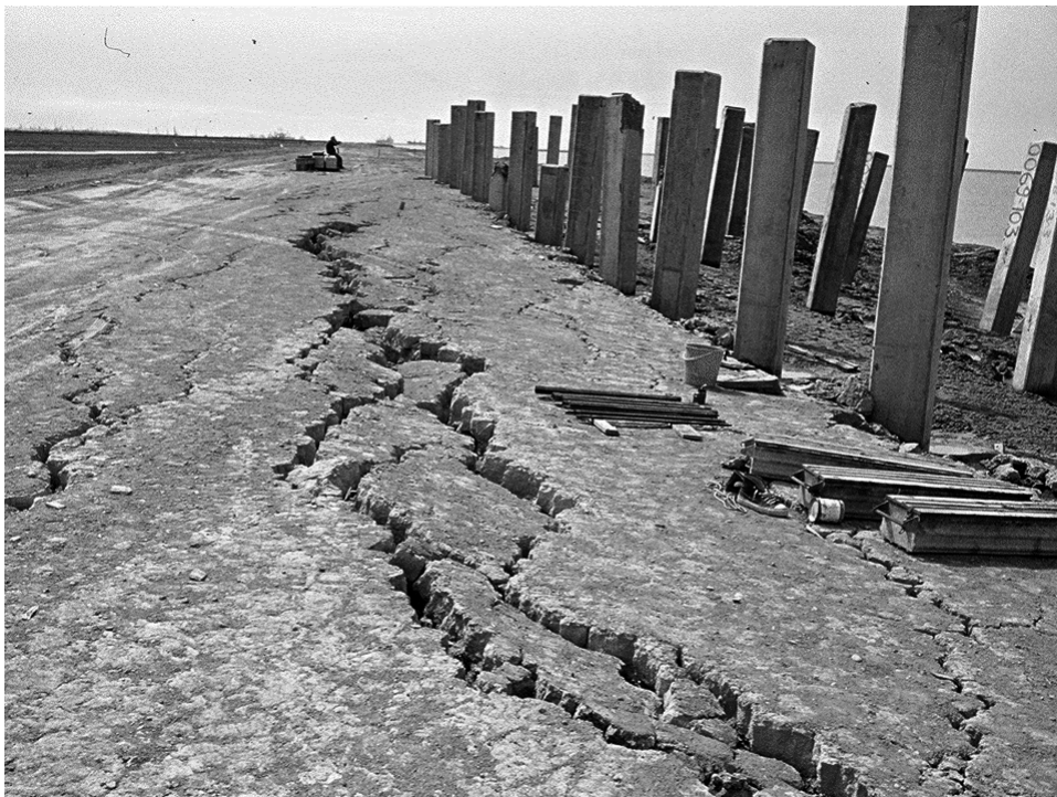
Bild 17: Abgerutschte Böschung
