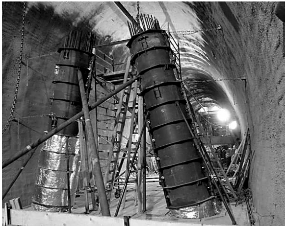
Bild 10: Ausbau Mittelstollen
