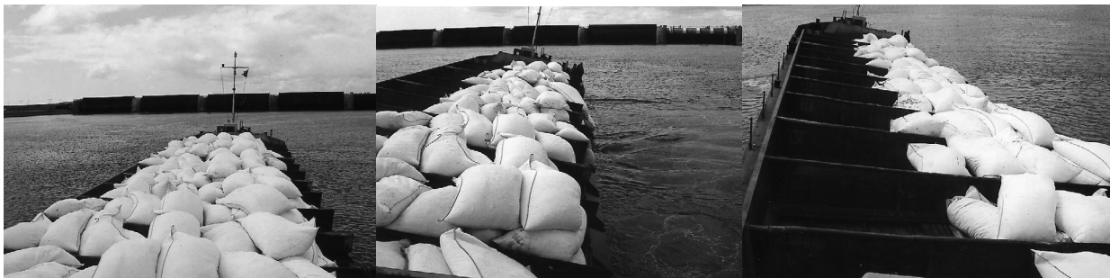
Bild 5: Eidersperrwerk 1993: Verklappen der Sandcontainer mit Steinstürzer zur Kolkstabilisierung in 28 m Wassertiefe
