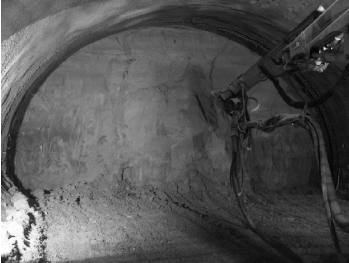
Bild 2: Tunnelortsbrust im Löss und Lösslehm
