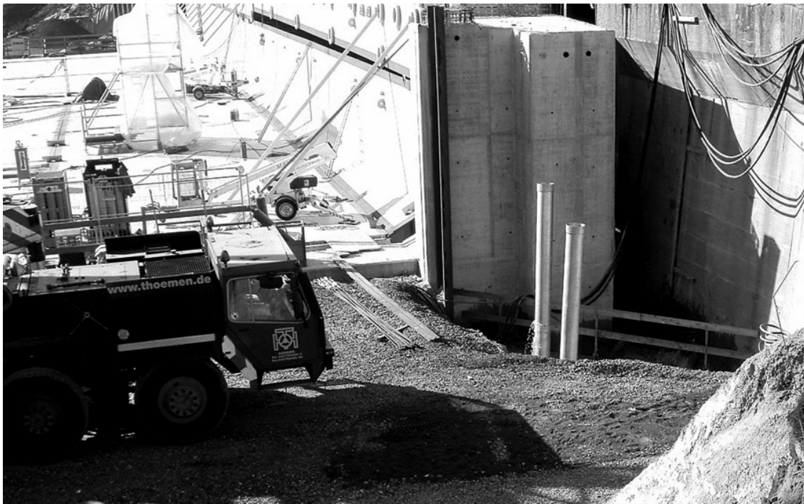
Bild 5: Blick auf die Baugrube zwischen den beiden Widerlagern
