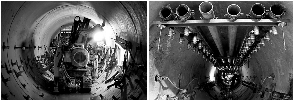
Bild 8 + 9: Installation der Vereisungslanzen in die Vorstollen
