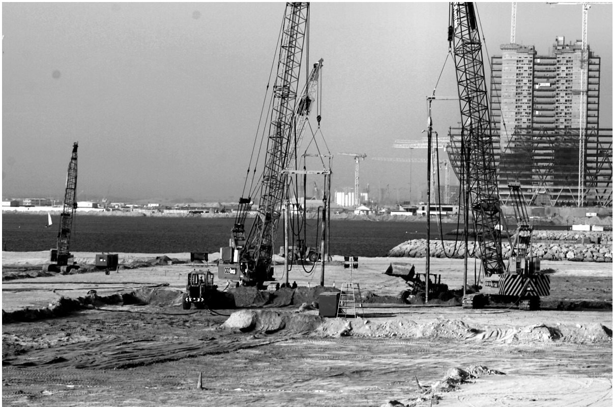
Bild 7: Rütteldruckverdichtung mit Tiefenrüttler in Tandemkonfiguration
