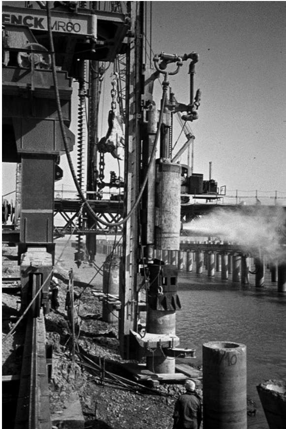
Bild 25: Pfahlrammung
