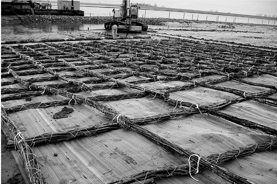
Bild 3: Herstellen von Sinkstücken für Sohlensicherungen mit geotextilen Filter- und Trägermaterial (Foto: Colcrete v. Essen Bau GmbH)
