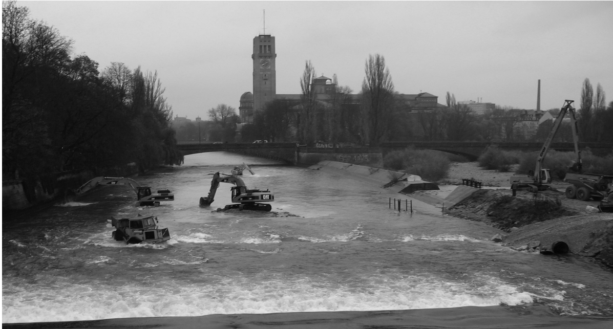
Abbildung 14 Einbau der Sohlsicherung
