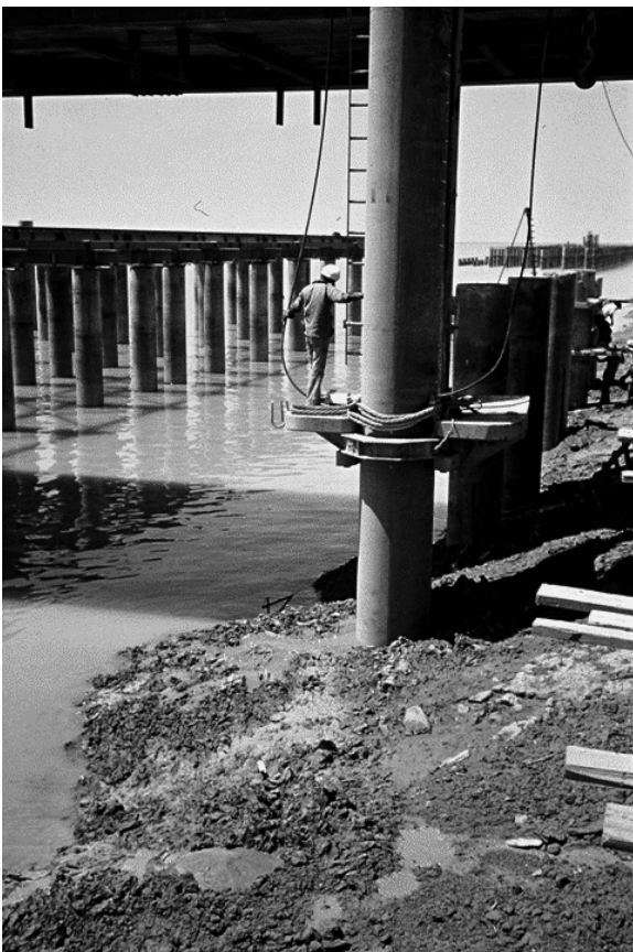
Bild 24: Aufsetzen des Pfahles auf die Bohrung
