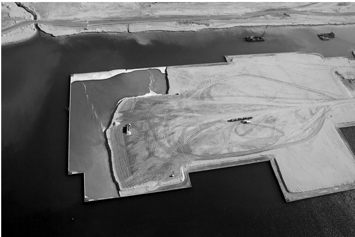
Bild 3: Hergestellte Winkelstützmauern im Meer und Aufspülung des Sandes innerhalb der Winkelstützmauern
