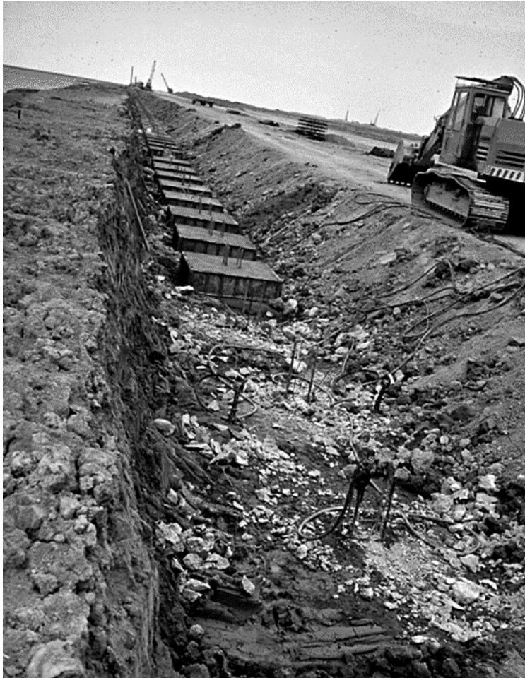
Bild 20: Angepasster Bauablauf für Entlastungspfähle
