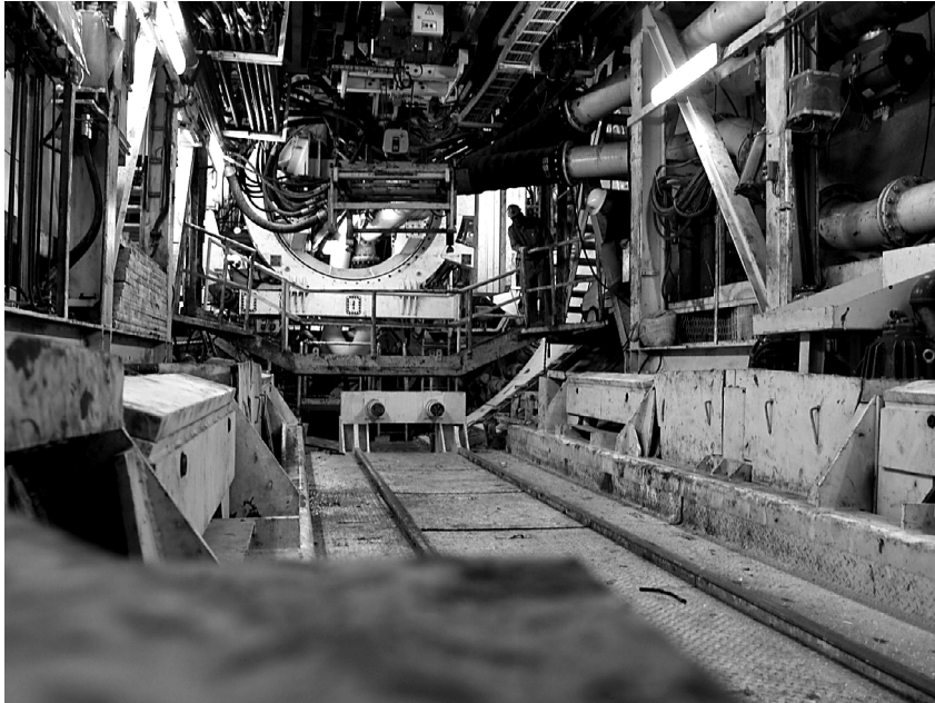
Bild 12: Blick in die TBM
