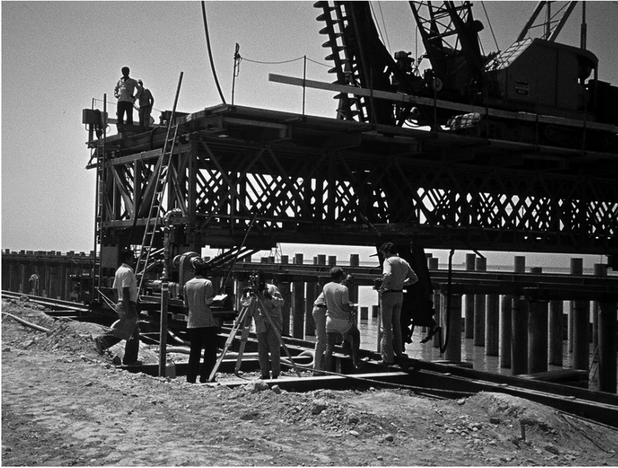
Bild 23: Schrägbohrung für geneigten Pfahl
