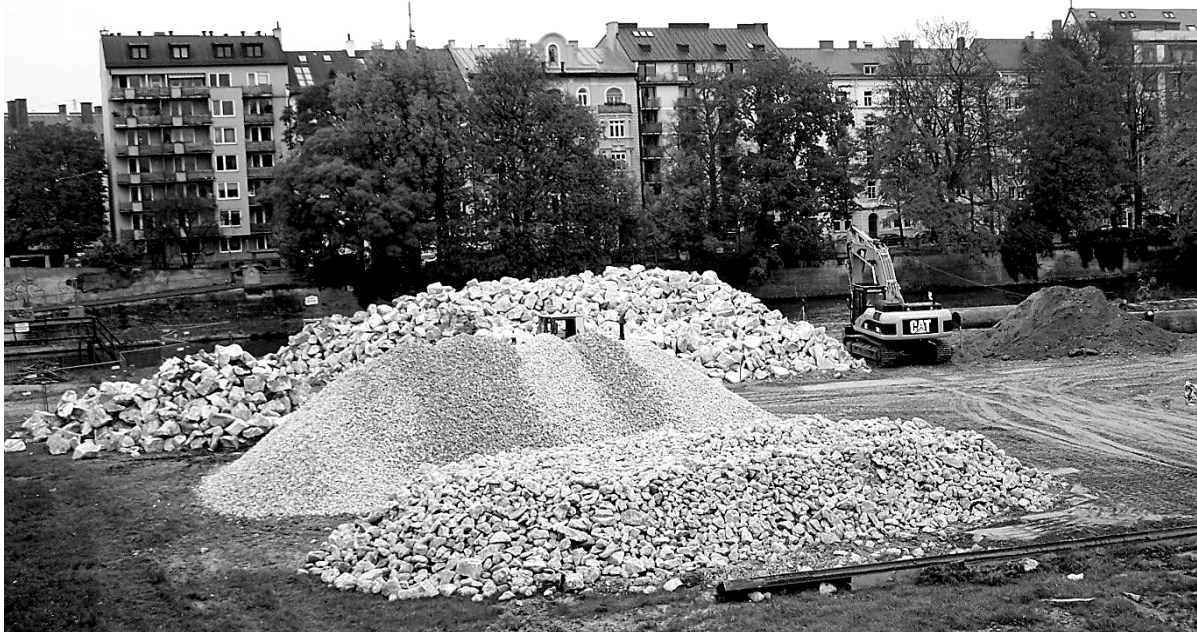
Abbildung 13 Pufferlager der Wasserbausteine im Vorland
