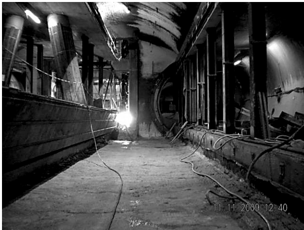
Bild 12: Vortrieb Seitenstollen abgeschlossen, Querschnitt nach Abbruch Spritzbeton des Mittelstollens und Tübbinge
