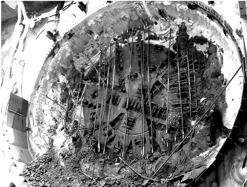
Bild 9: Freigelegtes Schneidrad der TBM
