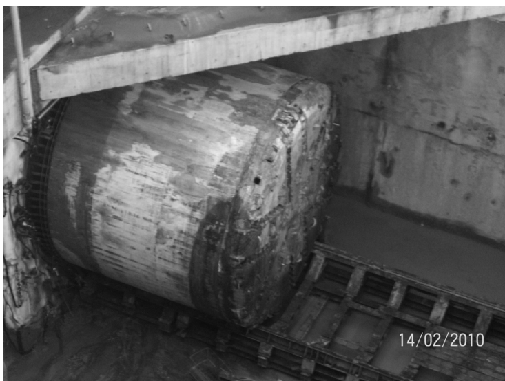
Bild 10: In den Bahnhof eingefahrene TBM
