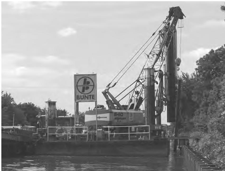
Bild 6: Spundwandarbeiten bei der Sicherung des Seitenkanals Ladenburg
