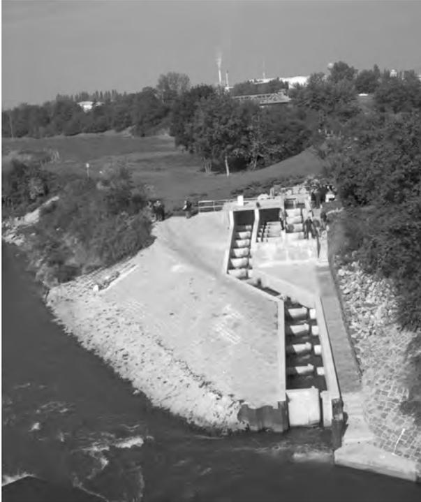
Bild 10: Schlitzpass am Wehr Ladenburg, Bauzeit 2004 - 2005
