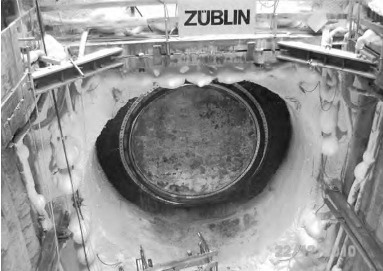
Bild 10: Frostkörper nach Ausbruch
