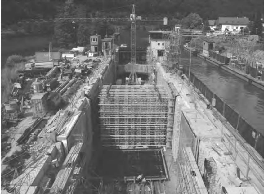
Bild 7: Grundinstandsetzung der linken Schleusenammer Hirschhorn
