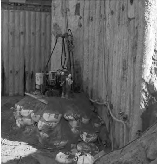
Bild 13: Sanierung Leckstelle mit DSV
