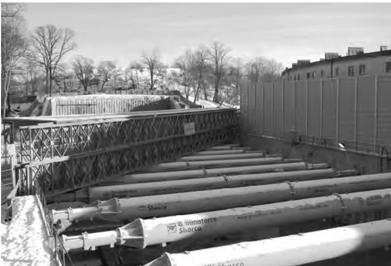
Bild 9: Rohrsteifen im eingebauten Zustand
