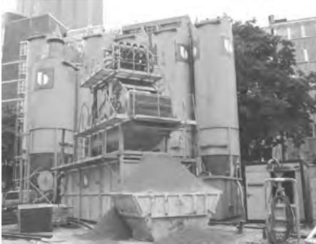
Bild 3: Aufwändige Baustelleneinrichtung bei Bentonitstützung
