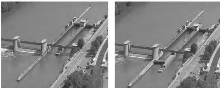
Bild 9: Schleusenanlage Neckargemünd vor (links) und nach (rechts) der geplanten Schleusenverlängerung
