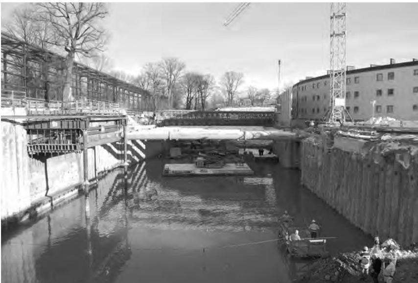
*Bild 13: Baumbalkon während der Herstellung der Auftriebsanker*
