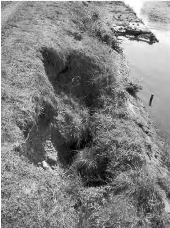
Bild 5: Böschungsschaden im Seitenkanal Ladenburg
