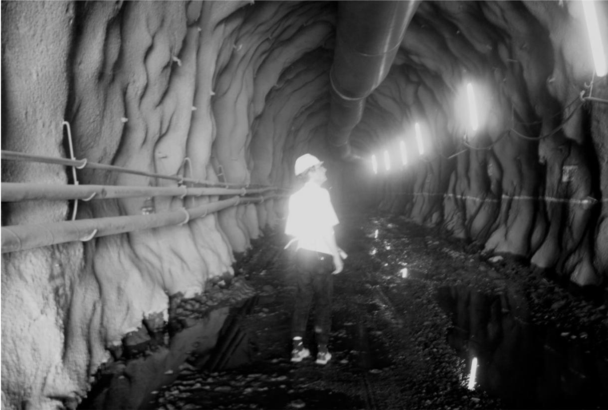
Bild 9: Tunnelsicherung mit Felsnägeln und Spritzbeton
