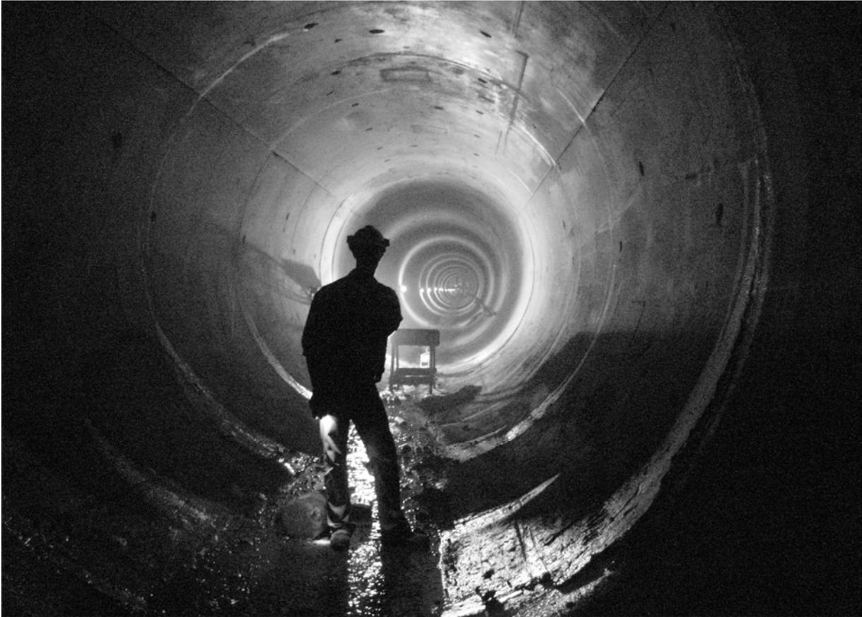
Bild 11: Hochdruckstollen mit Ortbeton-Innenschale, Durchmesser 4,10 m
