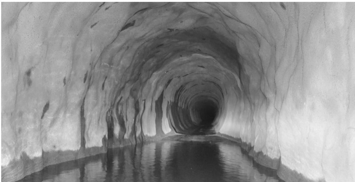
Bild 17: Spritzbeton-Innenschale in quellendem Gebirge – Ausführungsfoto
