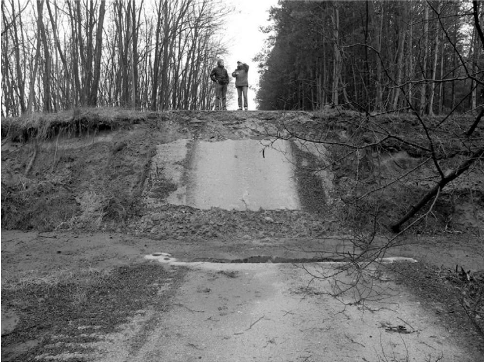
*Bild 5: Abbruchkante in Schlabendorf Nord, im Vordergrund verflüssigter Bereich, im Hintergrund nicht beeinträchtigte Kippe*
