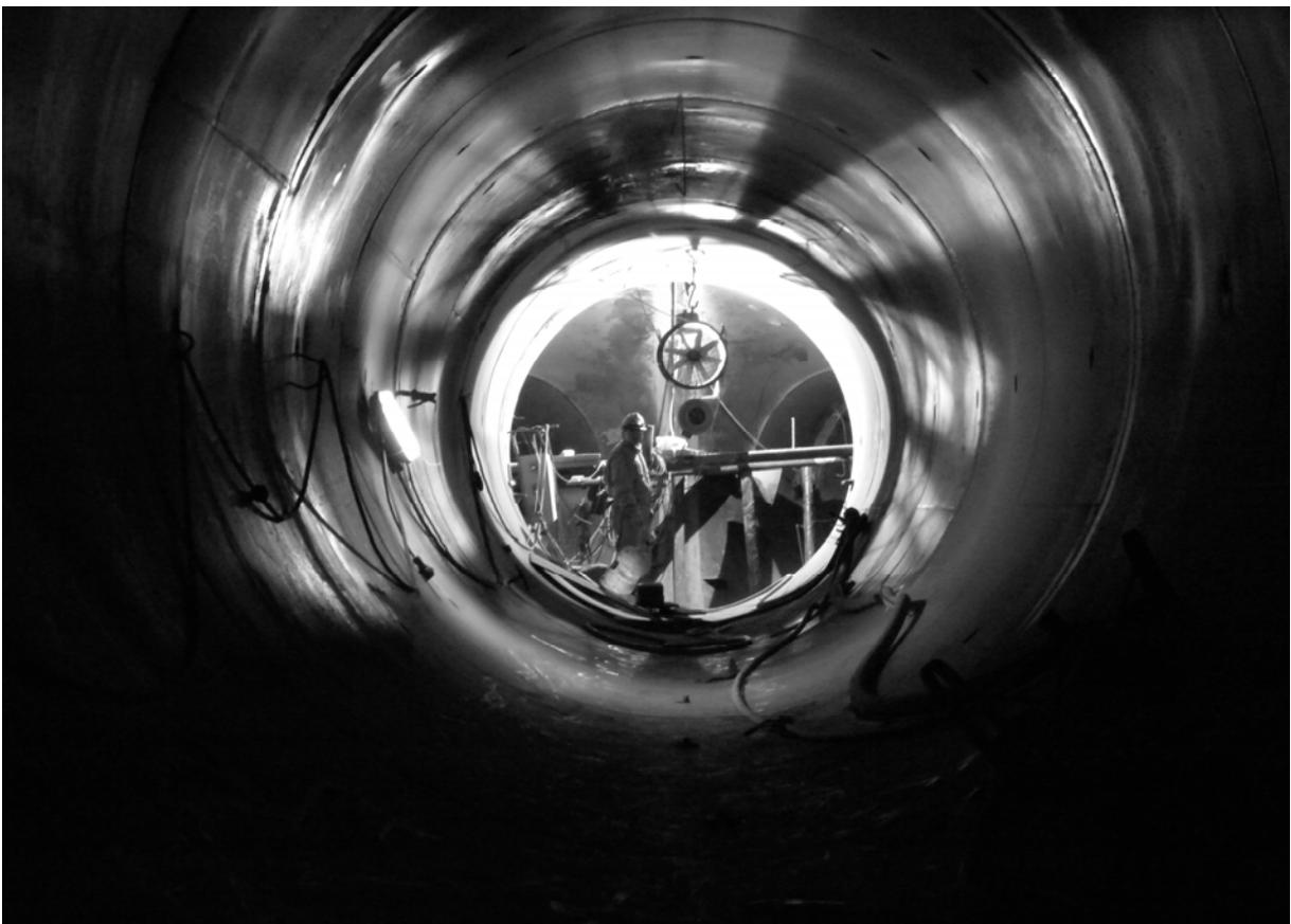
Bild 12: Stahlpanzerung des Hochdruckstollens, Blick in die Verzweigung
