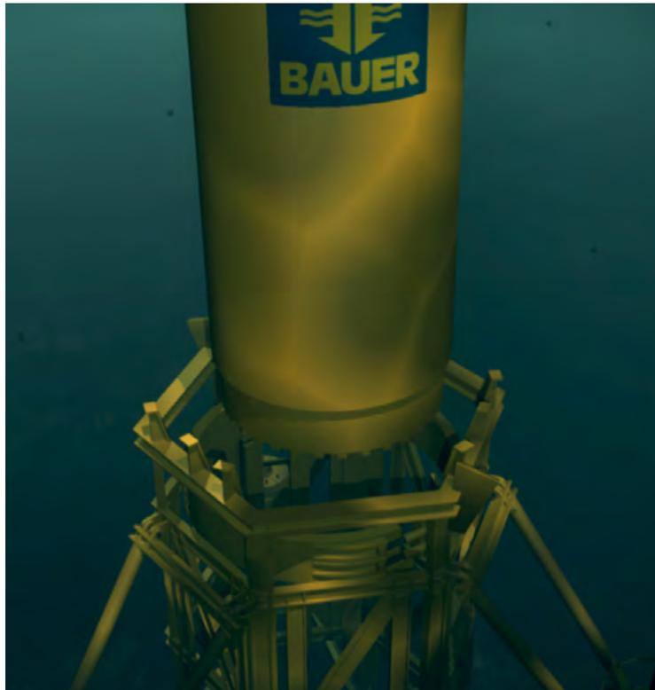
Bild 10: Einführen Führungsrohr mit Bohrgerät in die Bohrschablone
