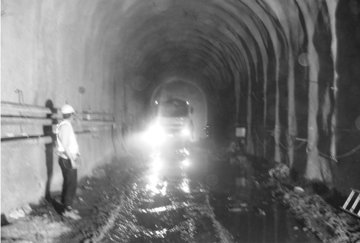
Bild 10: Tunnelsicherung mit Ausbaubögen und Spritzbeton
