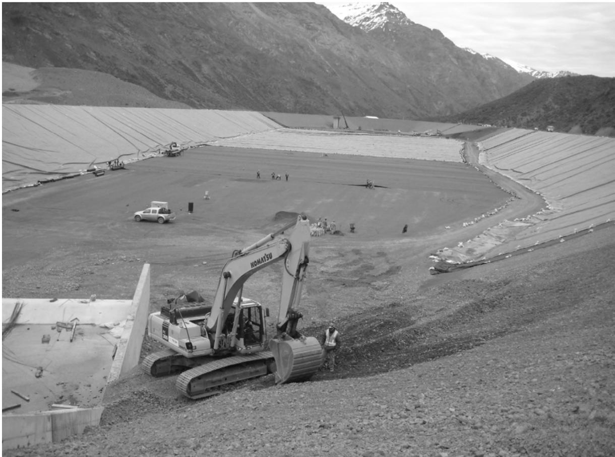
Bild 8: Einbau des HDPE-Dichtungssystems im Reservoir
