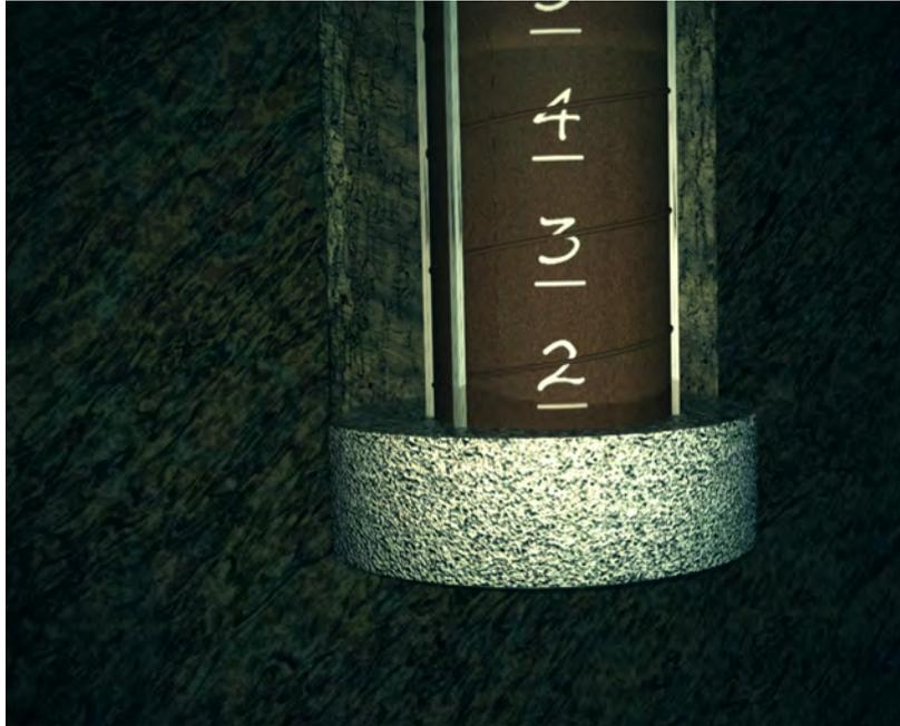
Bild 12: Zementierung des Pfahls vom Fuß ab
