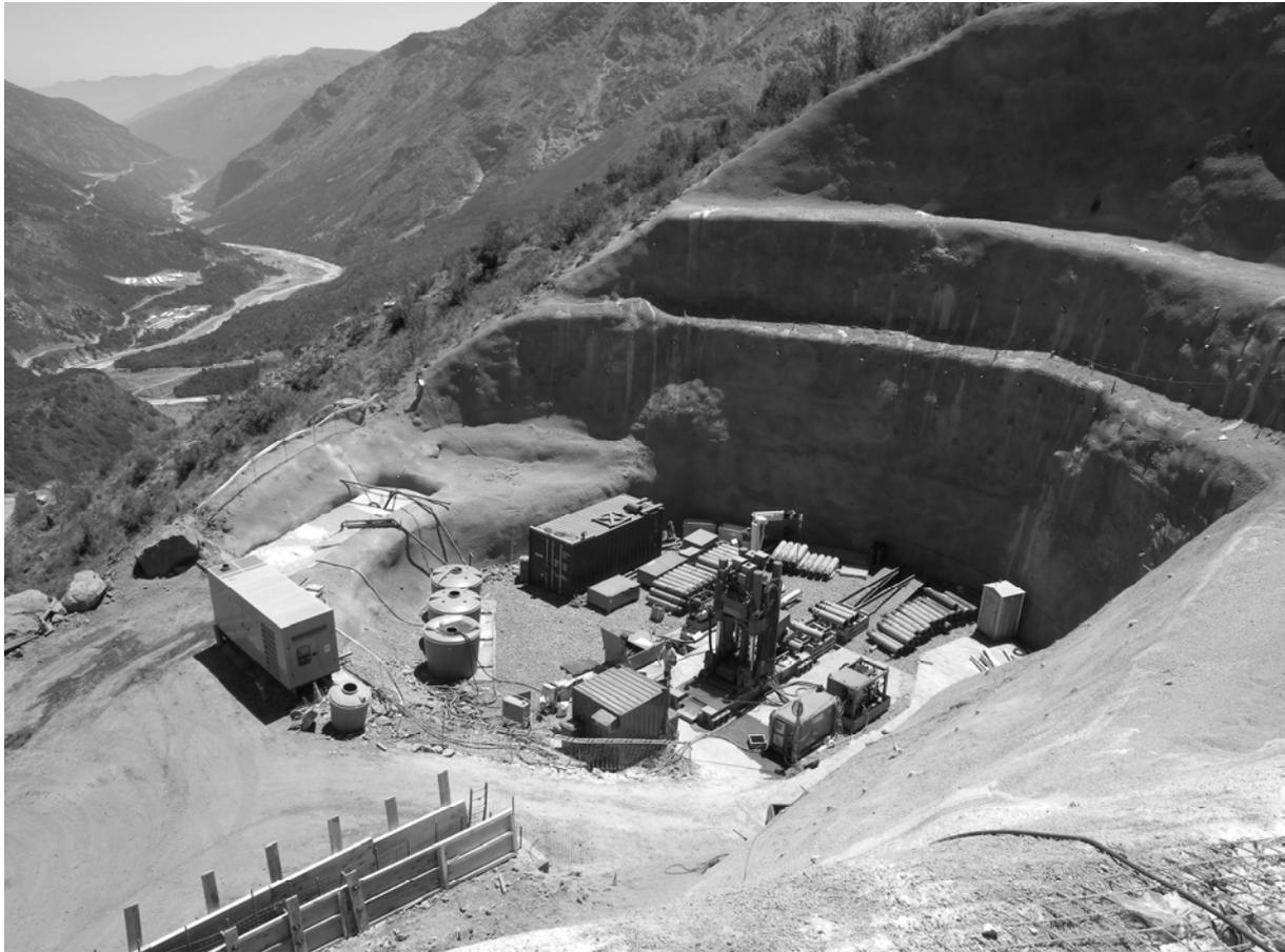
Bild 13: Niederbringen der Pilotbohrung des Raisebore-Vertikalschachtes
