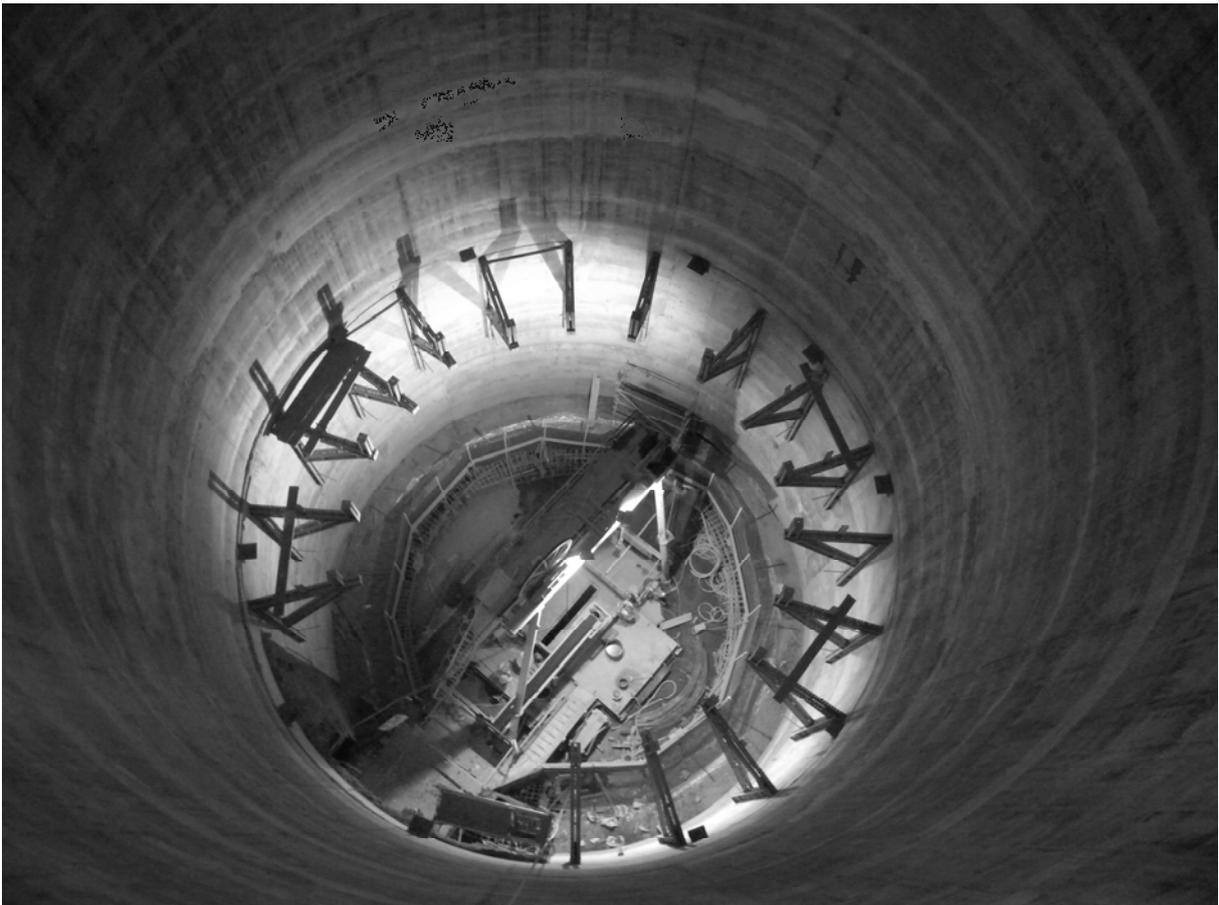
Bild 15: Wasserschloss mit Ortbeton-Innenschale, Innendurchmesser 16,0 m
