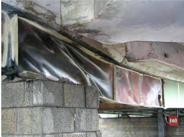
Defomierter Stahlträger am Auflager
