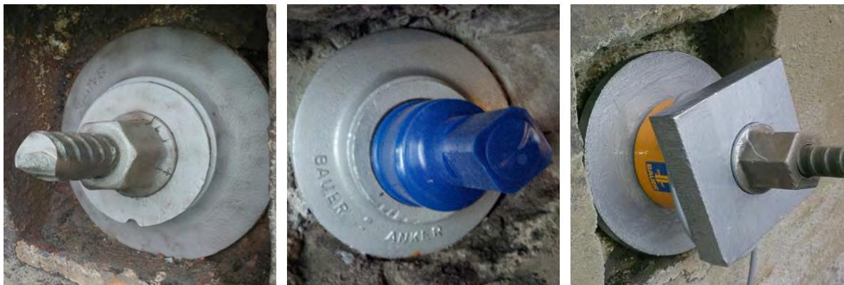
Bild 9: Ankerköpfe nach der Sanierung (links ohne, Mitte mit Ankerkappe, rechts mit Kraftmessdose zum Monitoring)
