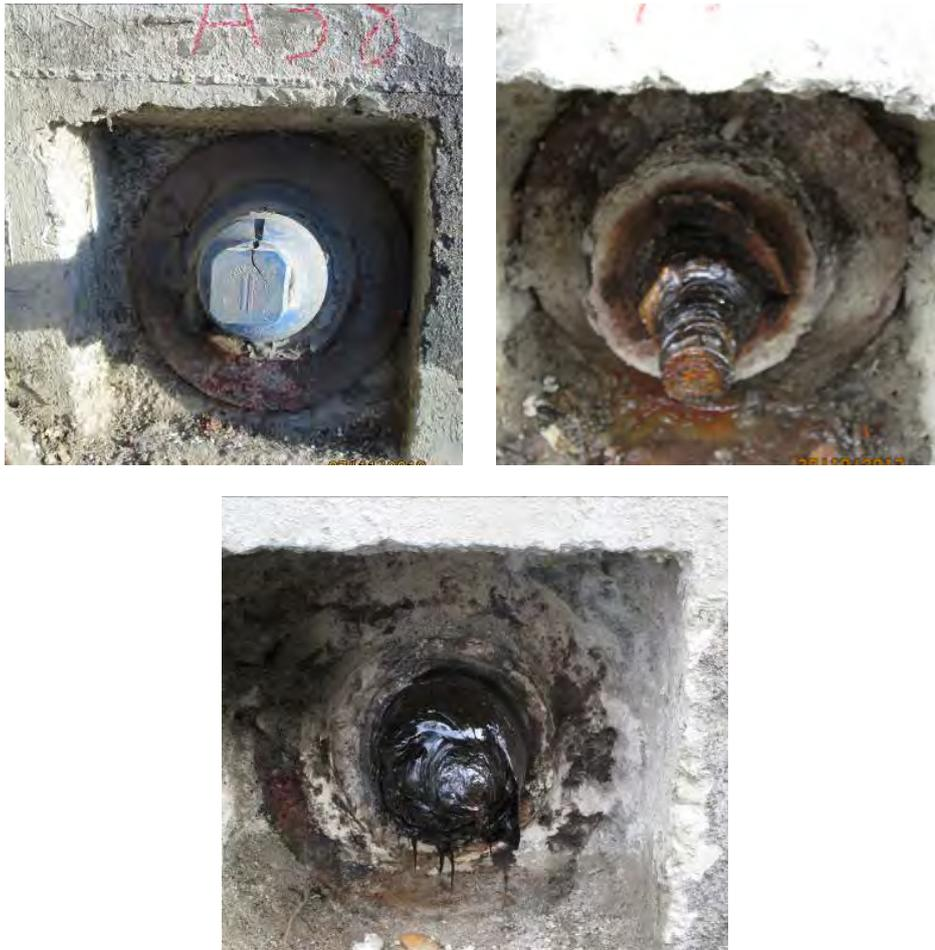
Bild 7: Zustand der Ankerköpfe vor dem Abnehmen der Schutzkappen (oben links) und danach (oben rechts und unten)
