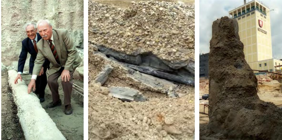
Bild 4: Dr. Karlheinz Bauer und Prof. Dr. Richard Jelinek, Ordinarius für Grundbau und Bodenmechanik an der TH München von 1954 bis 1980, besichtigen die Anker der Baugrube von 1958; rechts ein alter Ankerschacht
