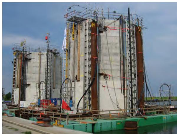
Bilder 10 / 11: Montage der Schwimmereinheit, (Bauphase D)
