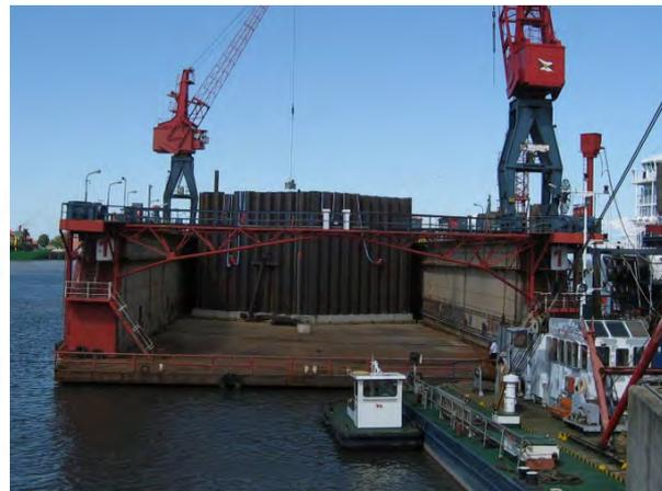
Bilder 6 / 7: Herstellung des Auftriebskörpers im Schwimmdock (Bauphase A)
