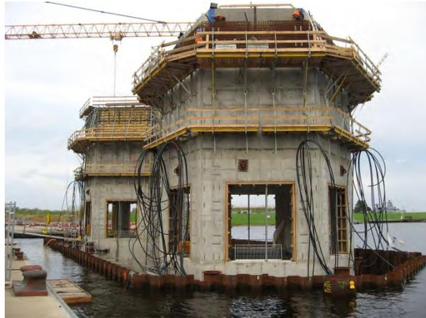
Bilder 8 / 9: Herstellung 2.,3. und 4. BA, schwimmend (Bauphase E)
