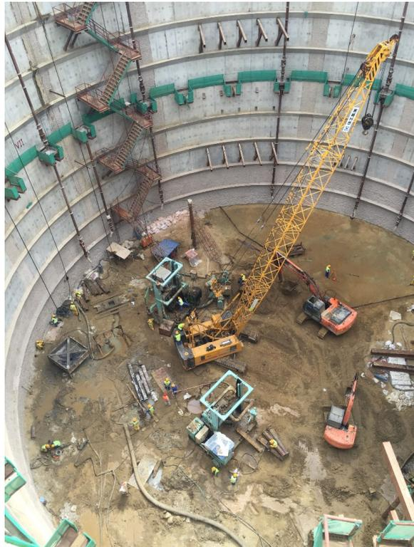
Bild 8: Bodenverbesserung auf der Sohle vom Schacht Süd
