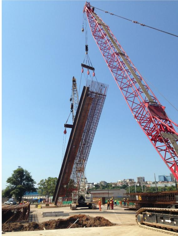
Bild 4: Einbau des Bewehrungskorbes für die Schlitzwand mit seitlichem „Abschalelement“
