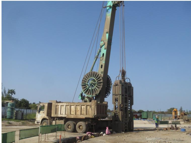
Bild 2: Aushubarbeiten für die Schlitzwand
