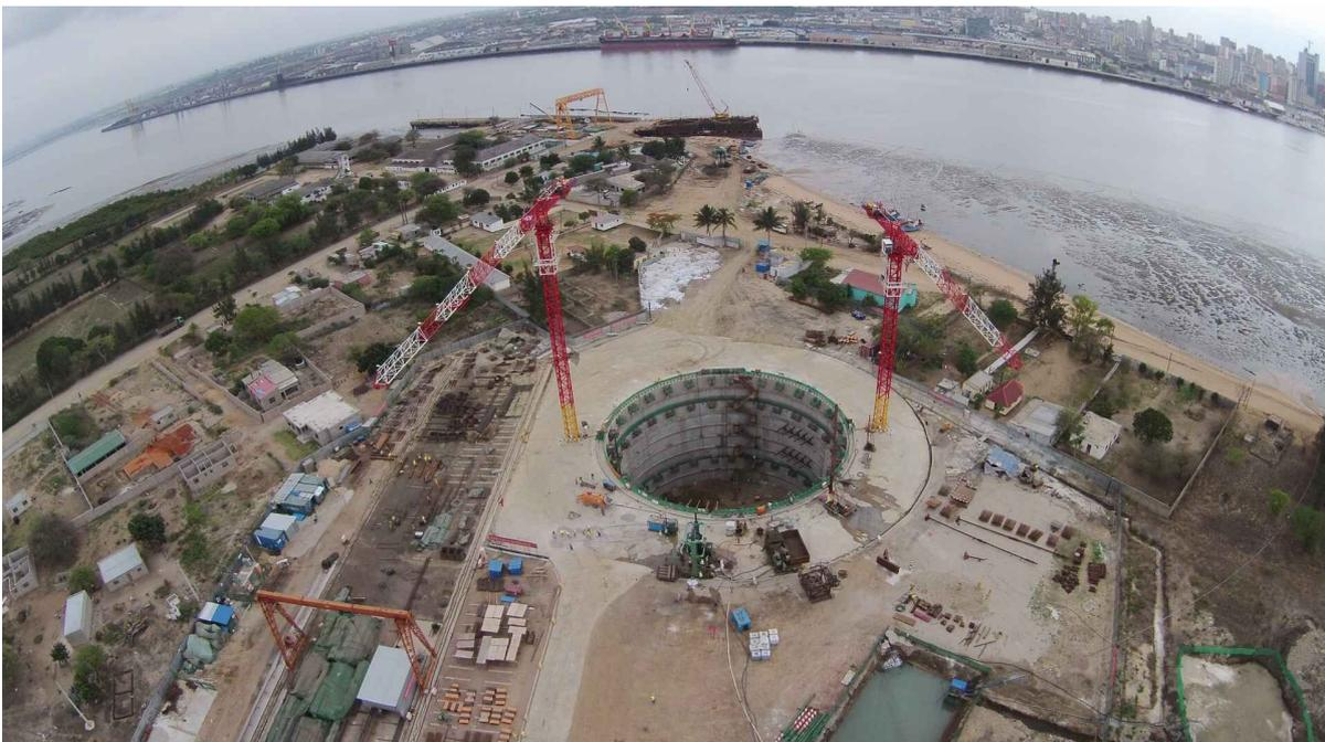
Bild 6: Schlitzwandschacht Süd nach der Fertigstellung
