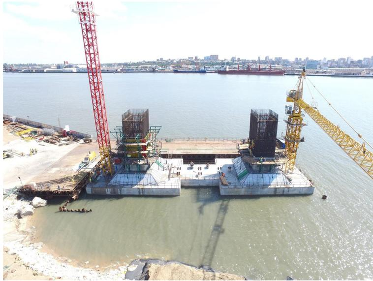
Bild 12: Süd Pylon im Februar 2016 – gegründet auf 24 Großbohrpfählen
