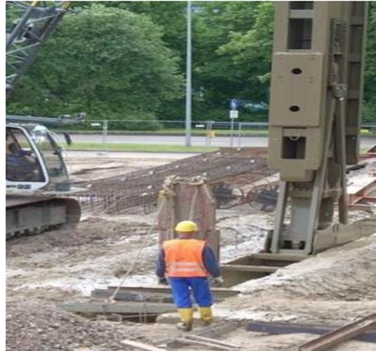
**Bild 3:** Greiferaushub Schlitzwand
