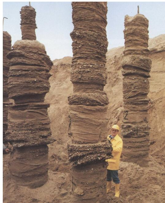
**Bild 2:** Ausgegrabene DSV-Säulen
