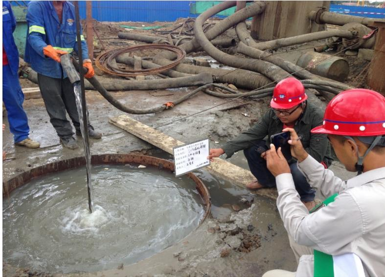
Bild 10: Neigungsmessung mit Kaliberkorb
