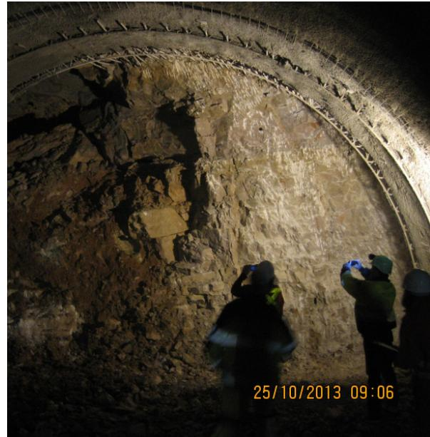
Bild 18: Beispiele von angetroffenen Karststrukturen beim Steinbühl tunnel, offen und mit Schutt gefüllt
