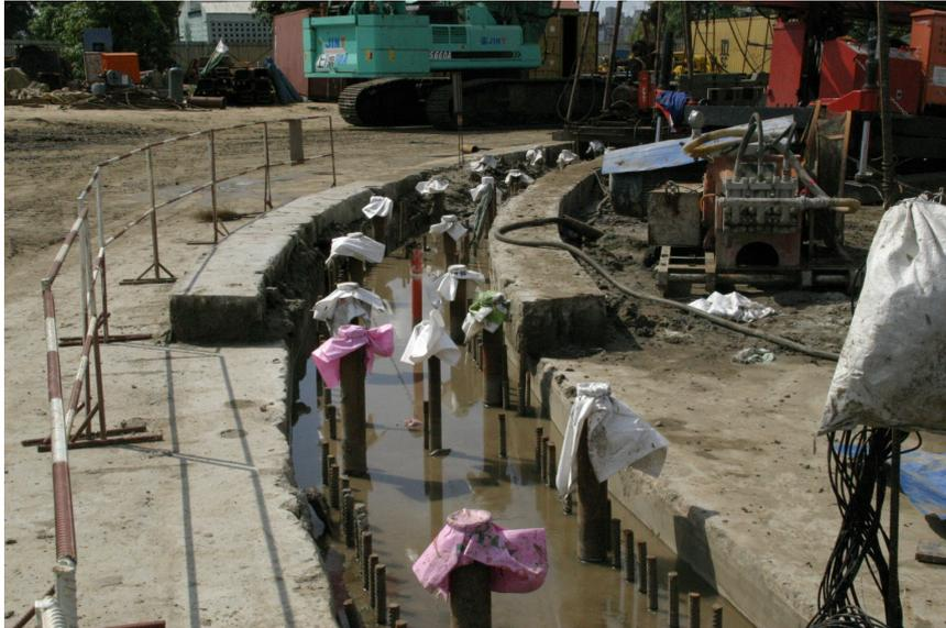
Bild 5: Messrohre für die „CSL“ Prüfung in der Schlitzwand
