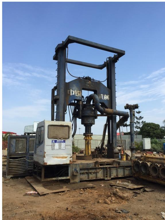
Bild 9: Pfahlherstellung - Lufthebebohrverfahren
