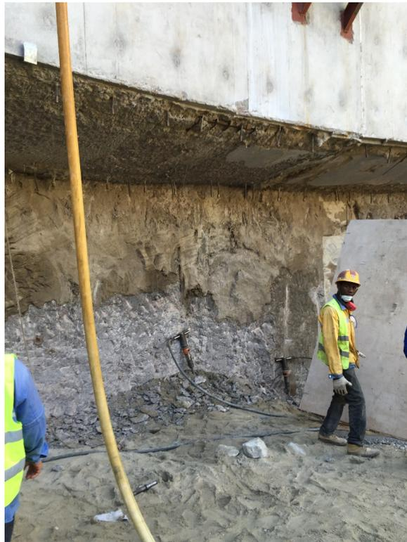
Bild 7: Schlitzwand in ca. 20 m Tiefe – oberhalb ist der eingebaute Aussteifungsring sichtbar
