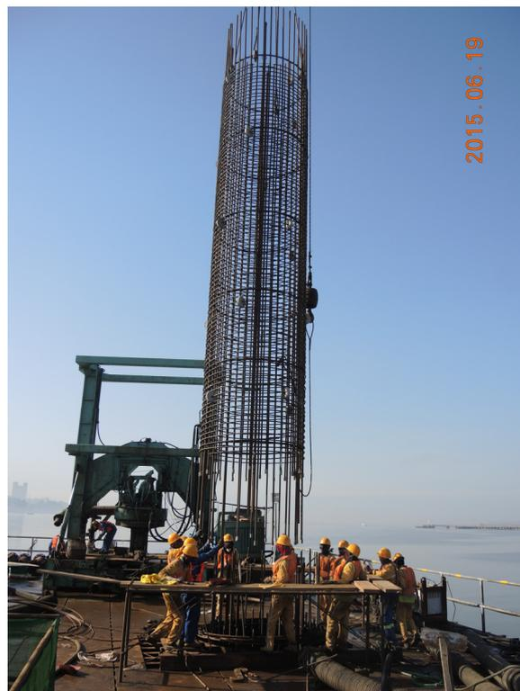
Bild 11: Einbau Pfahlbewehrungskorb am Südpylon
