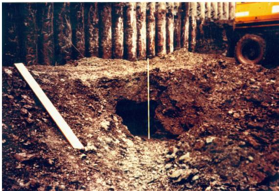
Bild 1: Karsthohlraum in Tonsteinen des Gipskeupers (Stuttgart)
