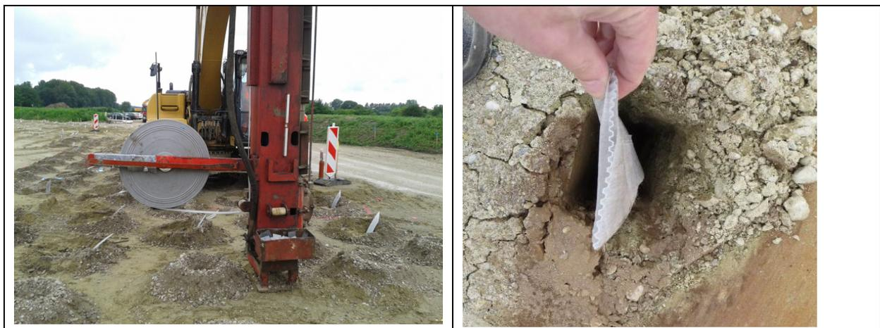
Abbildung 6 Ausführung Vertikaldräns Westtangente Freising
