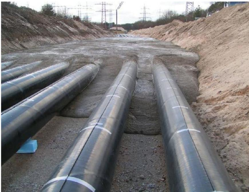
Bild 8: Eingießen des ZFSV um die erdverlegte AC-GiL beim Projekt Frankfurt–Kelsterbach; Quelle: Siemens AG.
