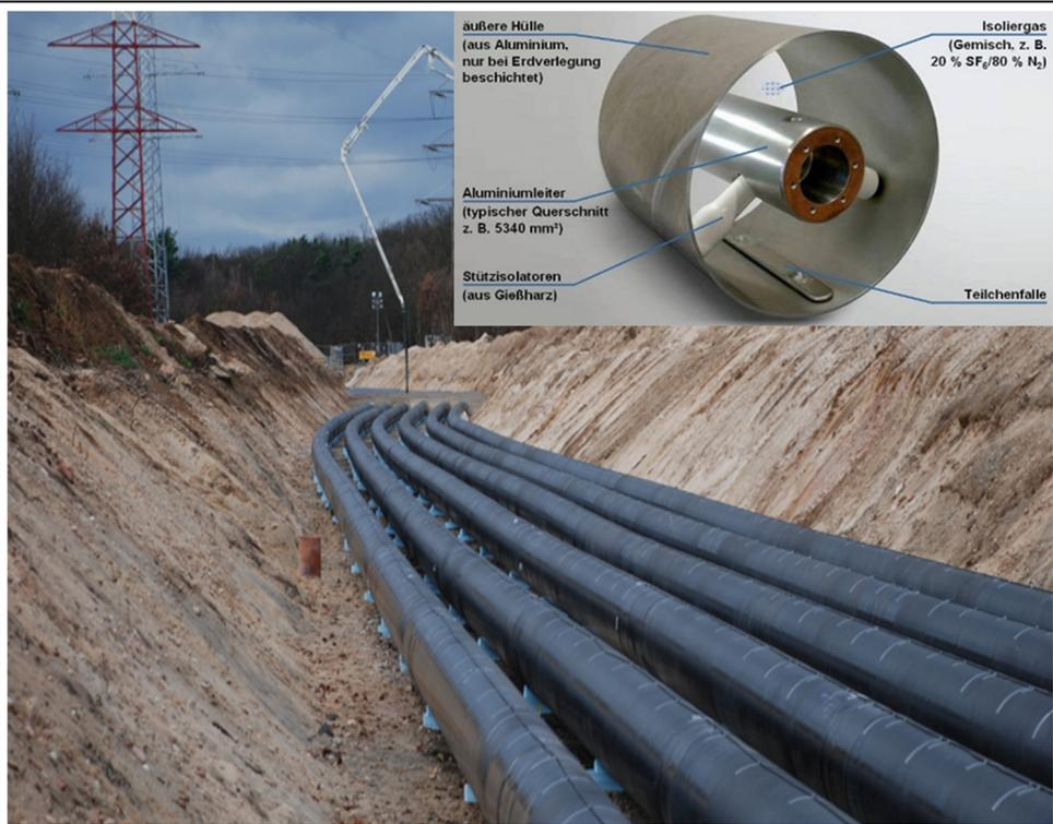
Bild 5: Erdverlegte gasisolierte Leiter (AC-GiL) beim Projekt Frankfurt –Kelsterbach; Quelle: Siemens AG.
