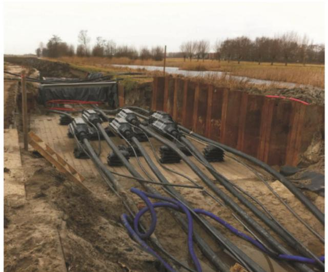
Bild 4: Links: Kabeltrommeln mit Erdkabeln. Rechts: Muffenverbindungen von Erdkabeln. Quelle: Jungnitz, Amprion GmbH, Dortmund
