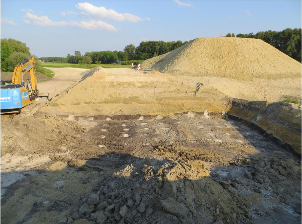
*Abbildung 8 10 m Überlastschüttung im Bereich Brückenanrampung (vorne im Bild bereits wieder freigelegte RSV nach Rückbau Überlastschüttung)*
