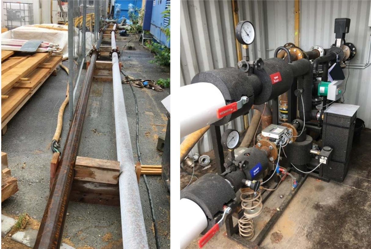
*Bild 23: Aktives Auftauen – Rücklaufleitung mit Rauhreifüberzug (li.) / Wärmetauscher (re.)*
