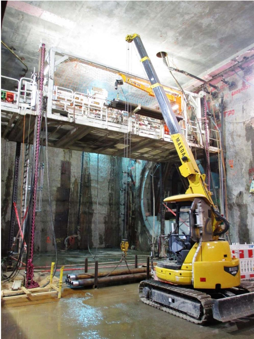
*Bild 7: Richtbohranlage zur Einbringung der Gefrierrohre*
