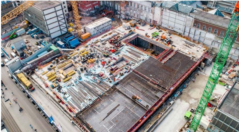
**Abbildung 5.** Drohnenaufnahme Baufeld Zentraler Aufgang Hauptbahnhof München – Herstellung Decke über Ebene -1 [DB/panterra.tv]
