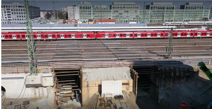
**Abbildung 3.** Aushub und Herstellung Widerlagerwände für UVR-Süd unter Hilfsbrücken [DB/ARGE VE10]
