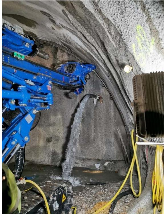
Abbildung 8: (a) Bohren eines Vertikalbrunnens; (b) Steigende Drainagebohrung aus dem Anfahrbereich des Bergsturzes
