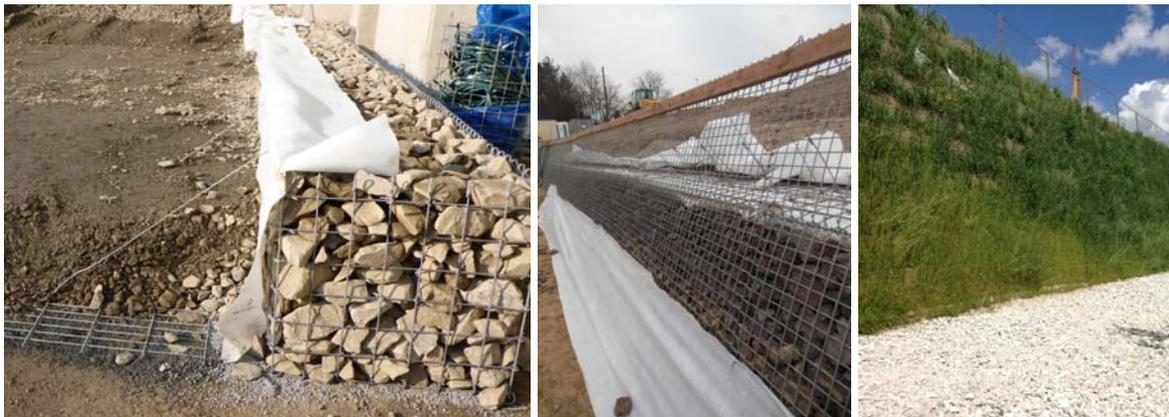
*Bild 2: Abschlusselemente aus Gabionen und Stahlgittermatten sowie Begrünung*
