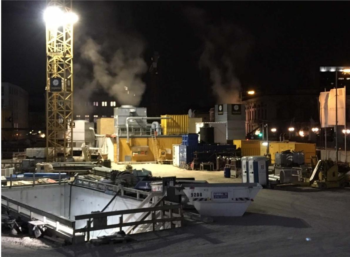
*Bild 11: Ansicht der 3 Gefrieranlagen mit Nebenaggregaten*
