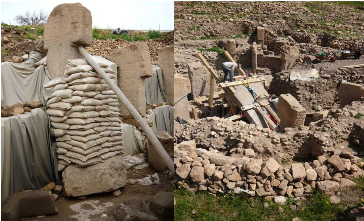
**Bild 5a/ 5b:** Sicherung Randpfeiler – Sanierung gebrochener Zentralpfeiler (geklebt/verdünelt und aufgerichtet) in der Anlage C
