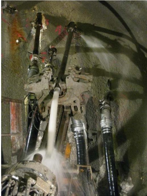
*Abbildung 3: Drainagebohrung gegen 5 bar Wasserdruck*
