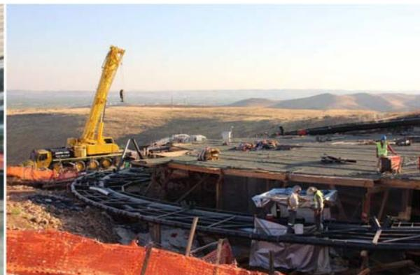
**Bild 47-48:** Vorfertigung und Montage Schutzdach 1
