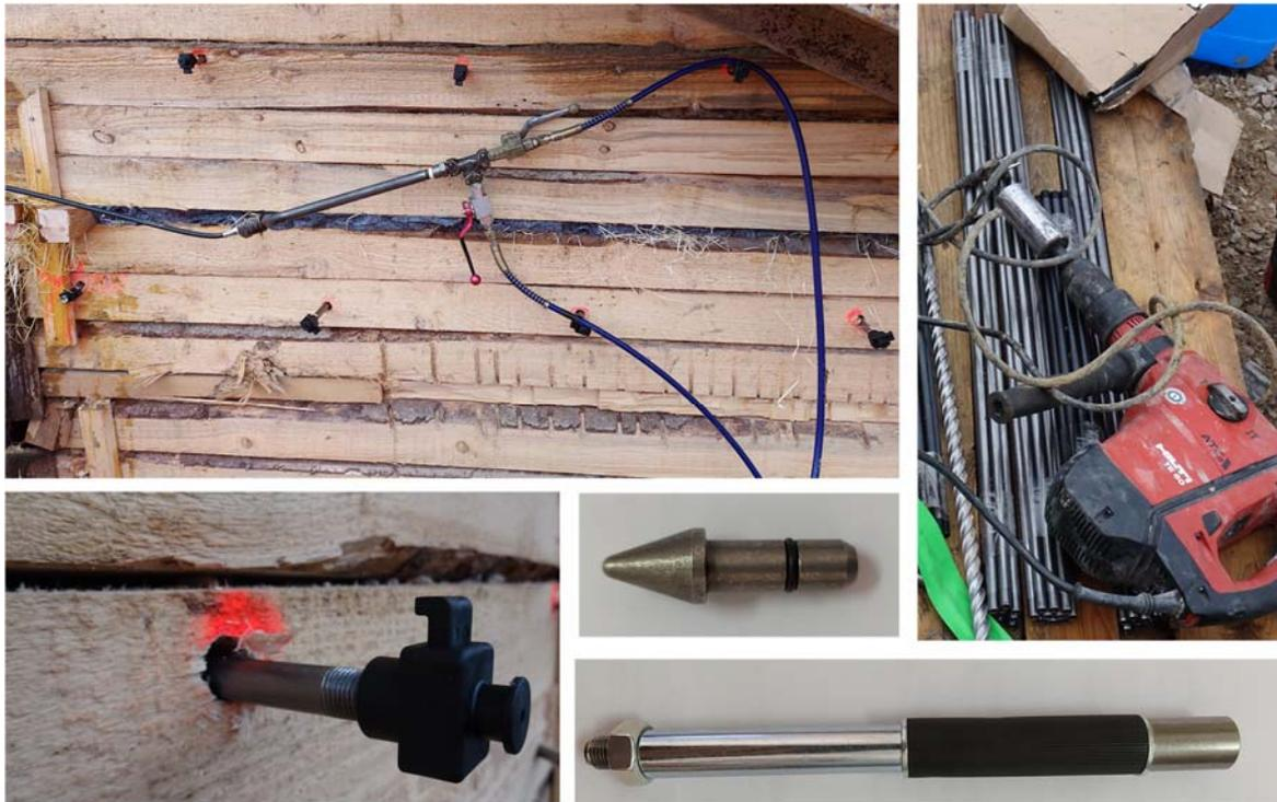
Bild 10: Beispiel einer Silikatschauminjektionen zur Verkittung von Rollkieslagen beim Trägerbohlwandverbau
