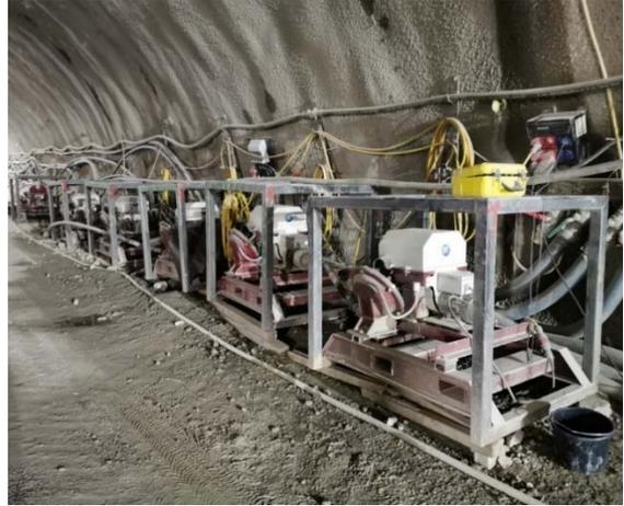
Abbildung 7: (a) Entwässerungsbohrung; (b) Membrankolbenpumpen
