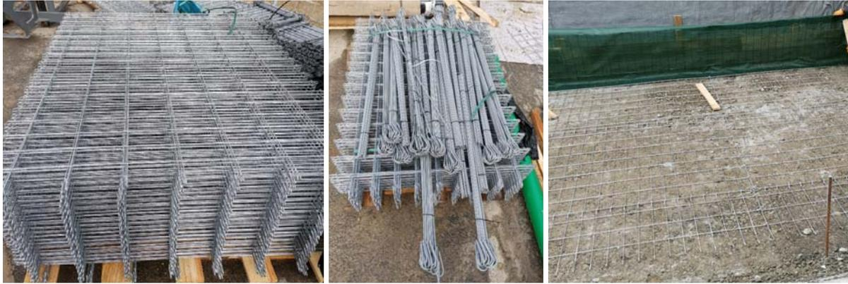
*Bild 1: Stahlgitterbewehrung aus geschweißten Matten und Steckverbindern*
