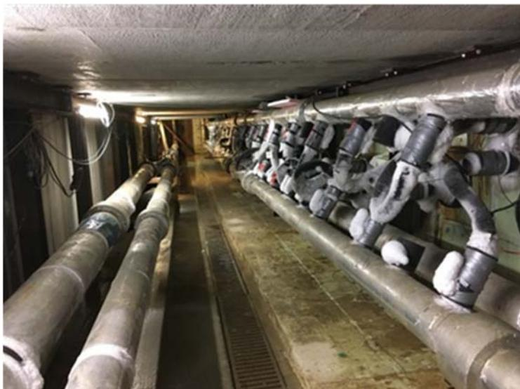
Bild 13: Verteiler mit Anschluss der Gefrierlanzen
