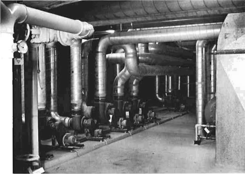
Bild 25 Luftabsauganlage
