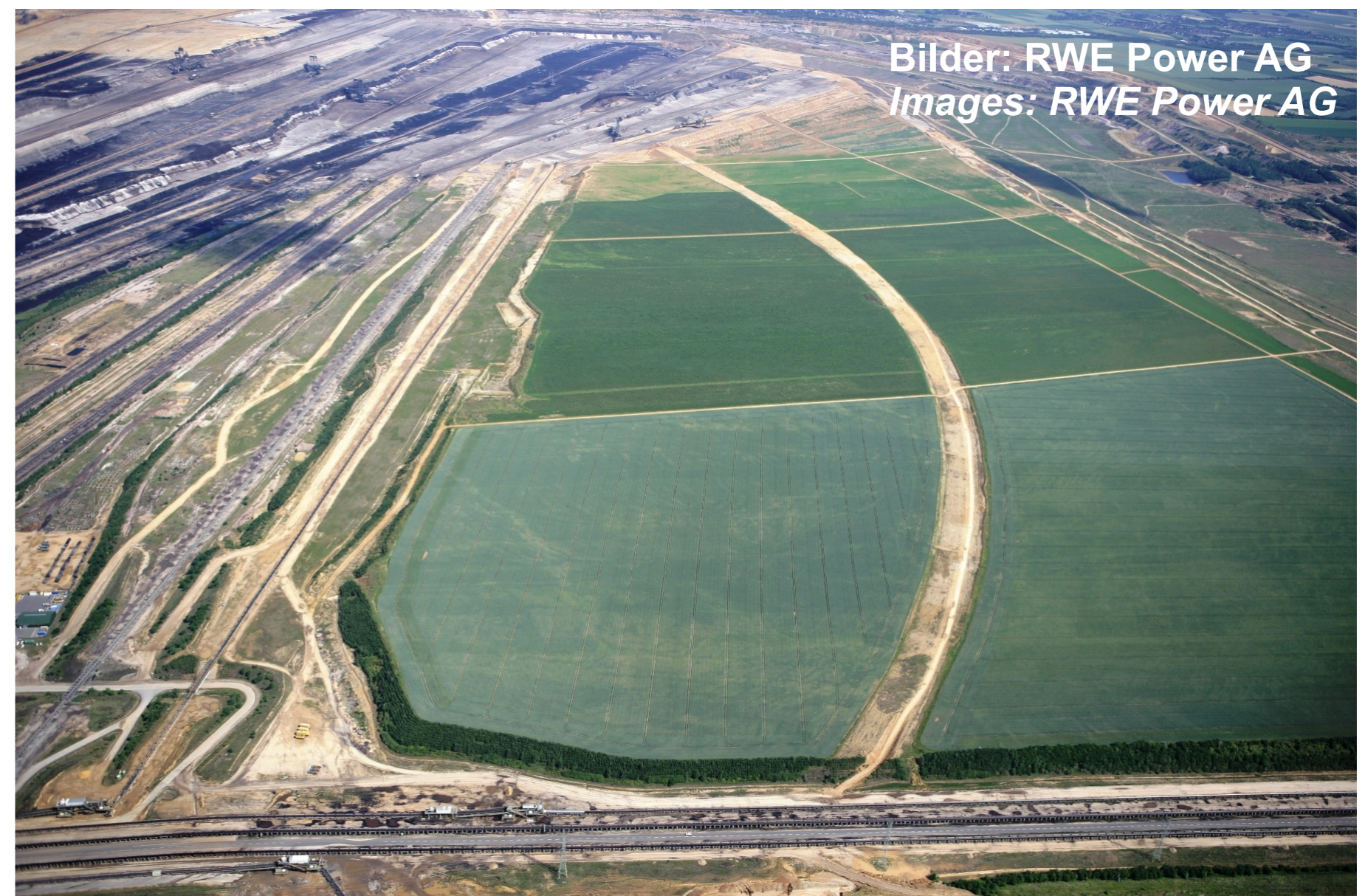
In Bau befindliche Autobahn im Bereich der Innenkippe des Tagebau Garzweiler Motorway under construction on the dump of the Garzweiler open cast mine
