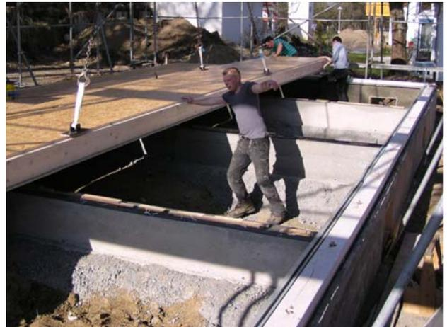
Abb. 2 Verlegung einer Holzbodenplatte über Kriechkeller mit Streifenfundament
