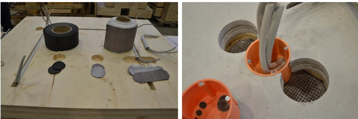
Abbildung 3-21 Einbau von intumeszierenden Brandschutzmaterialien
