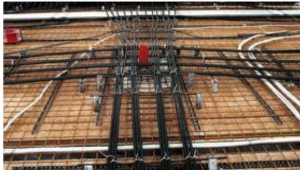
Abbildung 3-9: Flachdecke mit verbundloser Vorspannung (Suspa DSI, o.J.)
