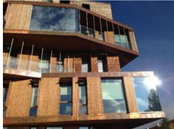
Abb. 2 Mehrgeschossige, urbane Holzbauten haben komplexe Anforderungen an Fassaden
