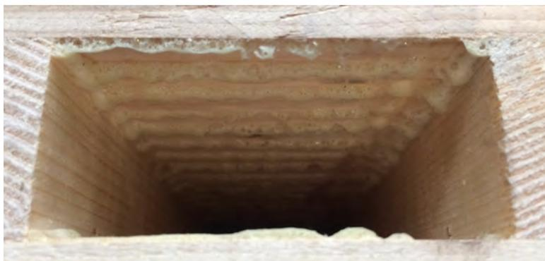
**Abbildung 2.5:** Spannkanal mit sichtbaren Klebstoffanhaftungen
