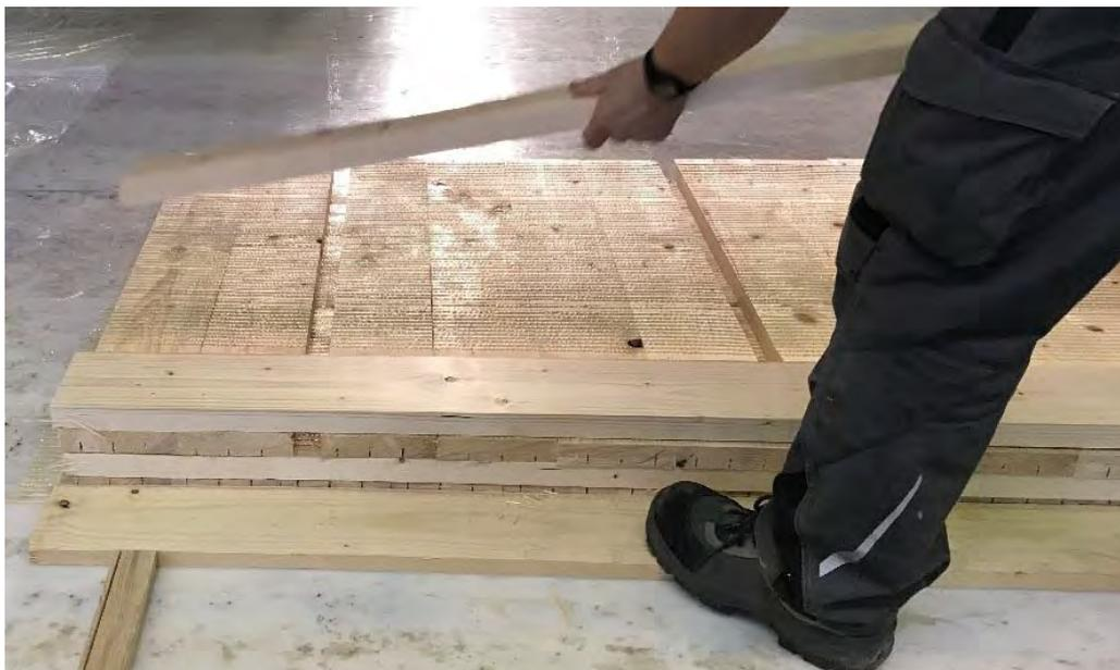
**Abbildung 2.7:** Verlegen der zweiten Querlage, Abstandhalter in der Mittellage entfernt
