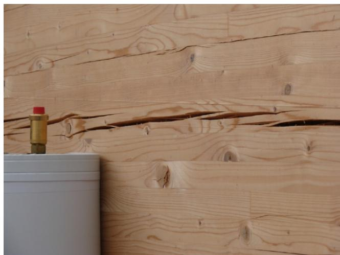
Abbildung 2: Rissbildung in einem verstärktem Brettschichtholzträger infolge Schwindens
