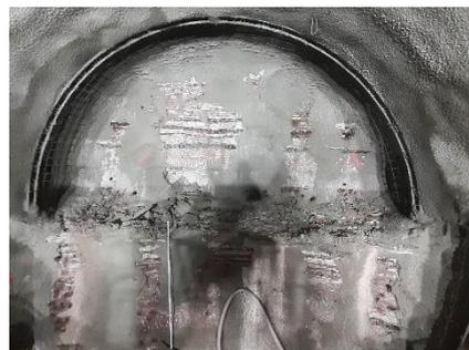
*Abbildung 1: Tunnelvortrieb in Spritzbetonbauweise; Sicherung durch Außenschale aus Spritzbeton; links: Tunnel bei Rothenstein; rechts: Kanalunterquerung U3 in Nürnberg.*
