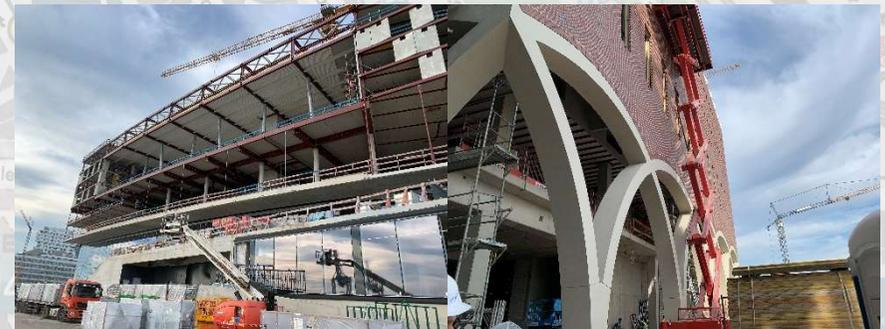
Besondere technische Herausforderungen waren unter anderem auch ein großes Schwimmbecken im Obergeschoss eines Hotels, infolgedessen ein zwei Stockwerke hohes, 62 m langes Fachwerk geplant wurde, um die Lasten abzutragen. Außerdem ragte die Rückverankerung der Kaimauer zu Beginn der Bauarbeiten so tief in die Baustelle, dass es mit den Bohrpfehlen des Hochhauses C kollidierte, weshalb die Kaimauer saniert werden musste.
