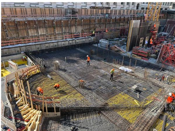
Abbildung 13: Aktueller Bauzustand, Bewehren einer Decke
