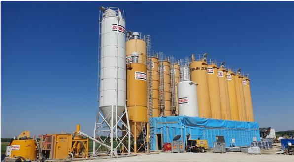
Abbildung 3 Betonmischanlage
