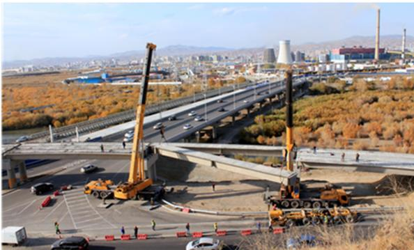
**Abb. 6:** Kranmontage der Überbaufertigteile für die Flyover-Brücke
