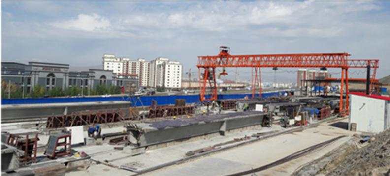
**Abb. 7:** Feldfabrik für die Herstellung der Spannbeton-Fertigteilträger
