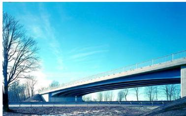
**Abb. 1:** Integrale Rahmenbrücke in Verbundbauweise
