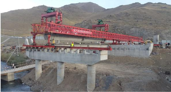
**Abb. 5:** Brückenmontagegerät auf dem Hauptbauwerk
